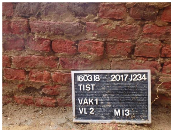
Figuur 58: Muur M13 + detailfoto: kruisverband (ARCHEBO bvba, 2018)
