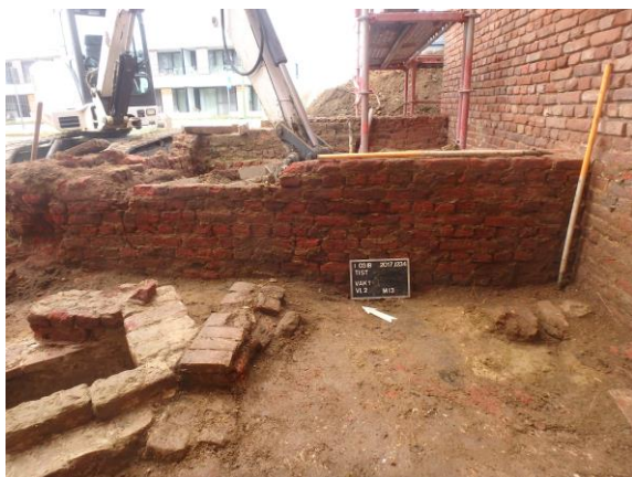
Figuur 58: Muur M13 + detailfoto: kruisverband (ARCHEBO bvba, 2018)
