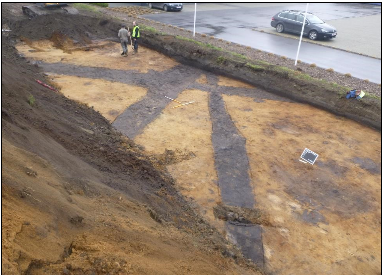
Figuur 83: Aanleg van Werkput 2 gezien vanuit het zuidwesten (ABO nv 2018)
