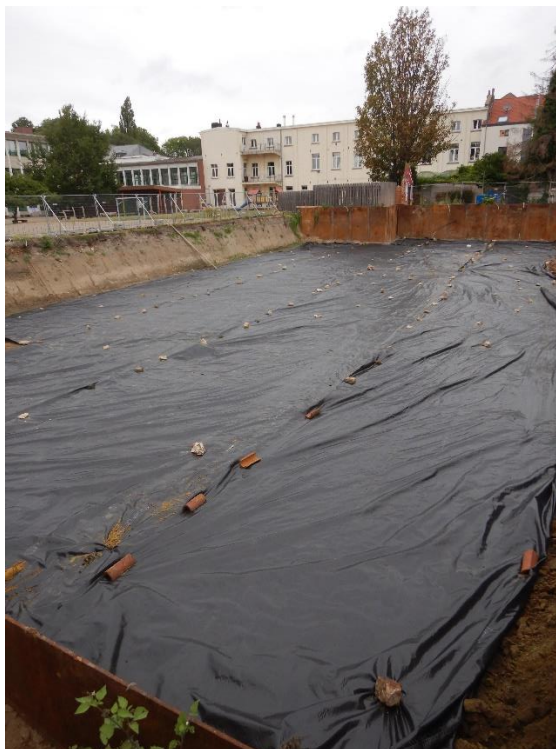
Figuur 59: Vlak 3 afgedekt met geotextiel (© ARCHEBO bvba, 2019).
