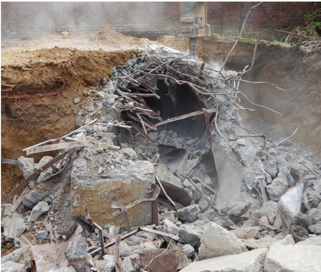
Figuur 61: Sloop van de schuilkelder (ARCHEBO bvba, 2018).
