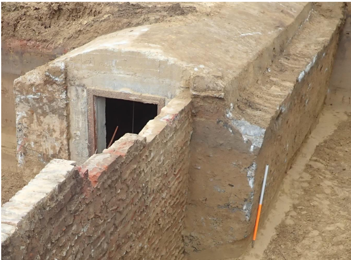
Figuur 59: Enkel de buitenzijden van de betonnen structuur werden niet bekist (ARCHEBO bvba, 2018).
