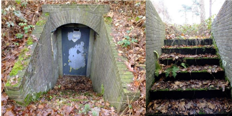
Figuur 66: Zicht op de trap en toegangsdeur van de schuilbunker in Soesterberg ( www.bunkerinfo.nl ).
