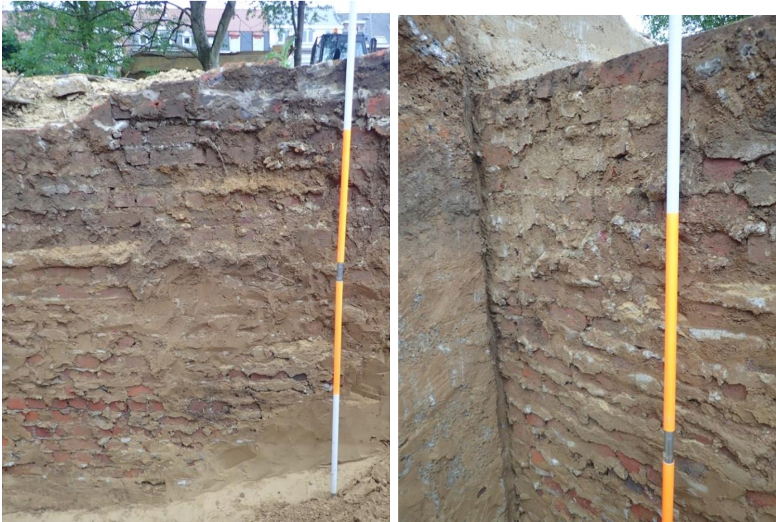
Figuur 58: Cementresten werden op de achterkant van de muren niet verwijderd (ARCHEBO bvba, 2018).
