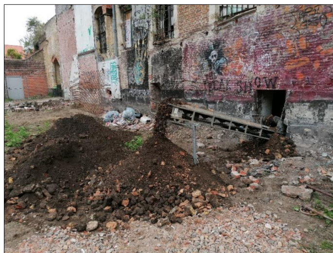
Figuur 5: Uitgegraven grond gaat via transportband naar buiten.
