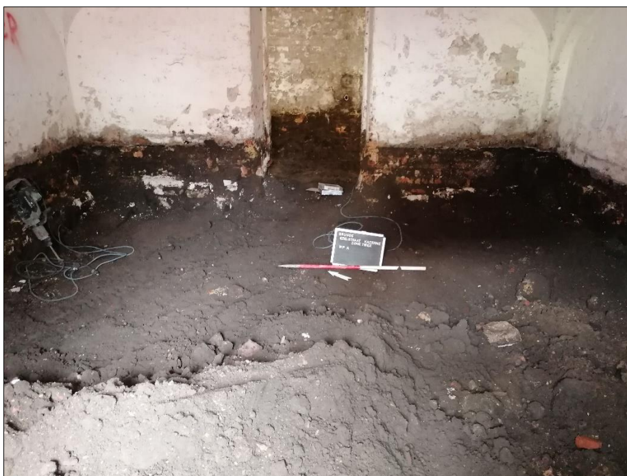
Figuur 9: Zicht binnen één van de afgegraven ruimtes.
