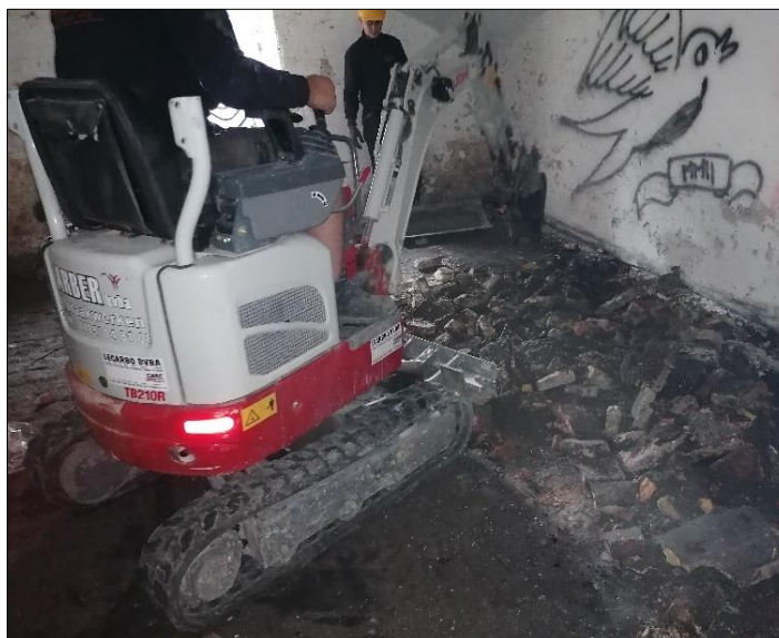
Figuur 4: Uitvoering van het afgraven binnen de kelderruimtes met een minigraver.
