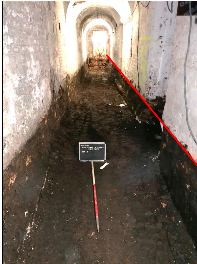
Figuur 2: Zicht op één van de afgegraven gangen. De rode lijn geeft het oude vloerniveau weer.
