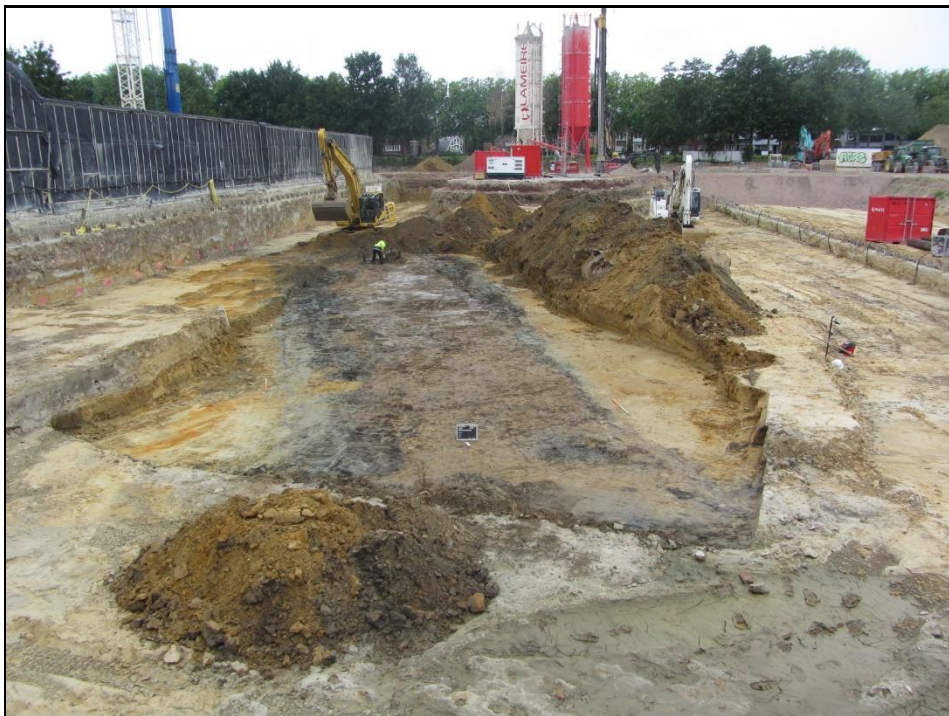
Figuur 9: Zicht op werkput 1, vanuit het noorden
