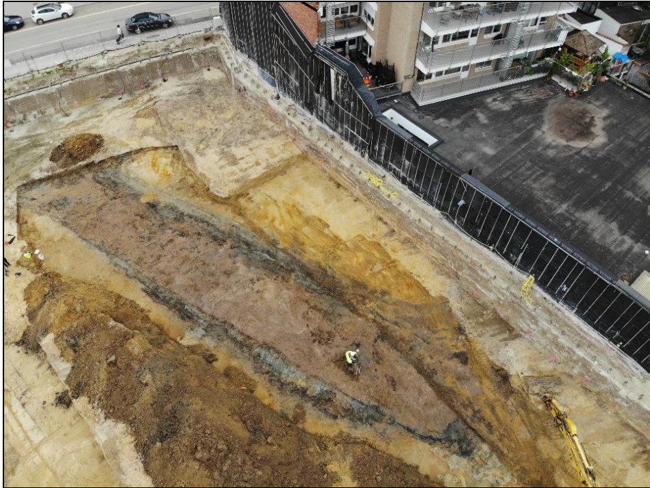
Figuur 8: Overzichtsfoto van werkput 1 met drone (Bron: Initiatiefnemer 2020)
