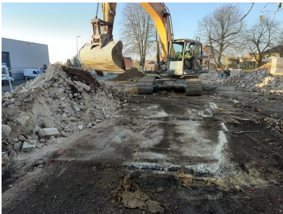
Afb. 4. Het verwijderen van een bodemplaat.
