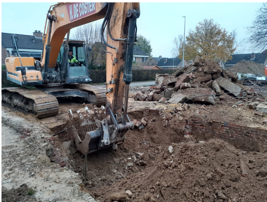
Afb. 5. Sfeerbeeld van het slopen van de funderingen met een puinbak.
