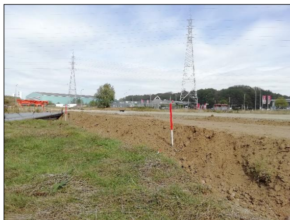
Figuur 7: Foto's van de westelijke rand van de zone voor behoud in situ; links na afgraving graszoden, rechts na aanbrengen ophoging
