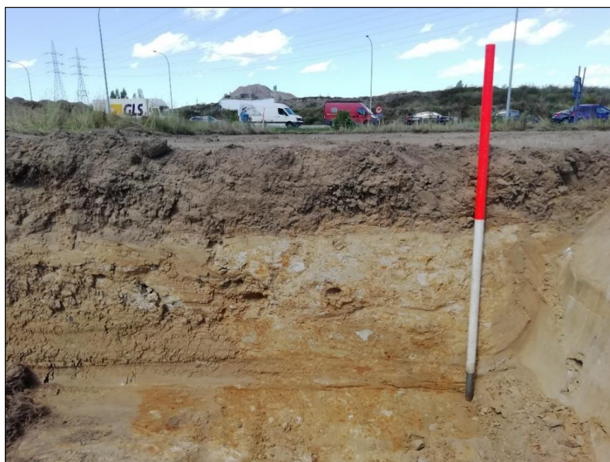
Figuur 9: Profielput in het noordelijke deel van de zone voor behoud in situ (Merksemsebaan); 20 cm teelaarde dekt ophoginslag af
