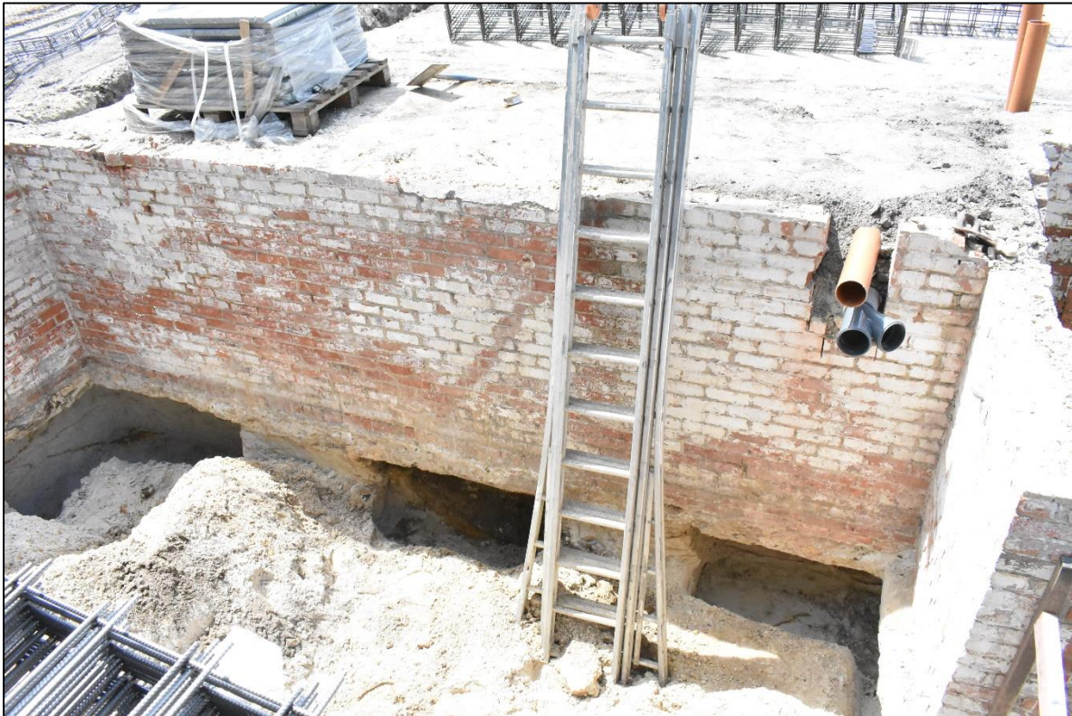
Afb. 46: Bewaarde kelderruimte 1 met ondergraven baksteenmuren en een vergraven restant van spoor S15.
