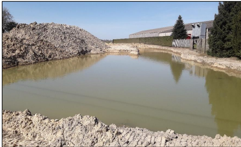
Figuur 3: Zicht op werkput 1 en 4 (ter hoogte van de poelen) voor het plaatsen van de bemaling.
