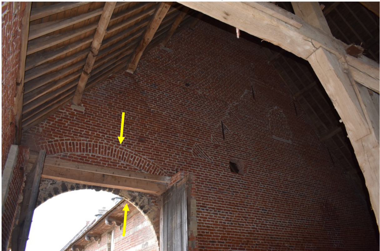
Fig. 3.49: Dubbele ontlastingsboog.
