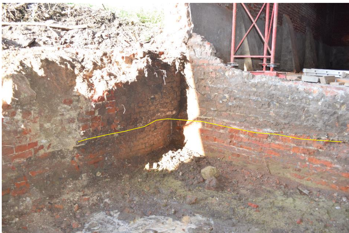
Fig. 3.44: Oudere muur ter hoogte van spant 4 (onder gele lijn): noordzijde.
