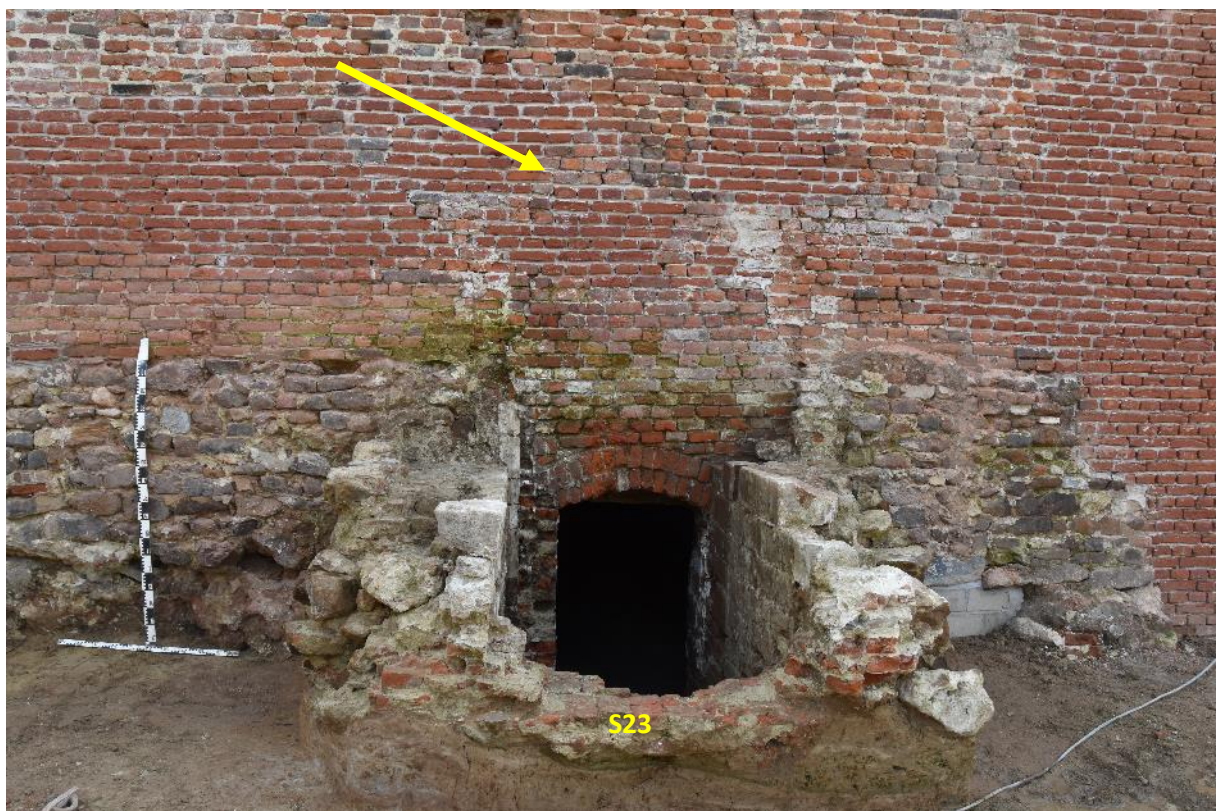
Fig. 3.39: Deur met bouwnaad.
