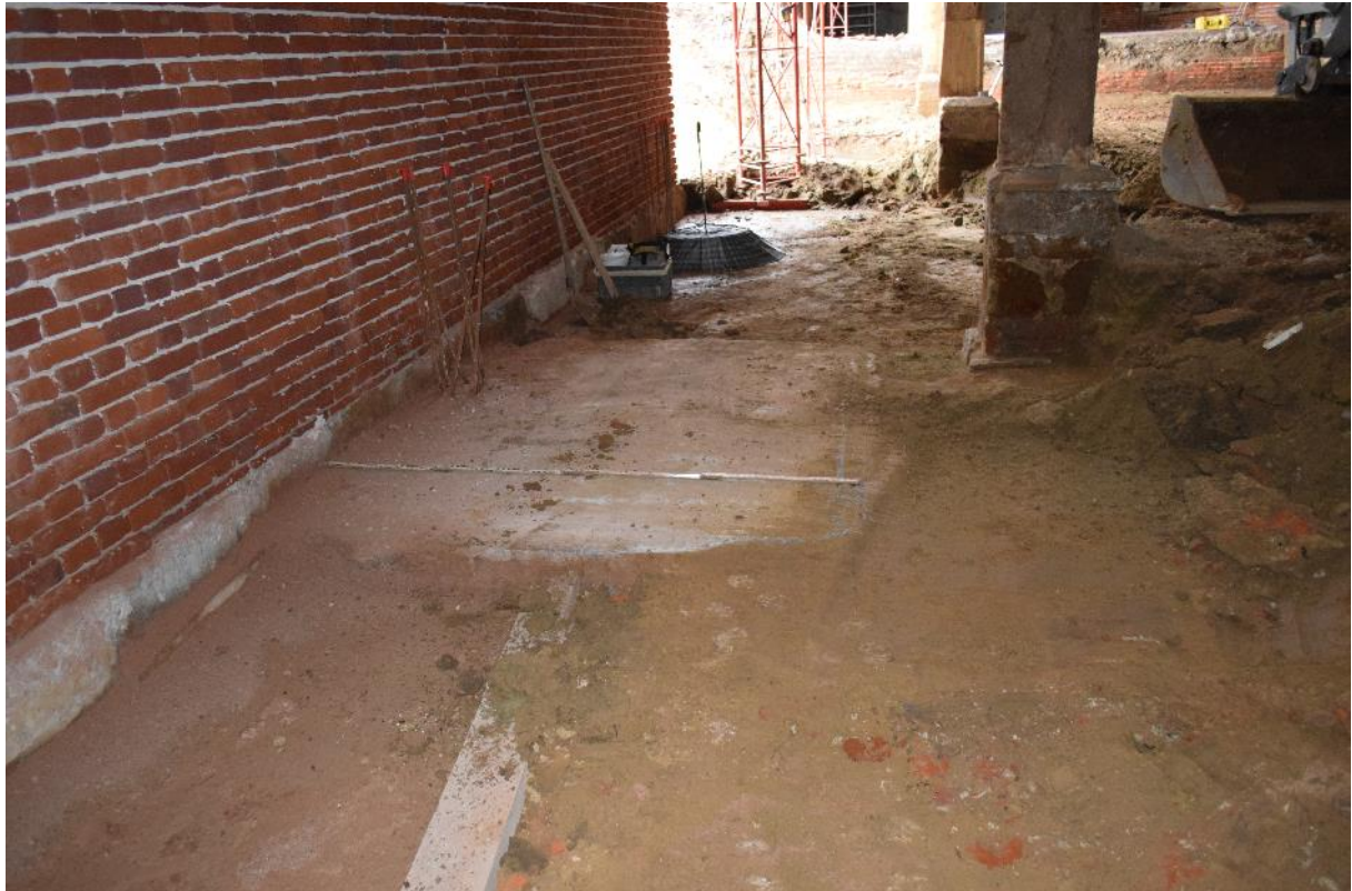
Fig. 3.52: Betonplaat in noordwestelijke zone van meest oostelijke ruimte van tiendenshuur.
