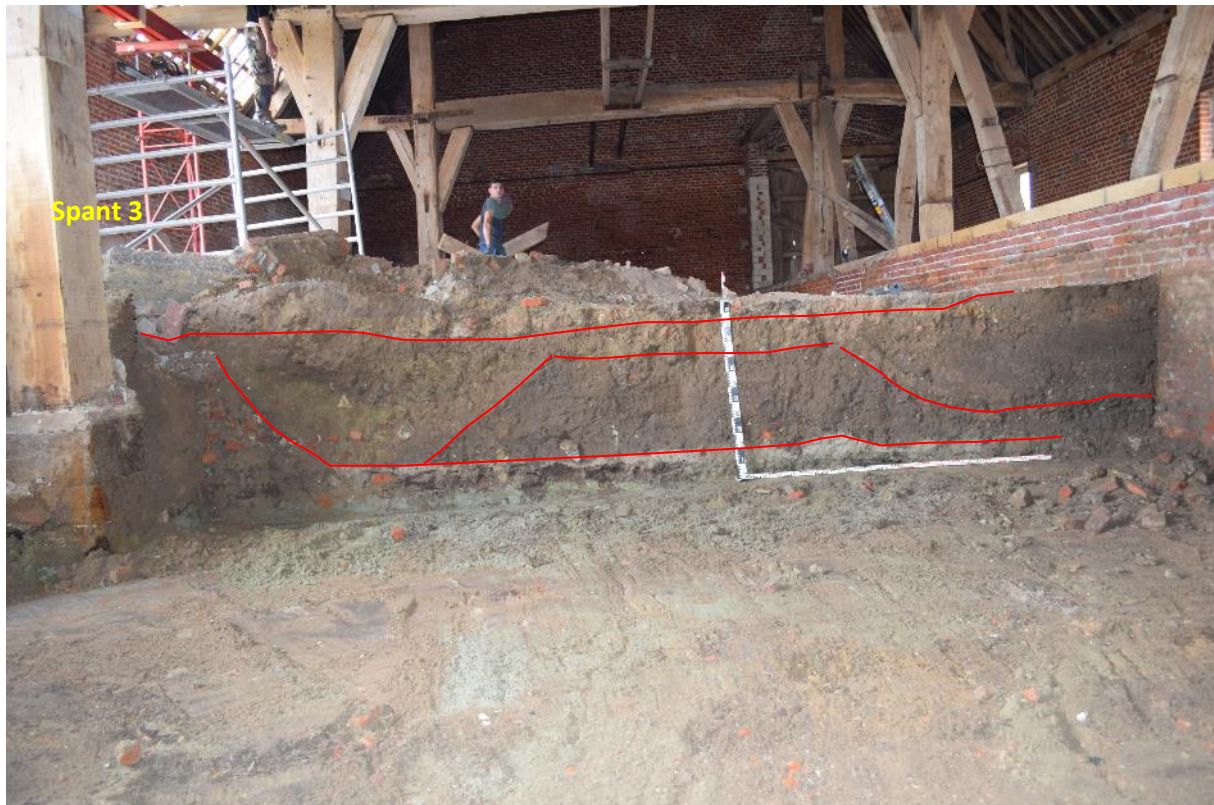
Fig. 3.42: Opgeschoond profiel ter hoogte van spant 3.
