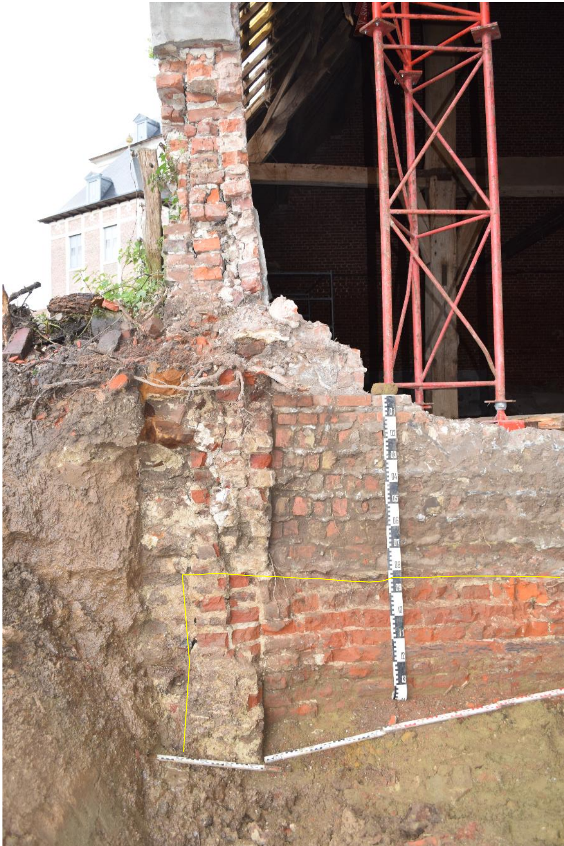
Fig. 3.45: Oudere muur ter hoogte van spant 4 (onder gele lijn): noordzijde.
