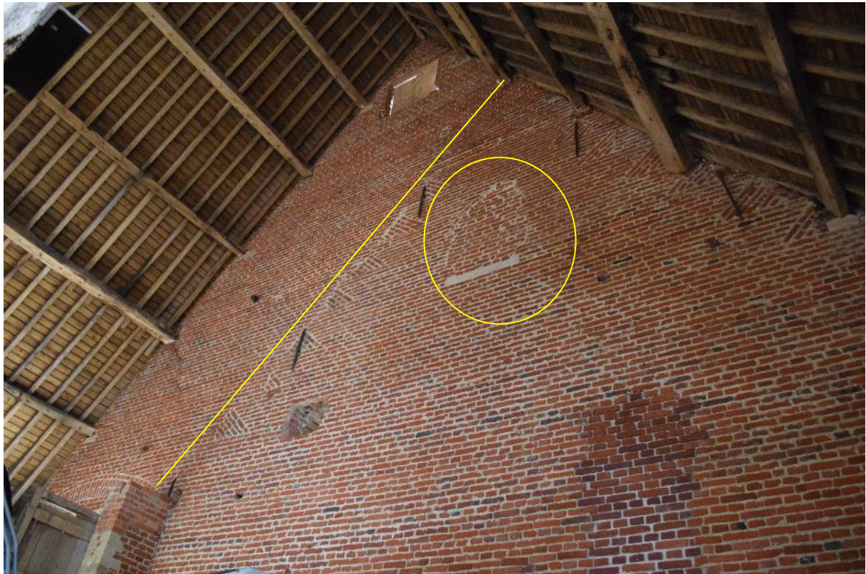
Fig. 3.48: Detail oudere daklijn en raam.
