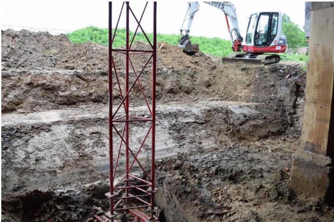
Fig. 3.51: afgraven grond in functie van heropbouw noordelijke buitengevel.
