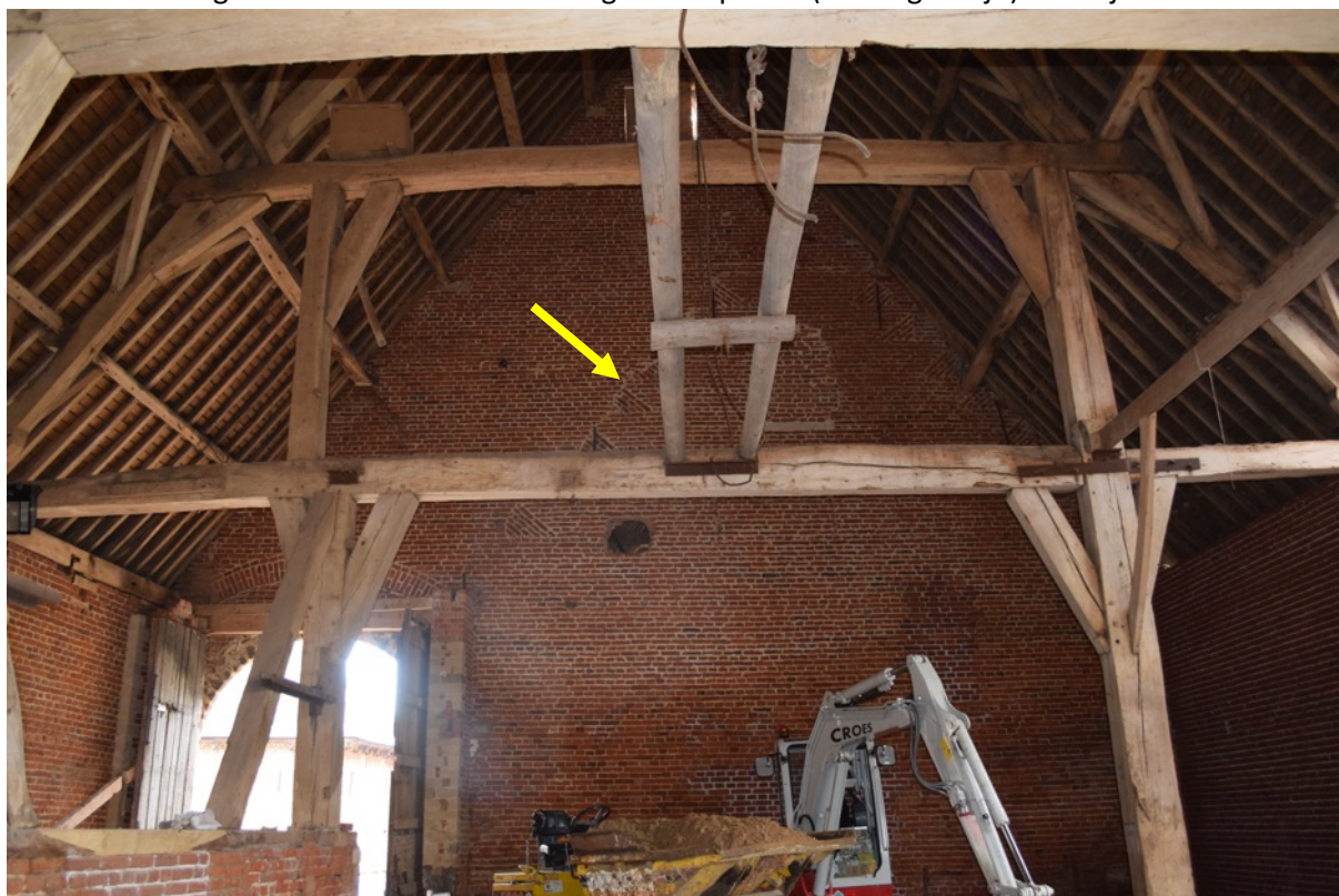
Fig. 3.47: Westelijke binnengevel schuur met oudere daklijn.
