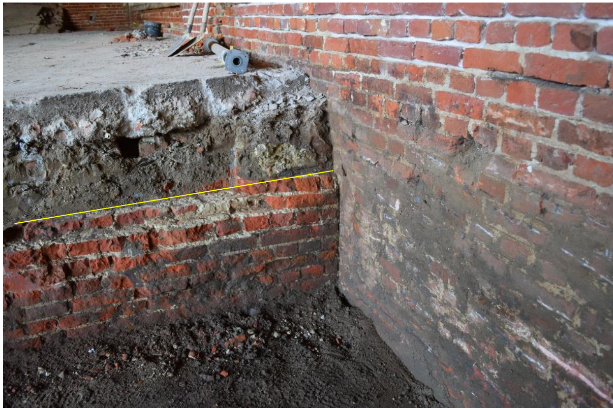
Fig. 3.46: Oudere muur ter hoogte van spant 4 (onder gele lijn): zuidzijde.
