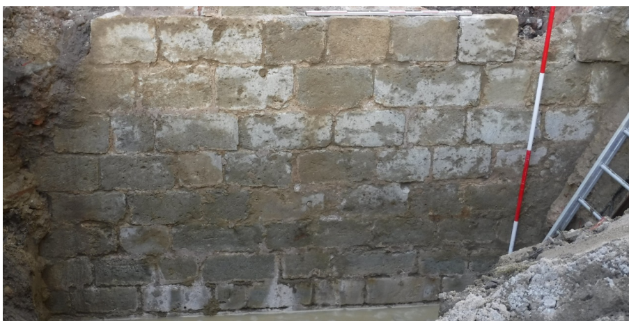
Figuur 11: Het goed bewaarde natuurstenen parement van de stadsmuur. Links op de foto is de versterking te zien van de oude riool. (© dienst archeologie van de stad Antwerpen)
