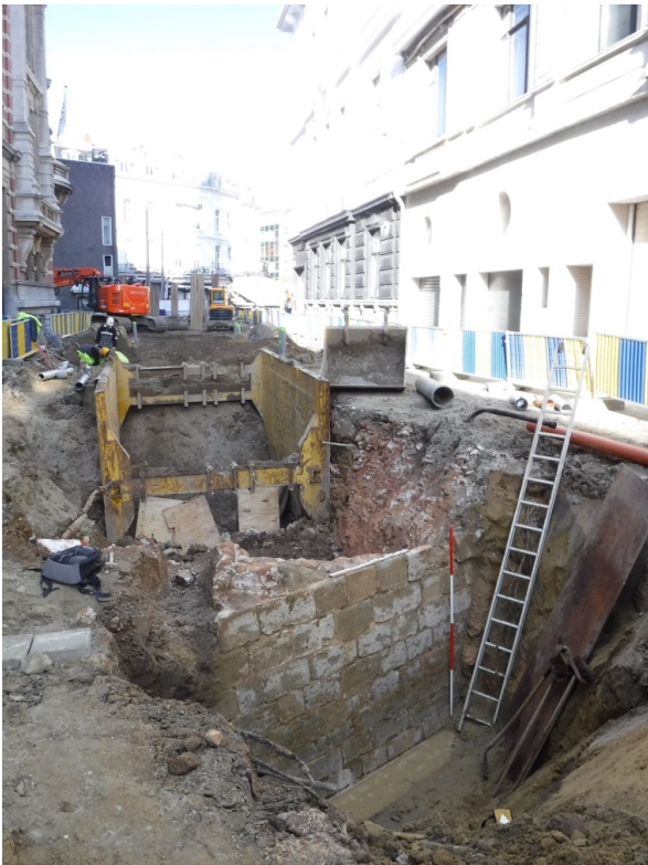
Figuur 3: Overzicht van de aangelegde werkput met de voorzijde van het geregistreerde muursegment. (© dienst archeologie van de stad Antwerpen)
