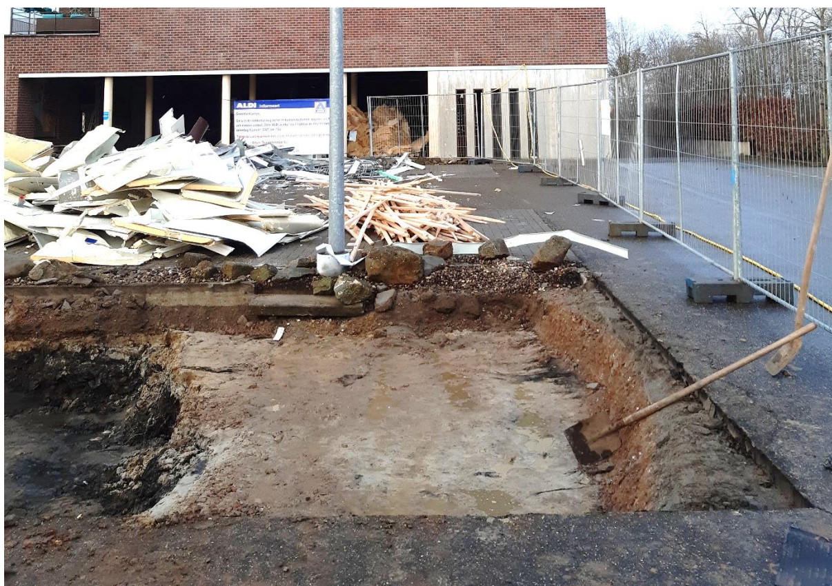
Figuur 6: Detail recente verstoring t.h.v. een lantaarnpaal in het noorden van de werkput (18.01.2021).
