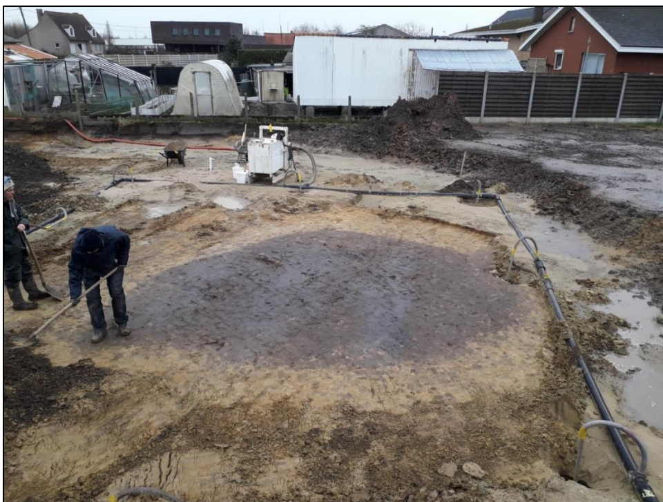
Figuur 28: Aanleg vlak 2 in werkput 7 na de installatie van de bemaling gezien uit N
