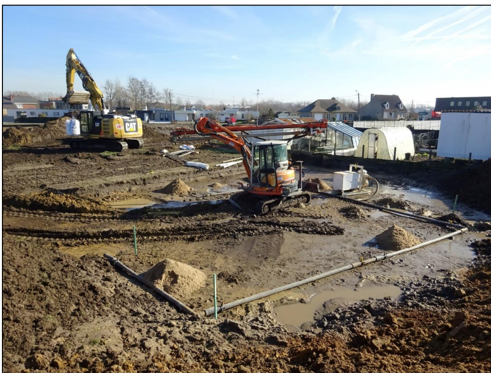
Figuur 27: Installatie bemalingskader in werkput 7 gezien uit NW (foto RADAR) 35
