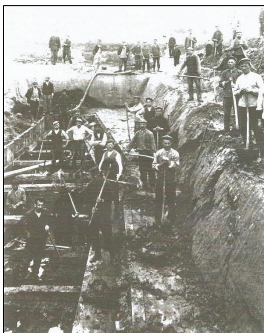
Figuur 63: Graafwerken voor het Fort van Lievele – in Breendonk verliep het vermoedelijk gelijkaardig. 64
