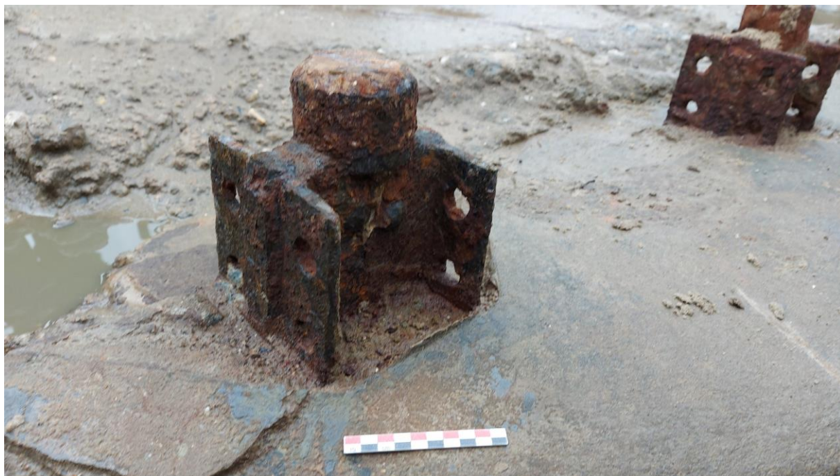
Figuur 52: Detail van de metalen verankering van het geschut aan het betonnen platform.
