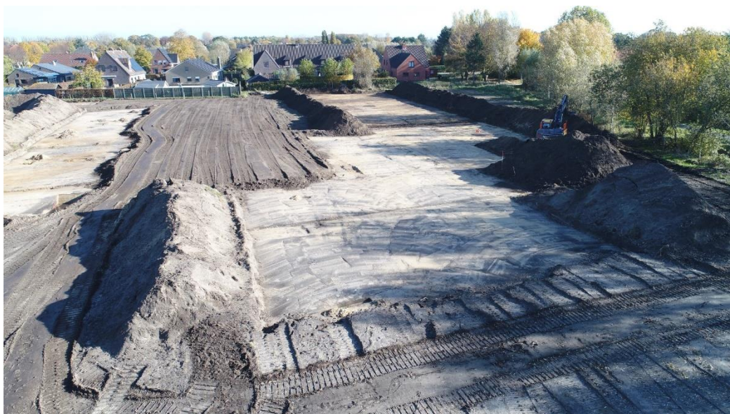
Figuur 117: dronefoto overzicht werkputten 27 en 30
