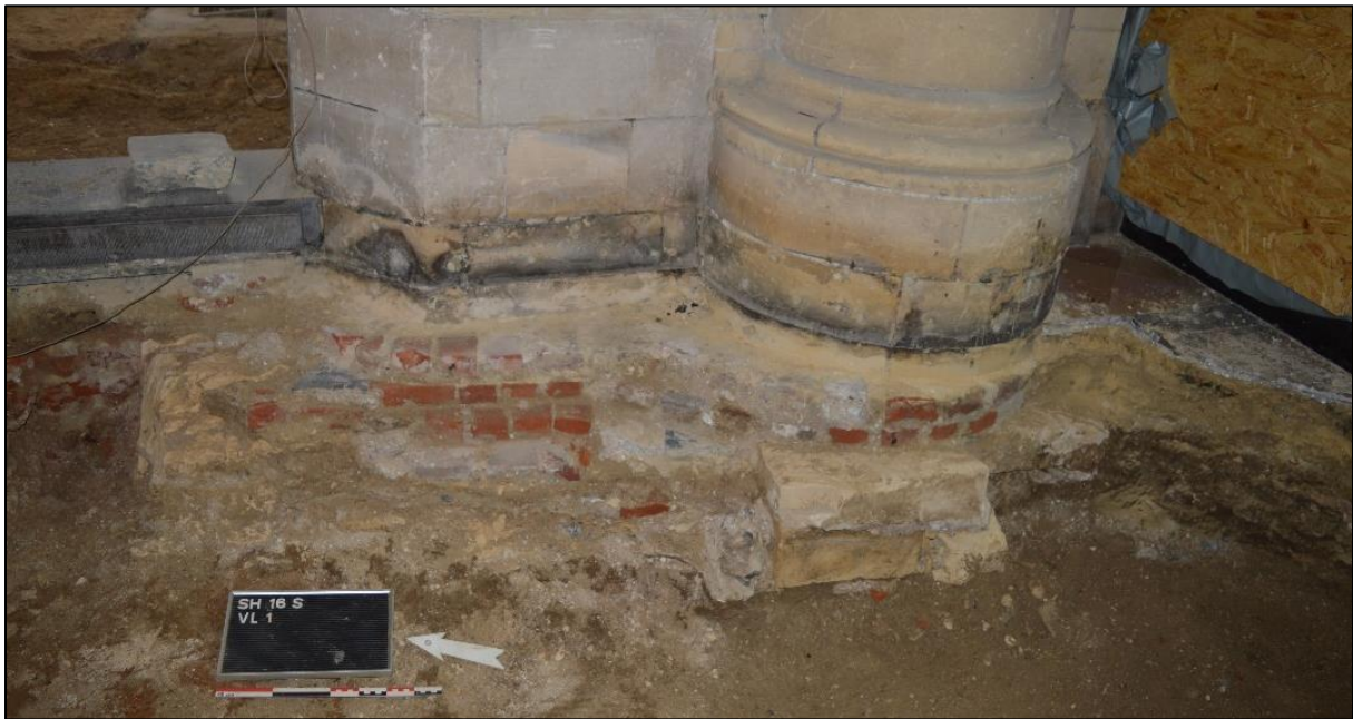
Afb. 42: Zicht op de fundering onder de zuidelijke pijler ter hoogte van het koor (S25) VL1 (Bron: ARON bvba, dd. 28/07/2016, 2016F159).
