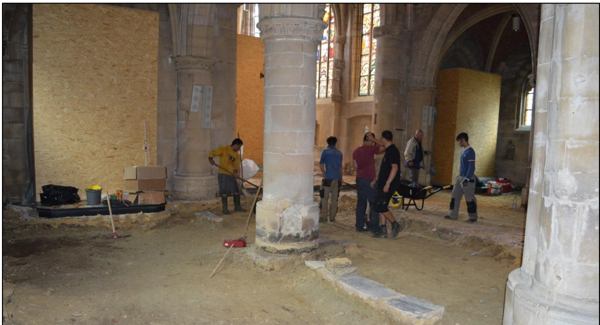
Afb. 3. Zicht op het opgraven van de stabilisélagen (ARON bvba, dd 14/07/2016, 2016F195).
