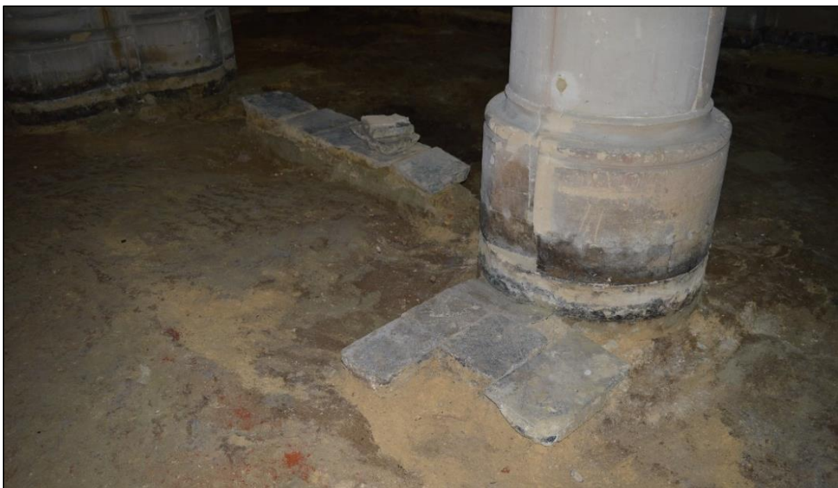
Afb. 41: Zicht op delen van de bewaarde vloer (S23) en de fundering onder een van de pijlers (S29) na aanleg VL1 (Bron: ARON bvba, dd. 28/07/2016, 2016F159).
