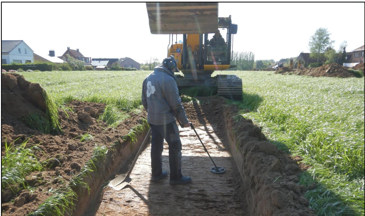
Figuur 5 Metaaldetectie in het teelaardepakket bij het uitgraven van de proefsleuven.
