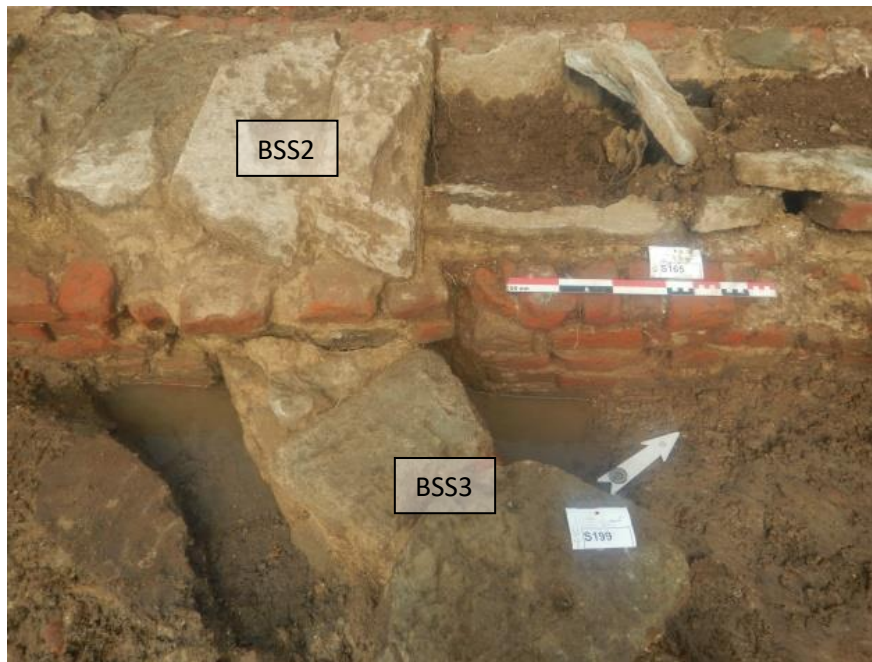
Figuur 62. Detailfoto van afwateringskanaal BSS3, dat afwatert in kanaal BSS2.
