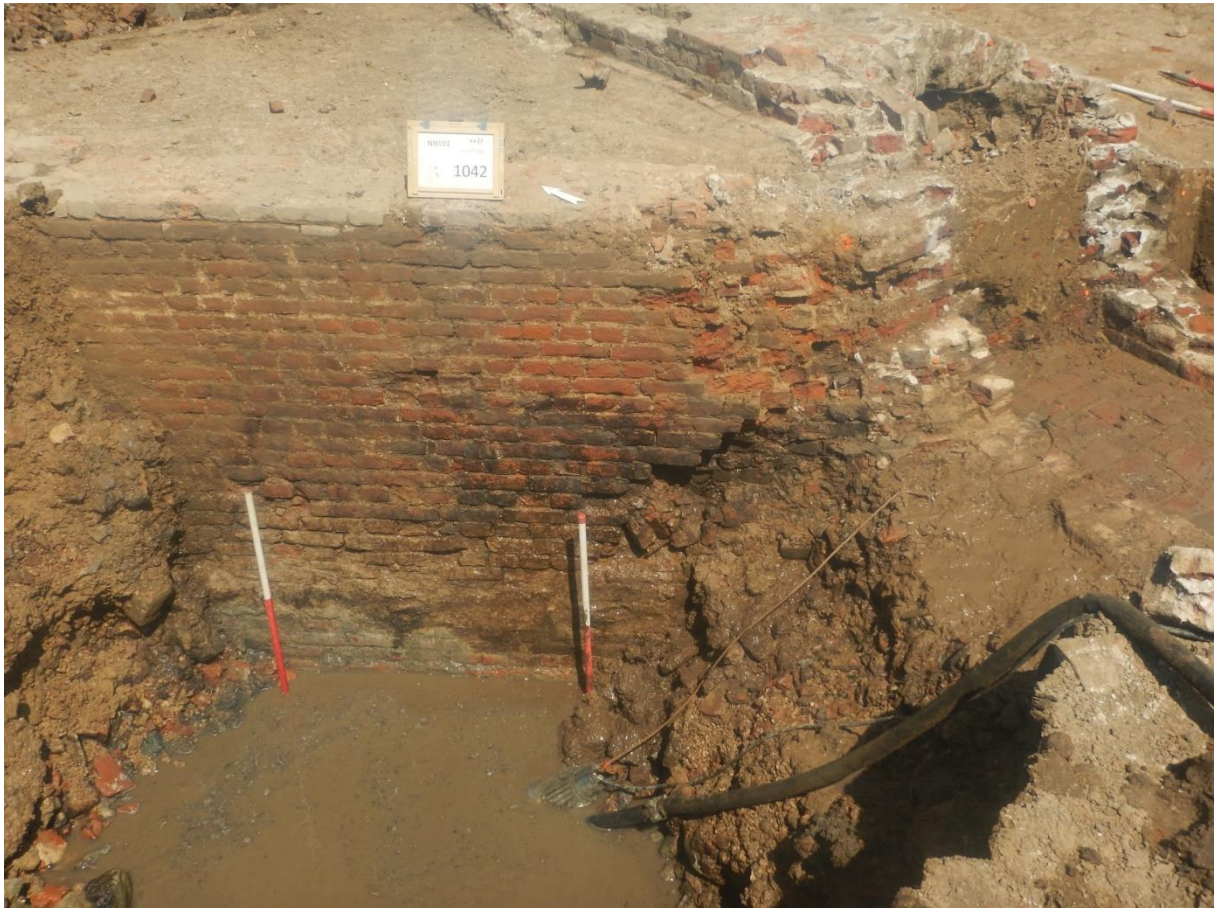
Figuur 49. Coupe op de keermuur BSS5 met ook het doorbreken van het afwateringskanaal BSS4 (rechts op de foto). Vanaf een bepaald niveau kleuren de bakstenen zwart tot beige. Het gaat om afzettingen op de baksteen doordat deze onder water stonden. Het was wegens de hoge waterstand niet mogelijk de diepte van de muur verder te bepalen.
