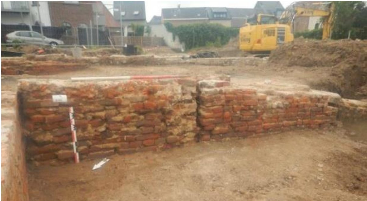
Figuur 115. Detailfoto van muur S161 met centrale breuk.
