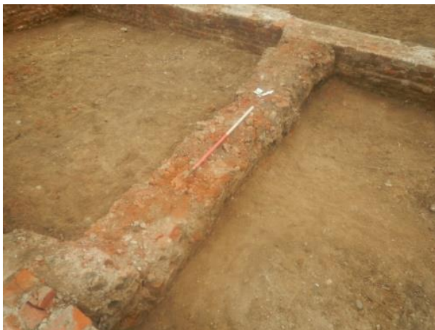
Figuur 93. Detailfoto van de sterk uitgebroken dwarsmuur S143.
