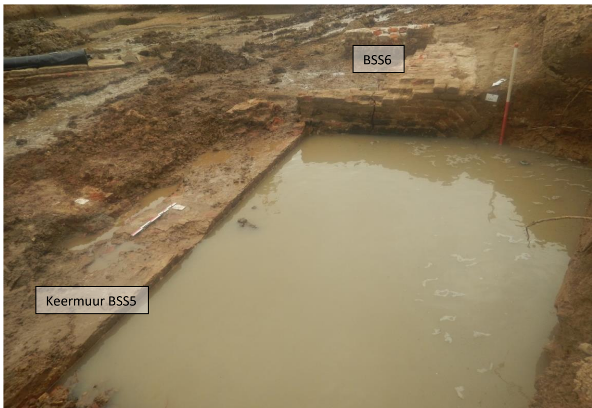
Figuur 53. Keermuur BSS5 in het noorden van het plangebied met een brugaanzet (BSS6) en een zeer hoge grondwaterstand.
