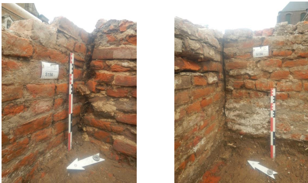
Figuur 110. Detailfoto van het metselwerk van muur S156 tegen muur S110 (links) en S119 (rechts).
