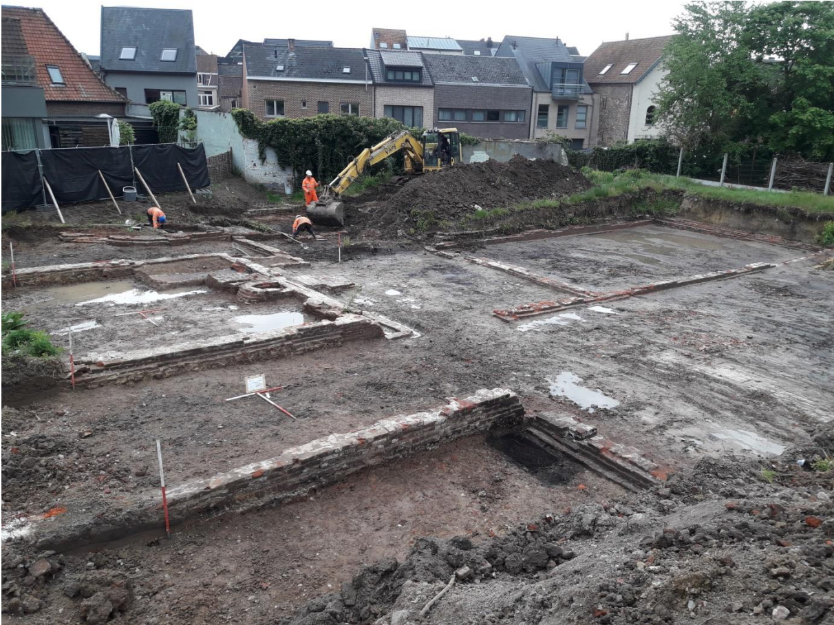
Figuur 10. Sfeerfoto tijdens de aanleg van werkput 4. Centraal rechts de funderingen van de 19 de -eeuwse schuur.
