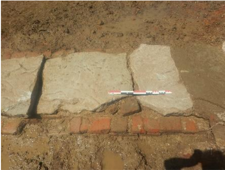
figuur 58. Detail van enkele dekstenen van het afvoerkanaal BSS2.
