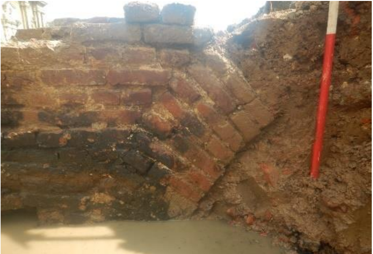
Figuur 55. Detail van de naar het westen afbuigende spaarboog (en de hoge waterstand tijdens het onderzoek).
