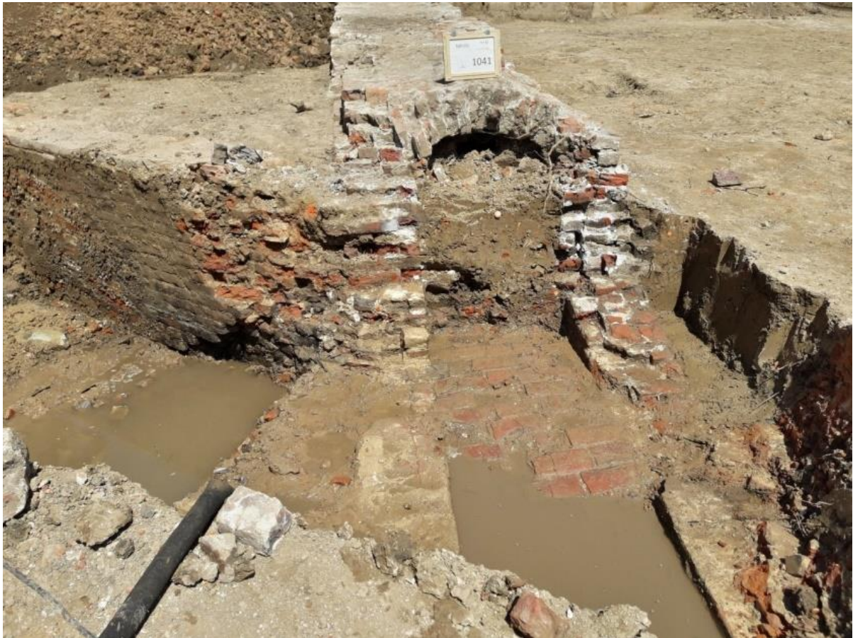
Figuur 65. Op de locatie waar het kanaal was doorbroken, kon de vloer ervan worden geregistreerd. Op deze plaats is de relatie met de keermuur (links) duidelijk zichtbaar. Het afvoerkanaal is duidelijk jonger dan de muur.
