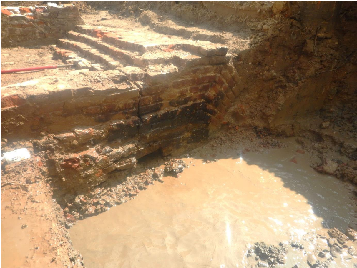
Figuur 56. Overzicht van de brugaanzet en de spaarboog, zicht naar het zuidwesten. de aanwezigheid van het vele water werd veroorzaakt door de puinige vulling van het kanaal waarin het grondwater zat vervat.
