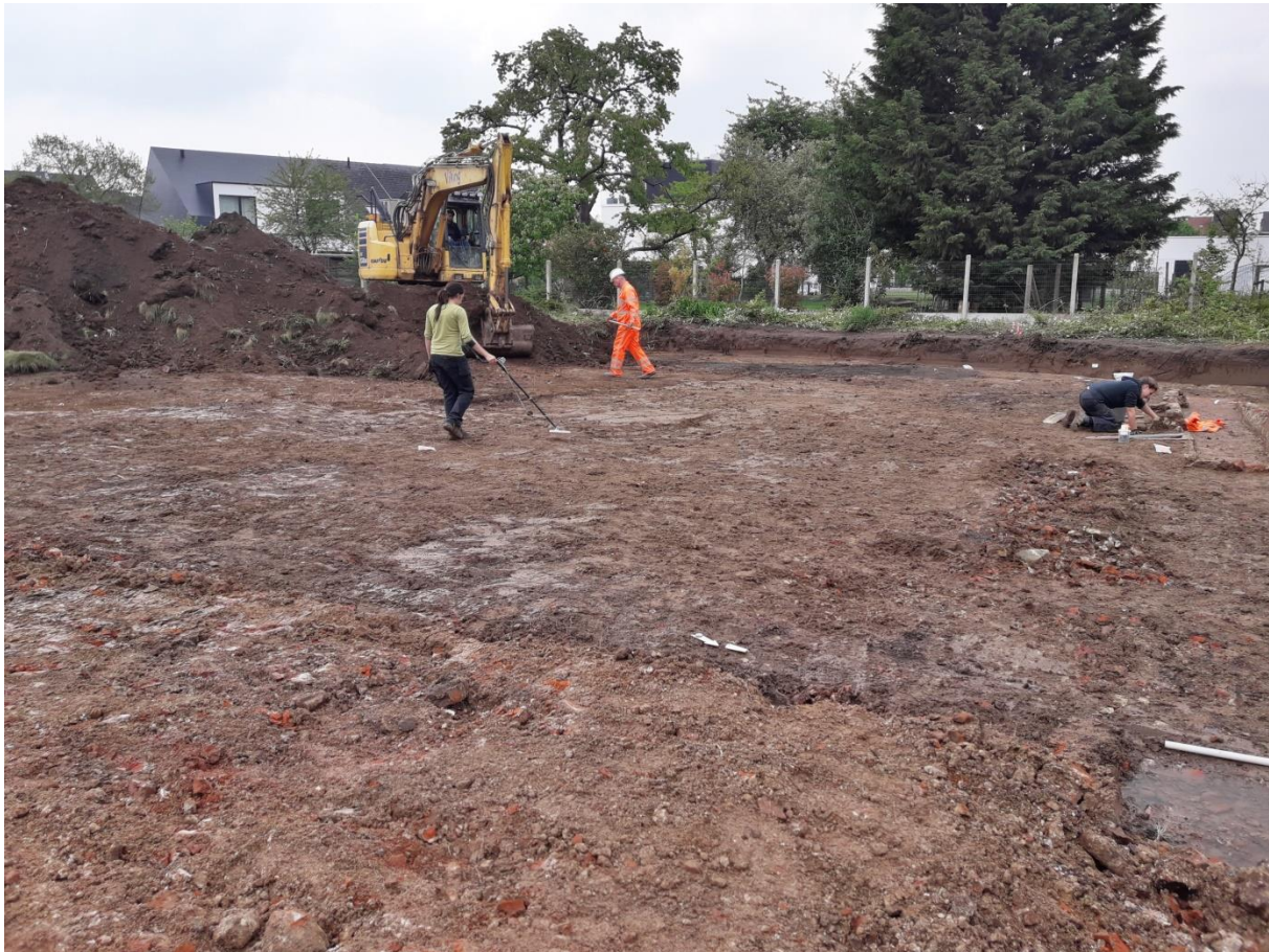
Figuur 7. De aanleg van werkput 1, vlak 1.
