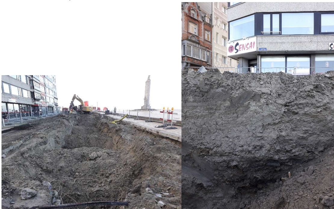
Figuur 4: uitbraak stormkoker resulteert in 5m brede verstoring thv werkput 3 (links) en enkele losse bakstenen bij truweel in vermoed restant gedempte gracht (rechts)
