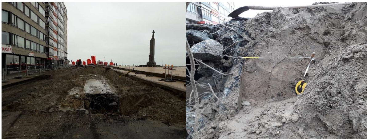
Figuur 3: stormkoker thv werkput 2, met detail aanlegkuil koker
