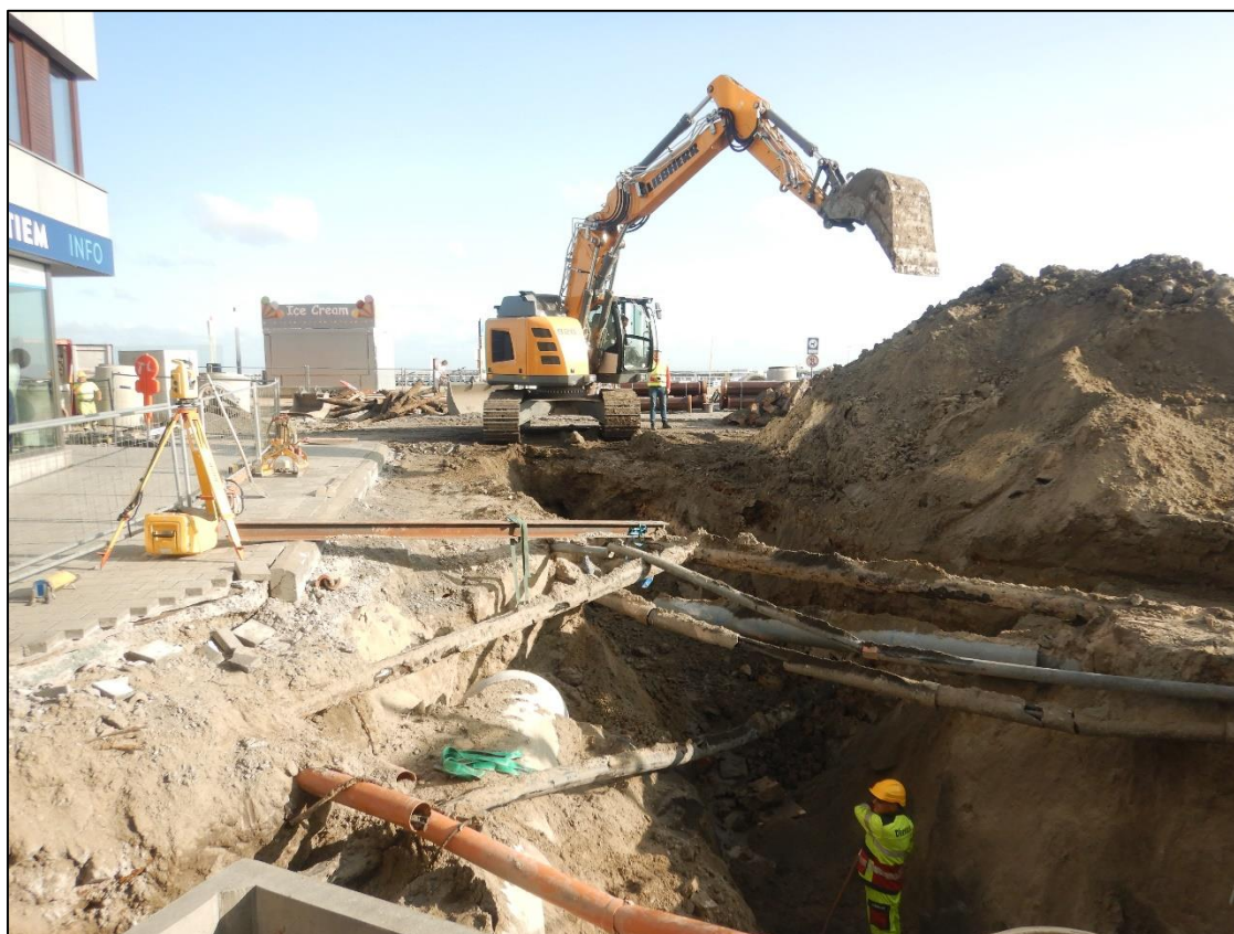
Figuur 11: kluwen van veelal te behouden nutsleidingen op het einde van de Langestraat
