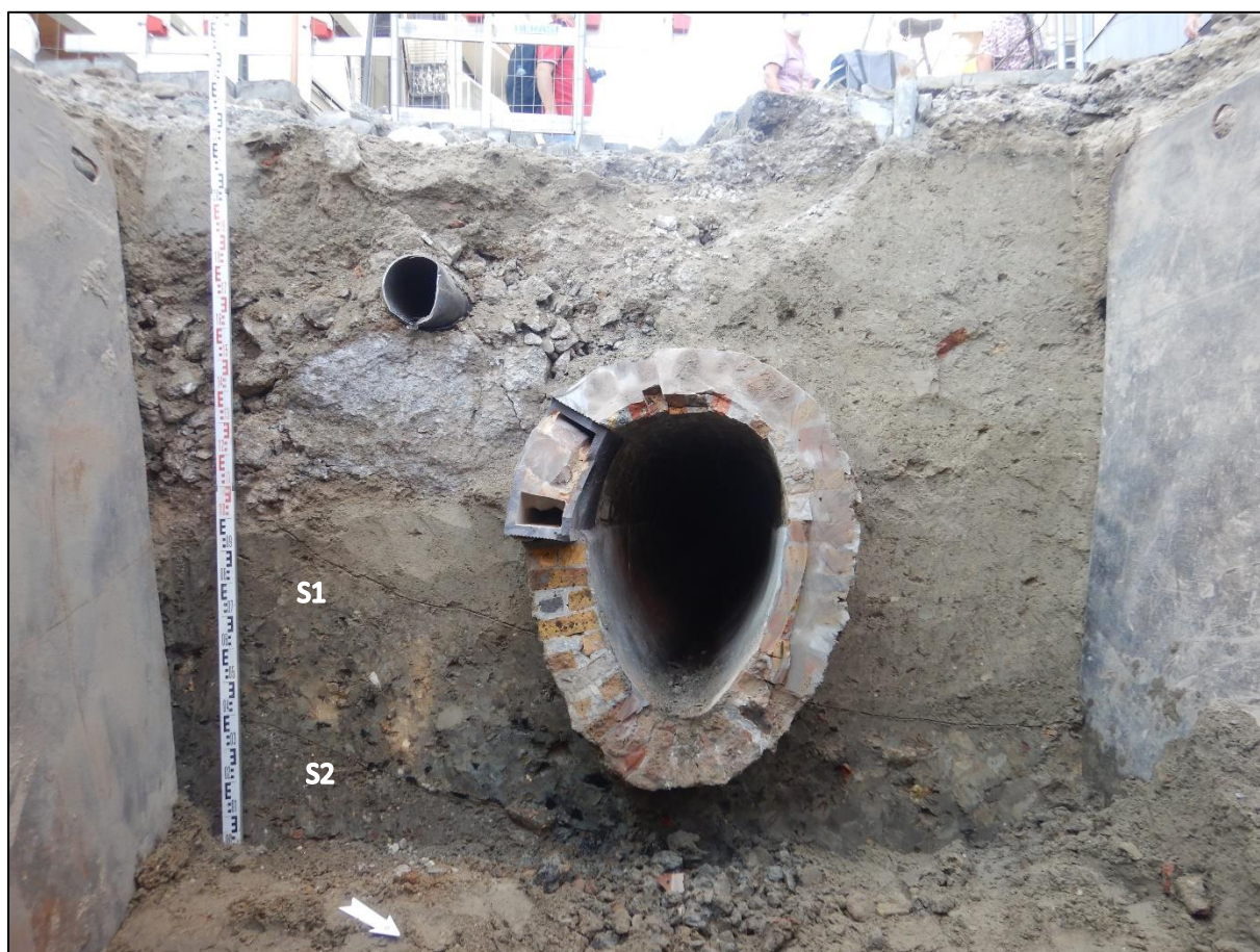
Figuur 29: bakstenen riool E600/600 en pvc afvoerbuiss d230 in profiel 1 in put 1
