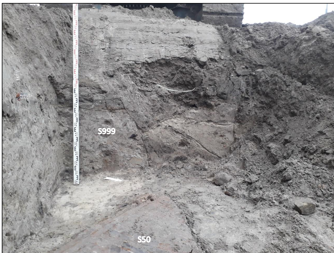
Figuur 49: fragmentaire staat van plaveisel S50 na sloop stormriool
