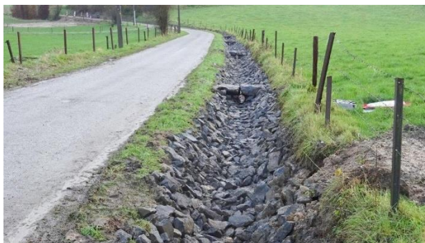
Figuur 75. Recente greppel (2017) in Tubize waar een bedding van stenen wordt gebruikt om de waterafvoer te controleren en overstromingen te vermijden. (bron: https://lacapitale-brabant-wallon.sudinfo.be/161441/article/2017-12-03/un-fosse-redents-sur-la-rue-du-transvaal-tubize )
