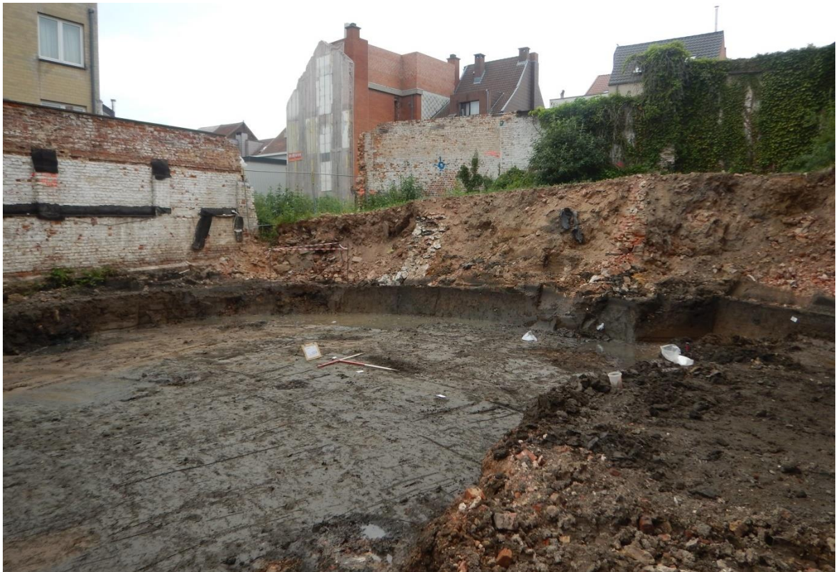
Figuur 125: Het aangelegde tweede vlak onder het ophogingspakket in het uiterst noordoosten van de werkput. Op de achtergrond is dit ophogingspakket, enkele restanten van muurfunderingen en opgaand muurwerk nog zichtbaar.
