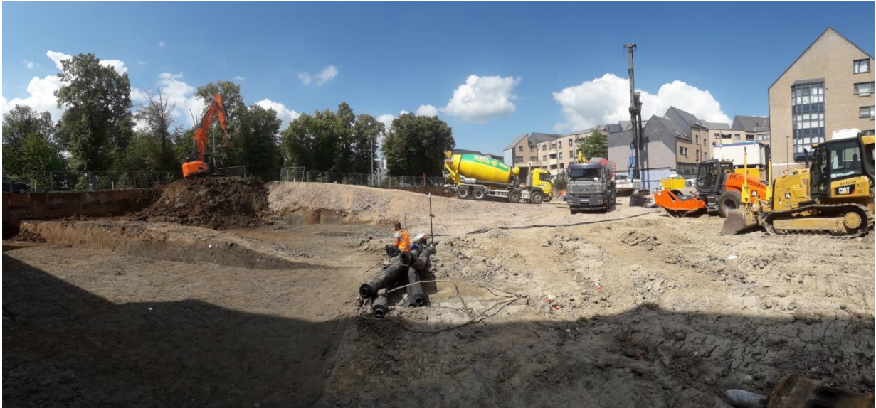
Figuur 27: Centraal in beeld bevindt zich de talud die zware machines toegang geeft tot de bouwput.
