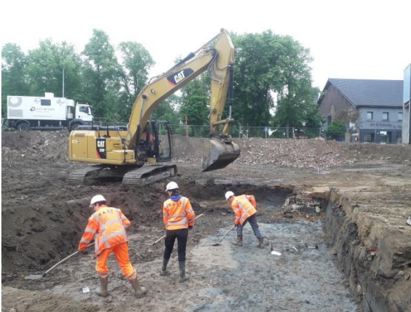
Figuur 28: Aanleg van werkput 4, vlak 2.
