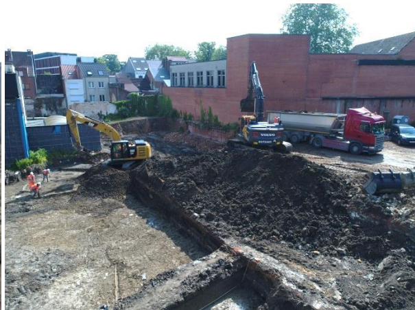
Figuur 29: Aanleg van werkput 6 en de afvoer van de grond.
