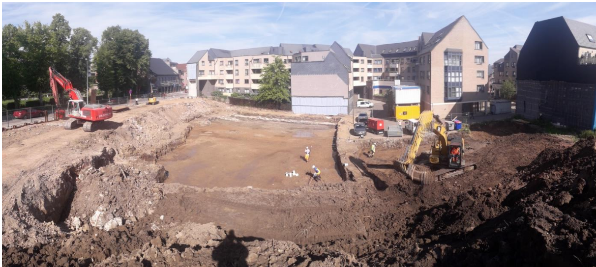
Figuur 25 : Centraal in beeld bevindt zich werkput 4, de rechter putrand vormt PR106. Nog rechts hiervan word gestart met de aanleg van werkput 6.
