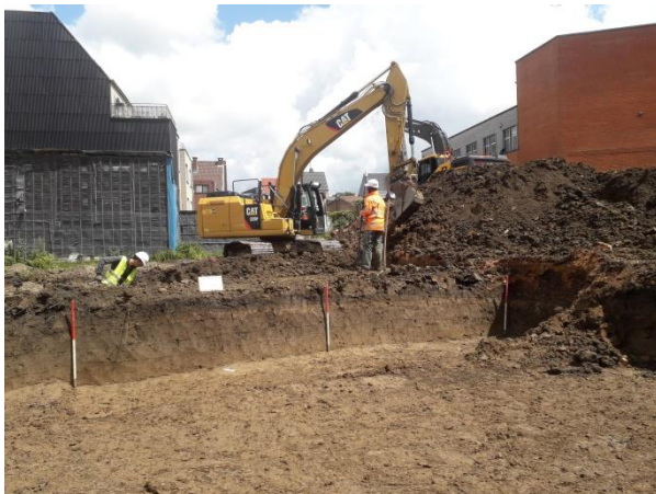
Figuur 30: Profiel PR106 en aanleg van werkput 6.
