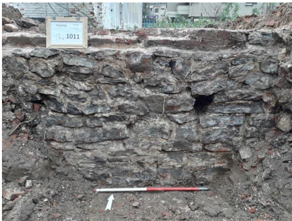
Figuur 90. Baksteen (S18) en natuurstenen muur (S12) in sleuf 4 van het proefsleuvenonderzoek.
