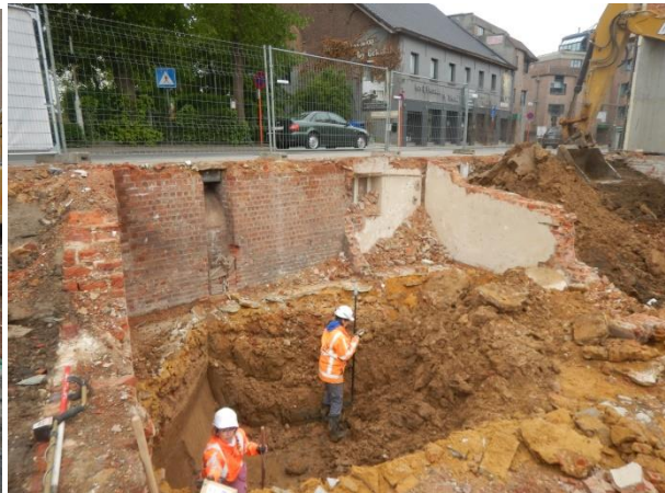
Figuur 23: Aanleg van profiel PR104 onder de keldervloer van het meest oostelijk pand langs de Arkenvest
