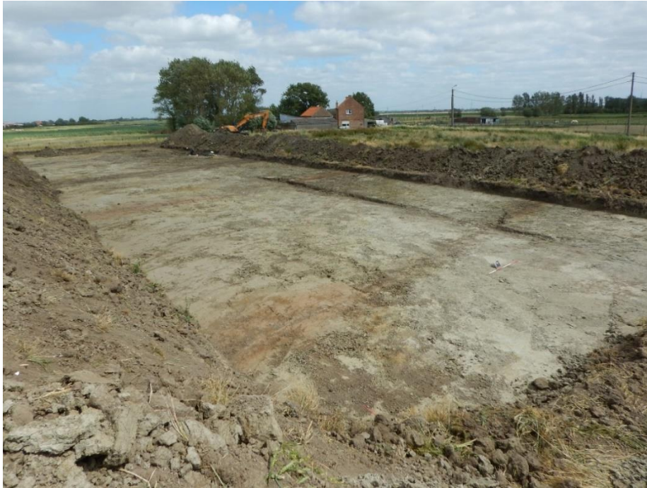
Figuur 10: fotografische opname van de volledig aangelegde werkput 1
