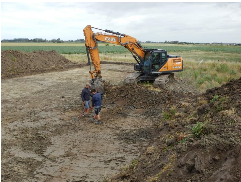
Figuur 9: fotografische opname van de aanleg van werkput 1
