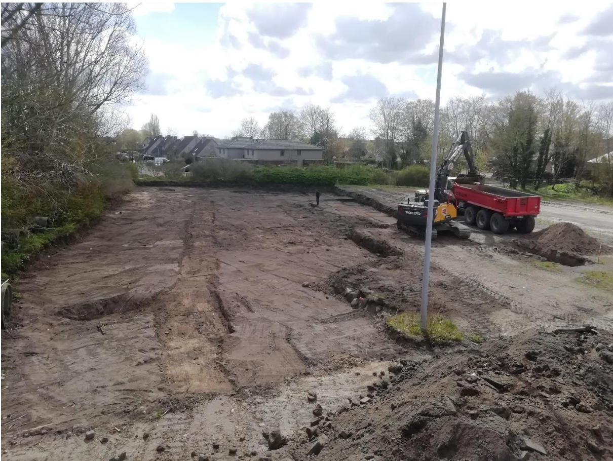
Figuur 10: Afgraven en afvoeren van de puinrijke laag op 14/04/2021.
