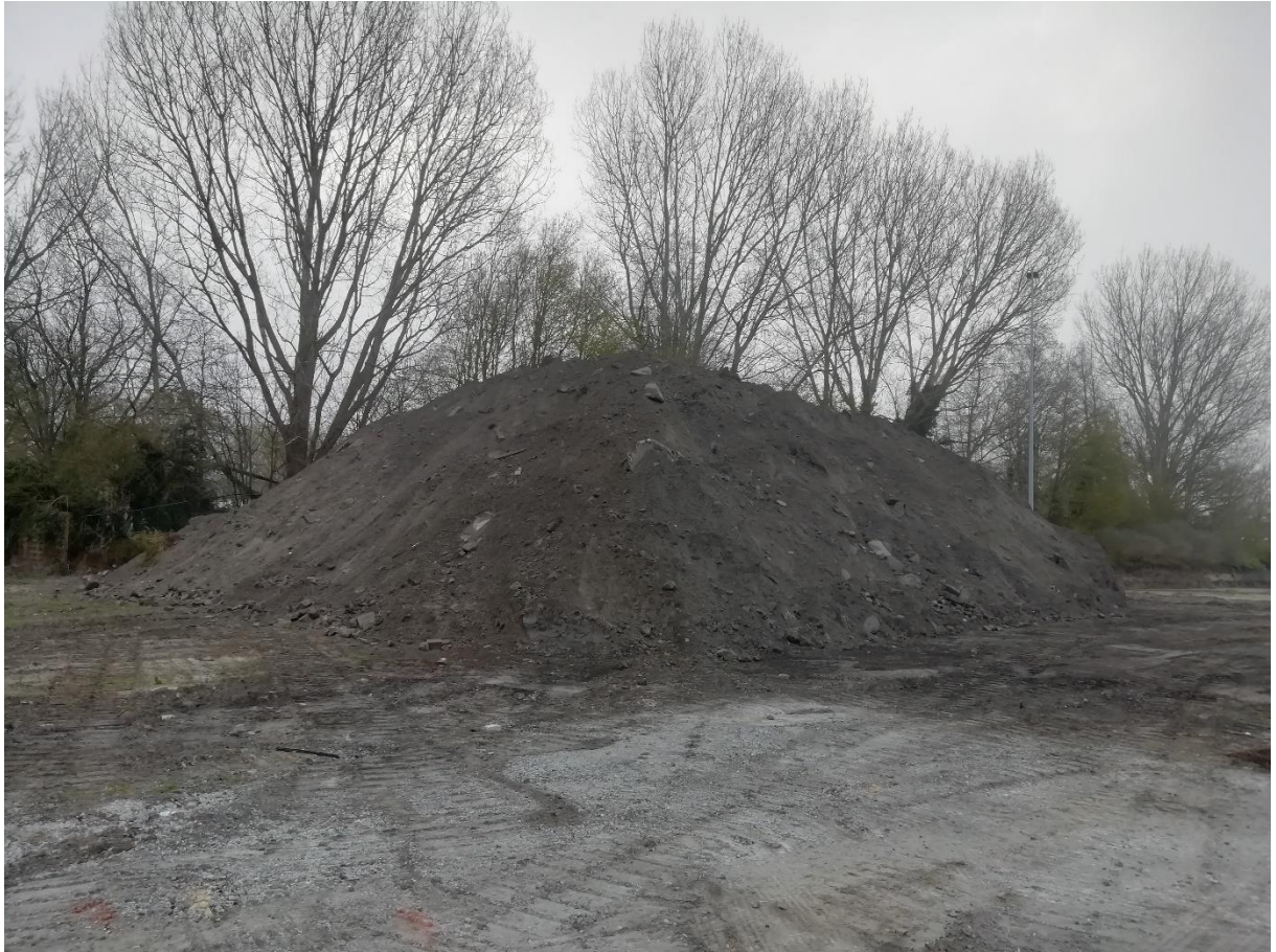
Figuur 11: Stockage van de afgegraven puinrijke laag.
