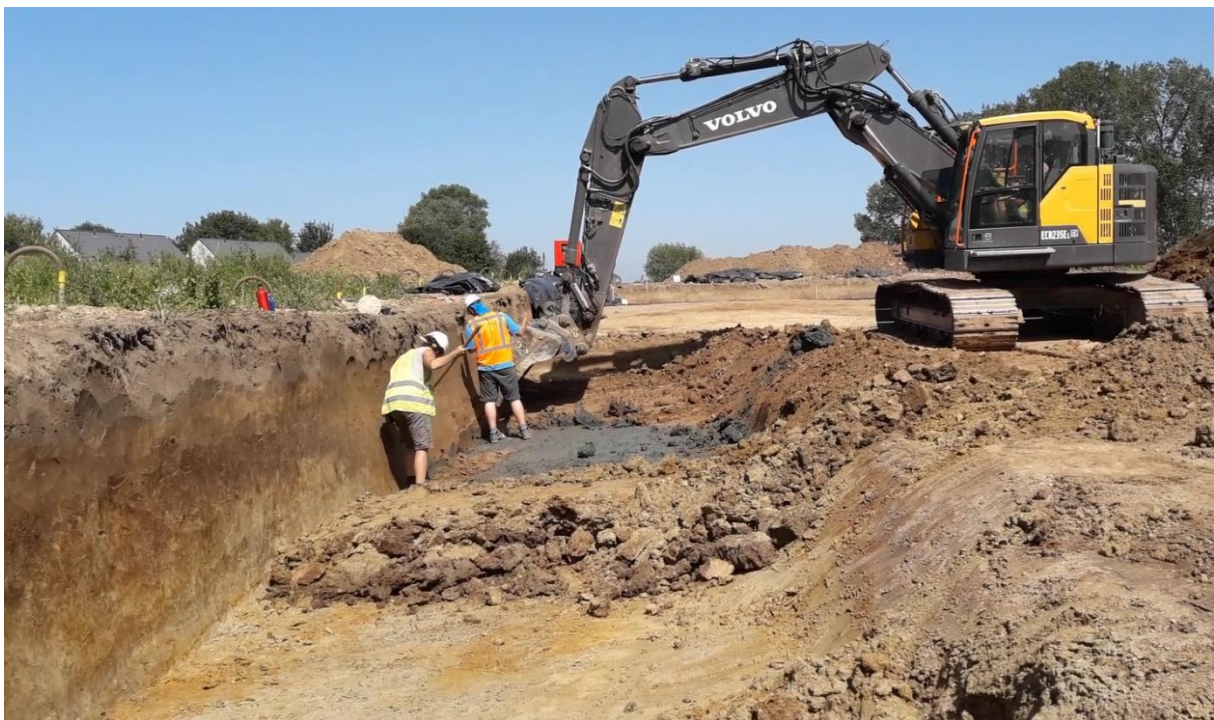
Figuur 8: Plaatsen van haakse profielen op de volledige site met walgracht.
