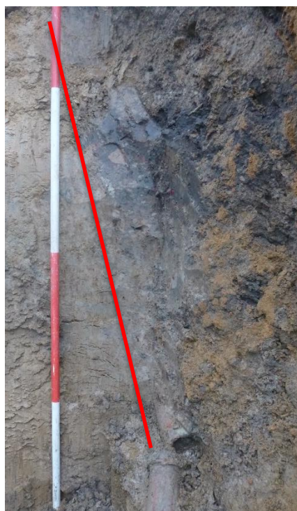
Figuur 51: Detailfoto van de insteek van de rioleringsbuizen.
