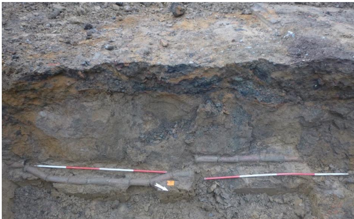
Figuur 50: Foto van de gedeeltelijk verzakte riolering in rode aardewerken buizen (S1.184).
