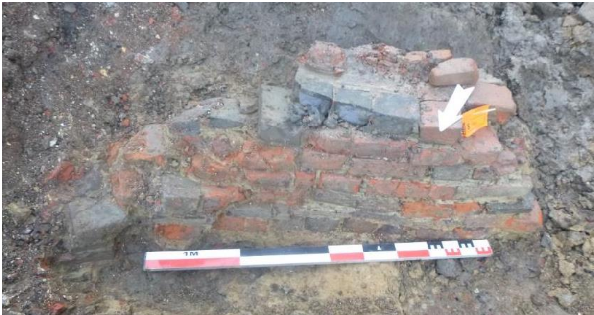
Figuur 35: Funderingsrestant 1.144, een baksteenmuur gemetseld met leem.
