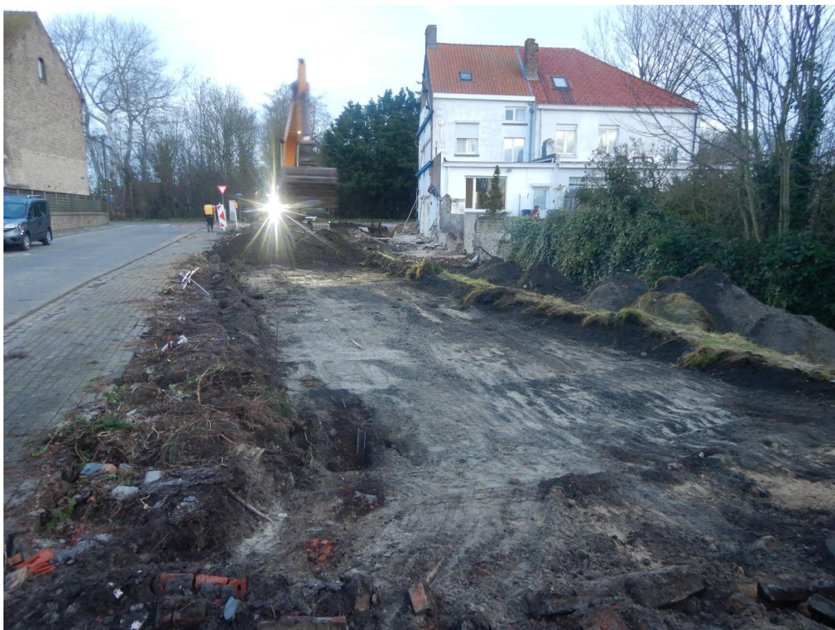
Figuur 8: Afgraven van de ploeglaag op 18/01/2021.
