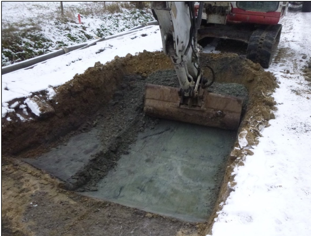
Figuur 26: Aanleg WP 1 (ABO nv 2019)
