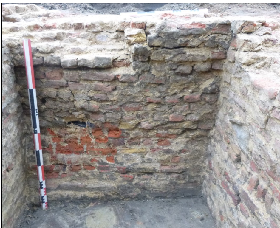
Figuur 68: Binnenzijde muur SP 3.17 met onregelmatig verband (ABO nv 2019)
