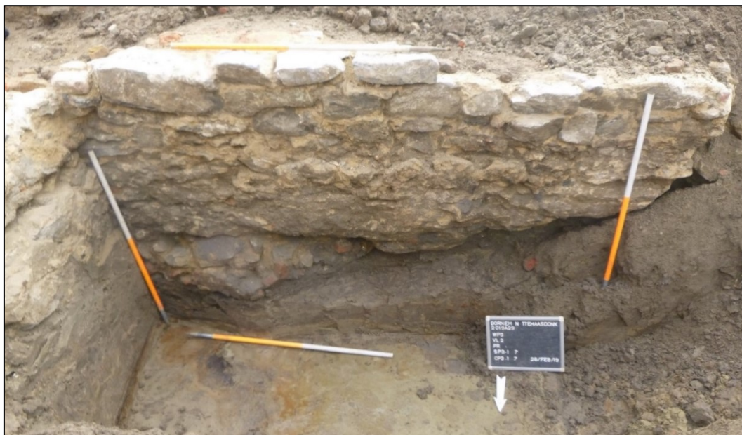
Figuur 46: Spoor 3.7 met fundering uit veldstenen vermengd met resten baksteen (ABO nv 2019)
