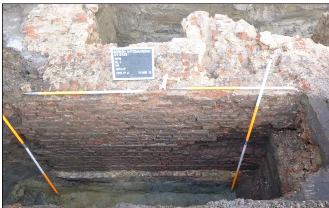
Figuur 72: Detail parement in baksteen aan buitenzijde (zuidzijde) (ABO nv 2019)
