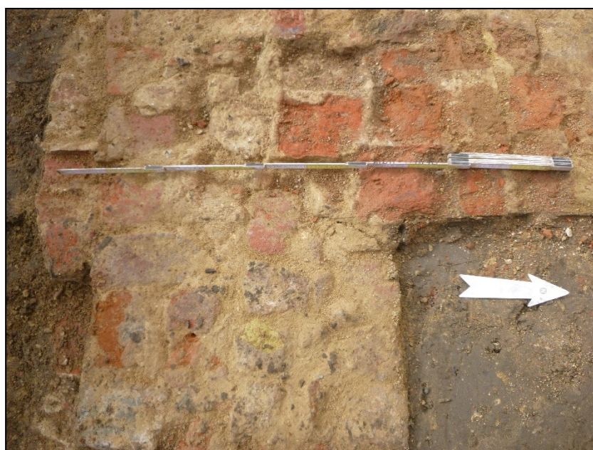
Figuur 50: Overzicht van gehalveerde, hergebruikte bakstenen " (ABO nv 2019)
