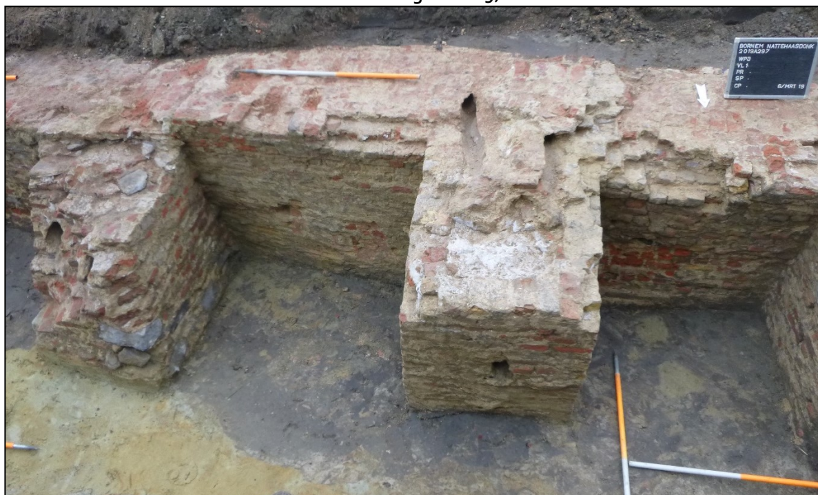
Figuur 62: Detail van de steunberen aan de westelijke zijde (ABO nv 2019)
