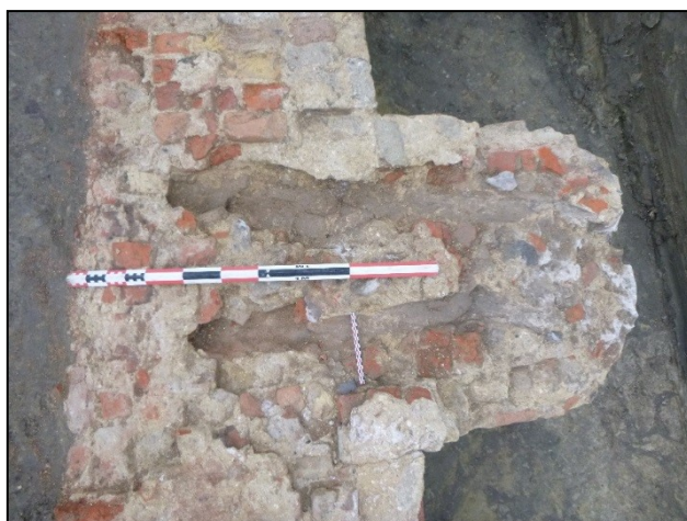
Figuur 77: Steunberen SP 3.17 met verschillende mogelijke steigergaten (ABO nv 2019)
