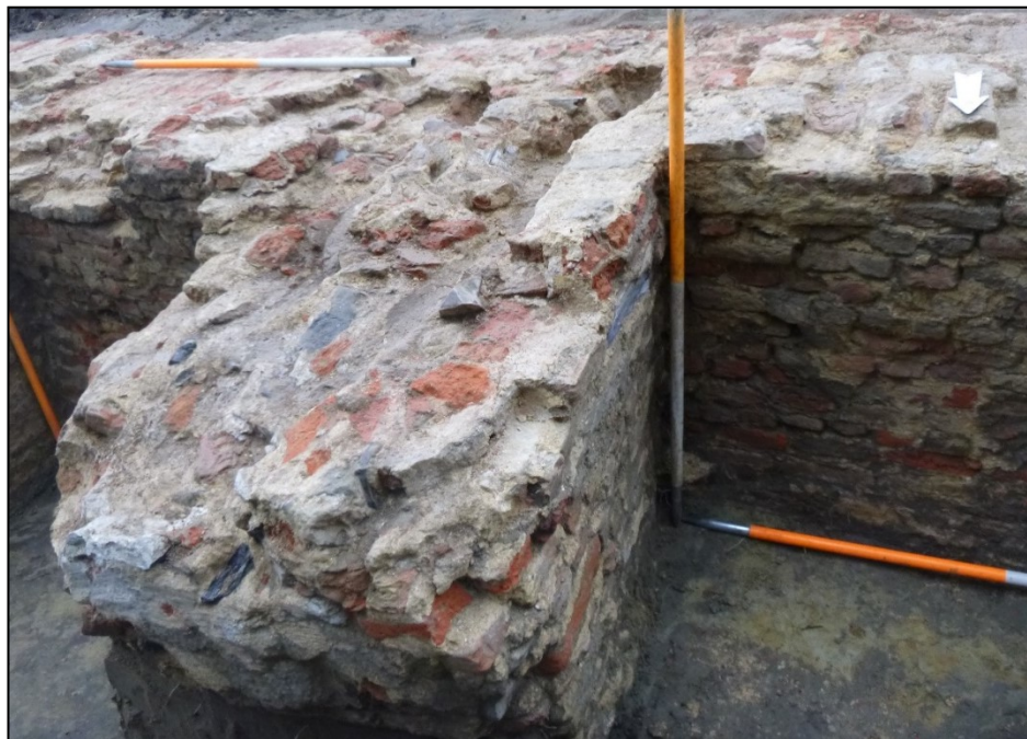
Figuur 67: Detail van een steunbeer met mix van bouwmaterialen en mortelsoorten (ABO nv 2019)
