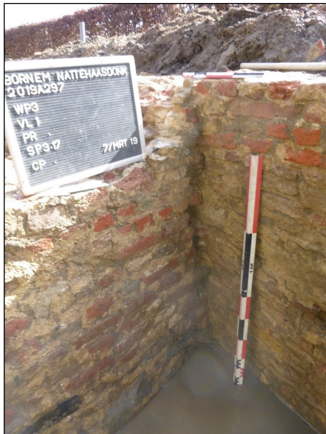
Figuur 74: Aansluiting steunbeer met muur (ABO nv 2019)
