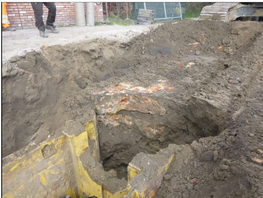
Figuur 21: De muur bij het verwijderen ervan (ABO nv 2020)
