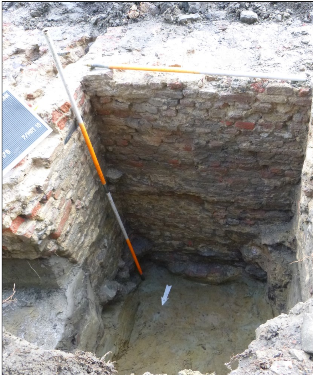
Figuur 65: zicht op fundering en verschillende bouwfasen van muur SP 3.17 (ABO nv 2019)
