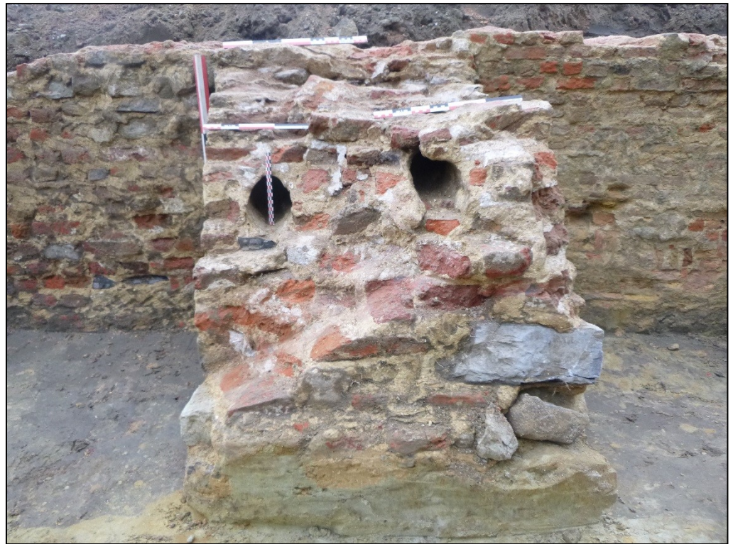
Figuur 75: Zicht op enkele van de mogelijke steigergaten in de steunberen fase 3 (ABO nv 2019)
