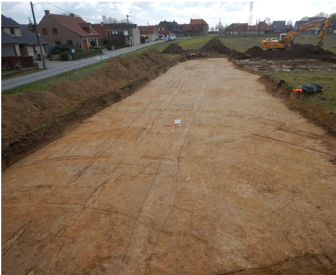
Figuur 128 Zicht op het opgravingsvlak vanuit het noorden, waarbij duidelijk de langgerekte sporen van het wegtracé te zien zijn: centraal spoor 5, met links daarvan spoor 1 dat in verschillende kleinere stukken uiteen valt (©RAAP België).
