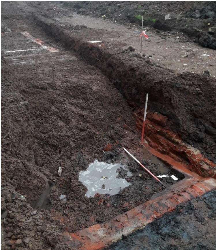
Figuur 40: Muurresten van het recent opgevulde keldervolume in werkput 2.
