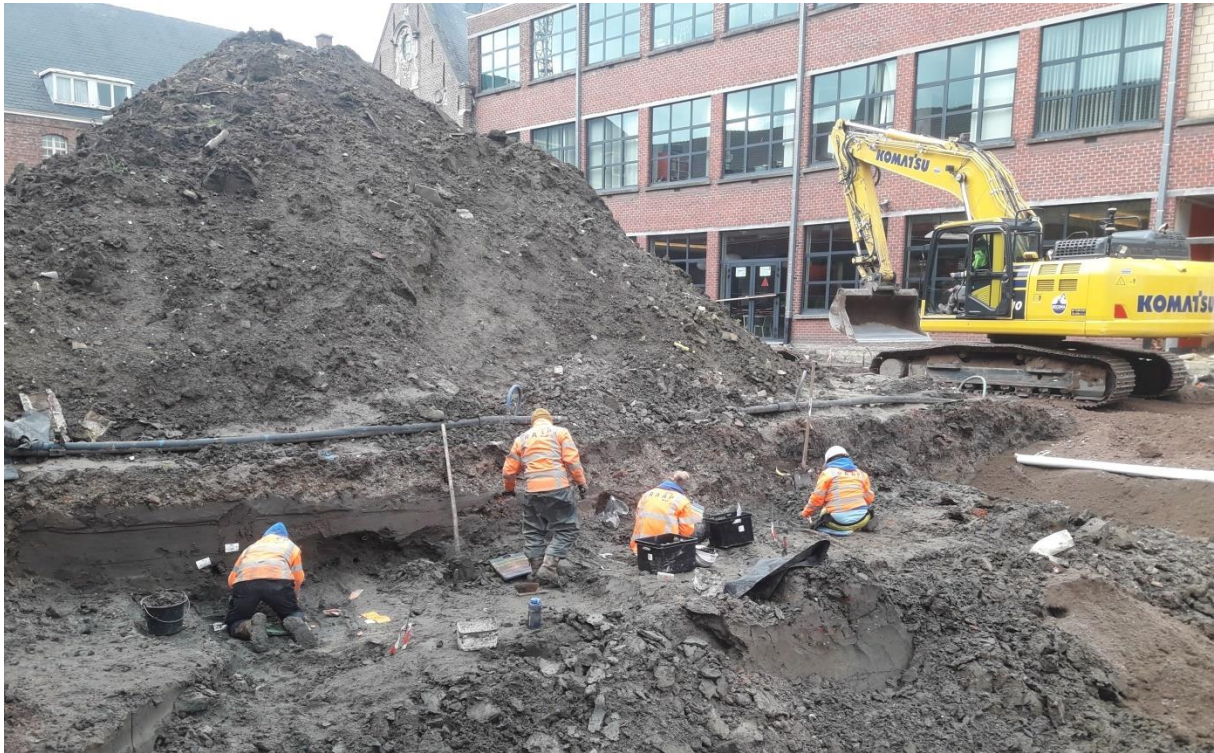
Figuur 10. Dump van 'vervuilde grond' van het type 921, gelegen net ten westen van werkput 1 (zone blok A). Net langs deze putrand bevond zich een strook met inhumaties.
