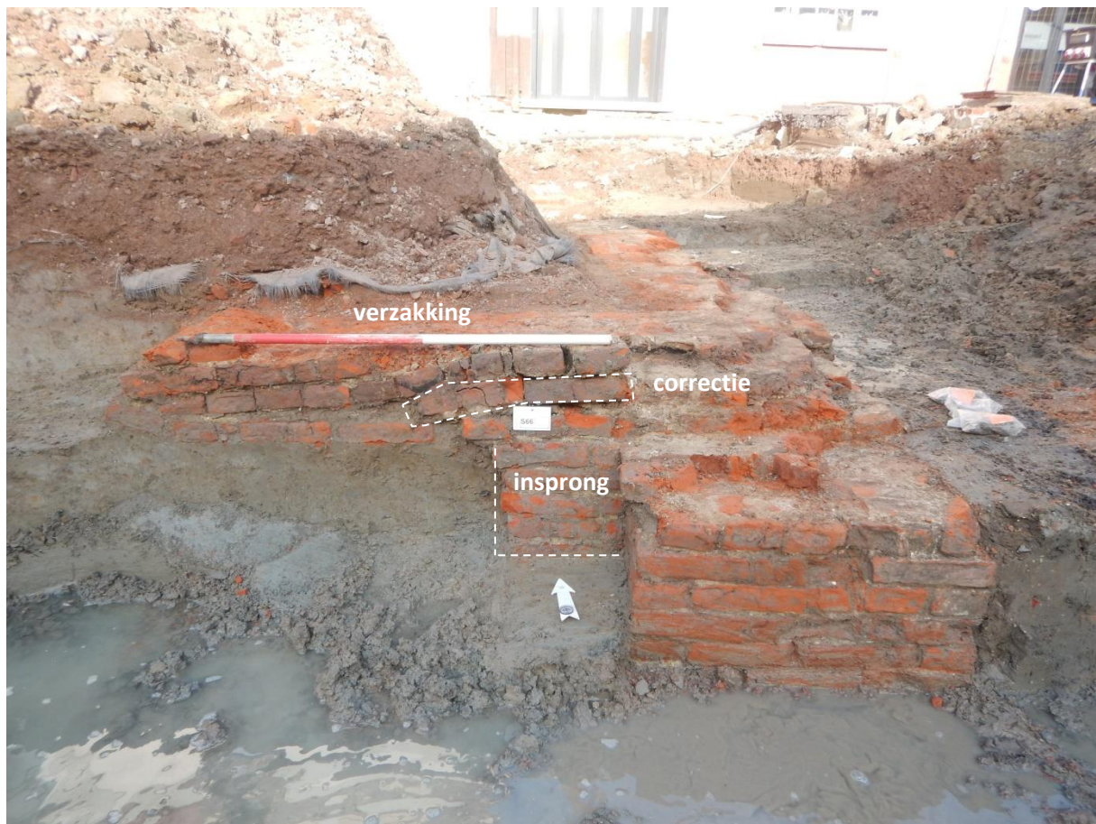
Figuur 36. Detailfoto van het muurwerk S66 van structuur BS-STR-2.
