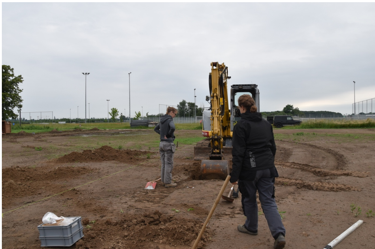
Fig. 1.24: Uitgraven funderingsputten.
