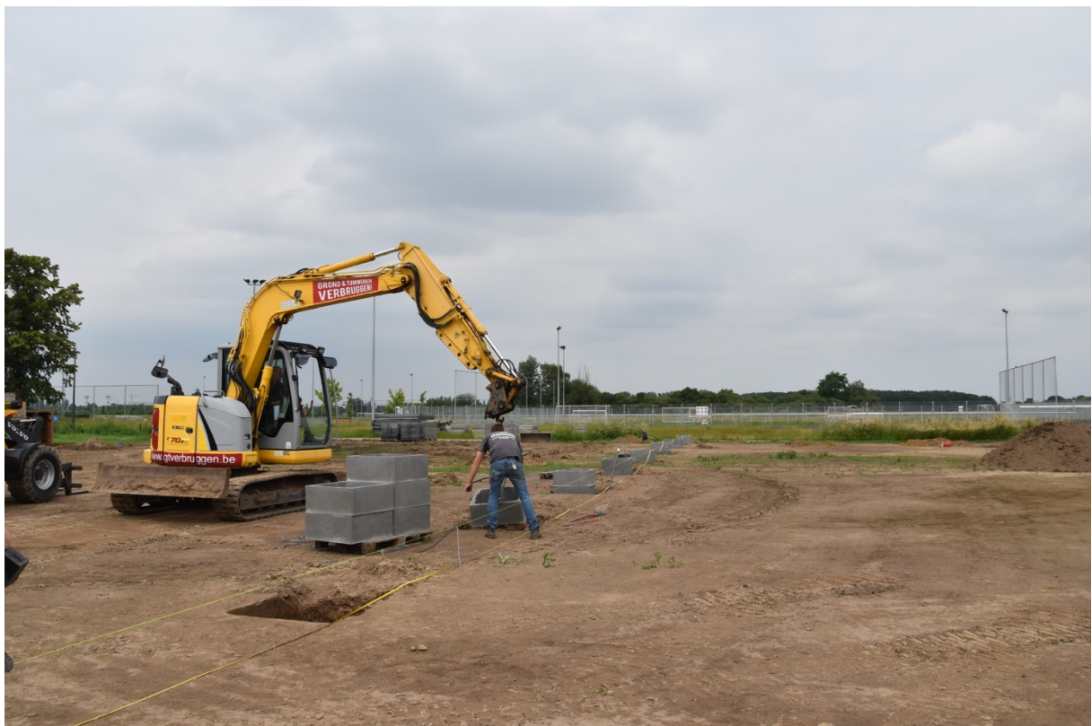
Fig. 1.26: Installatie van de betonnen funderingsblokken in de werkputten.
