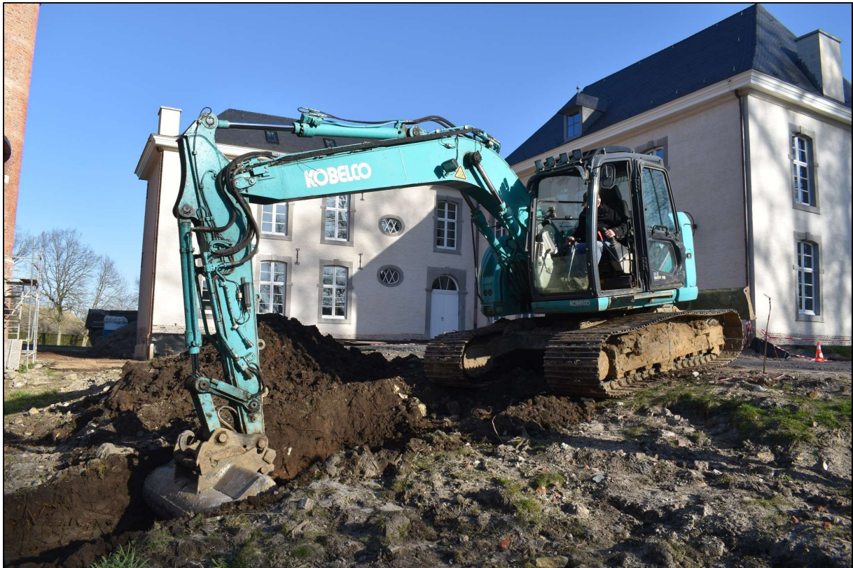
Afb. 24: Aanleg PR1, dwars op het vijverprofiel (Bron: Aron bv, dd. 24/03/2020).
