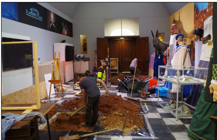
Foto 1: Twee technische assistenten van SOLVA verdiepen manueel de proefputten in het schip van de kapel.
