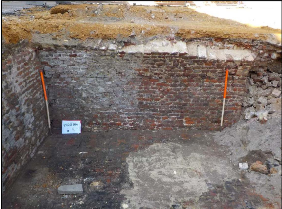
Figuur 29: Oostelijke kelder muur (S79) tijdens proefputonderzoek. Aan de rechterzijde kan de kelderopening herkend worden. Deze ligt vol met puin 35
