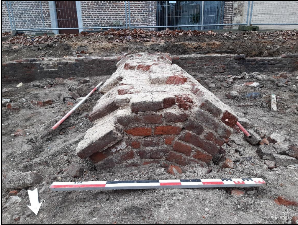
Figuur 25: Zicht op opening in S79, waarbij de aanzet van het tongewelf goed te zien is.
