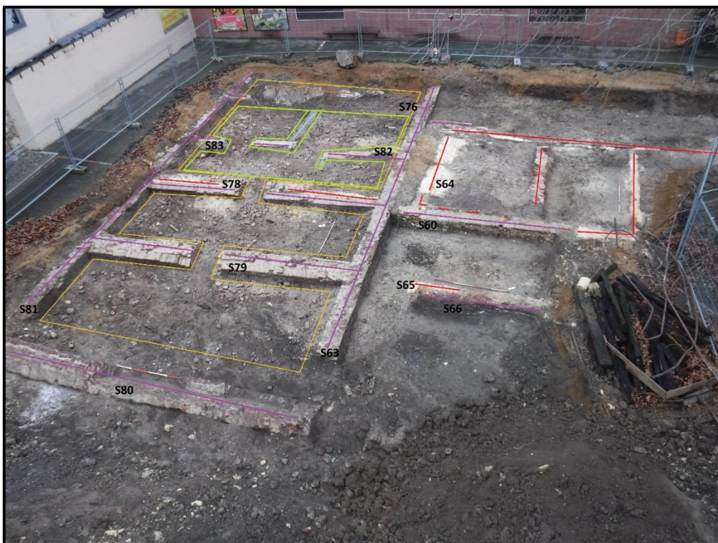
Figuur 28: Overzicht keldercomplex: minstens driebeukige kelder (geel) gevormd door muren S80, S81, S63 en binnenmuren S79 en S78 (paars); Een recentere kelder met pleister (groen) wordt gevormd door oude en enkele jonge cementmuren (licht blauw)
