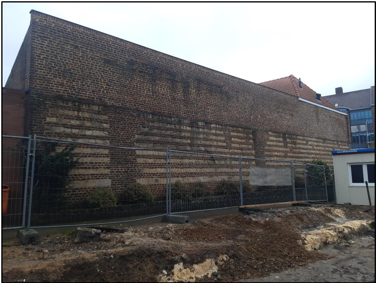
Figuur 11: Zicht op de noordwestelijke perceelsmuur. Restanten van een muur opgebouwd uit mergel en baksteen.
