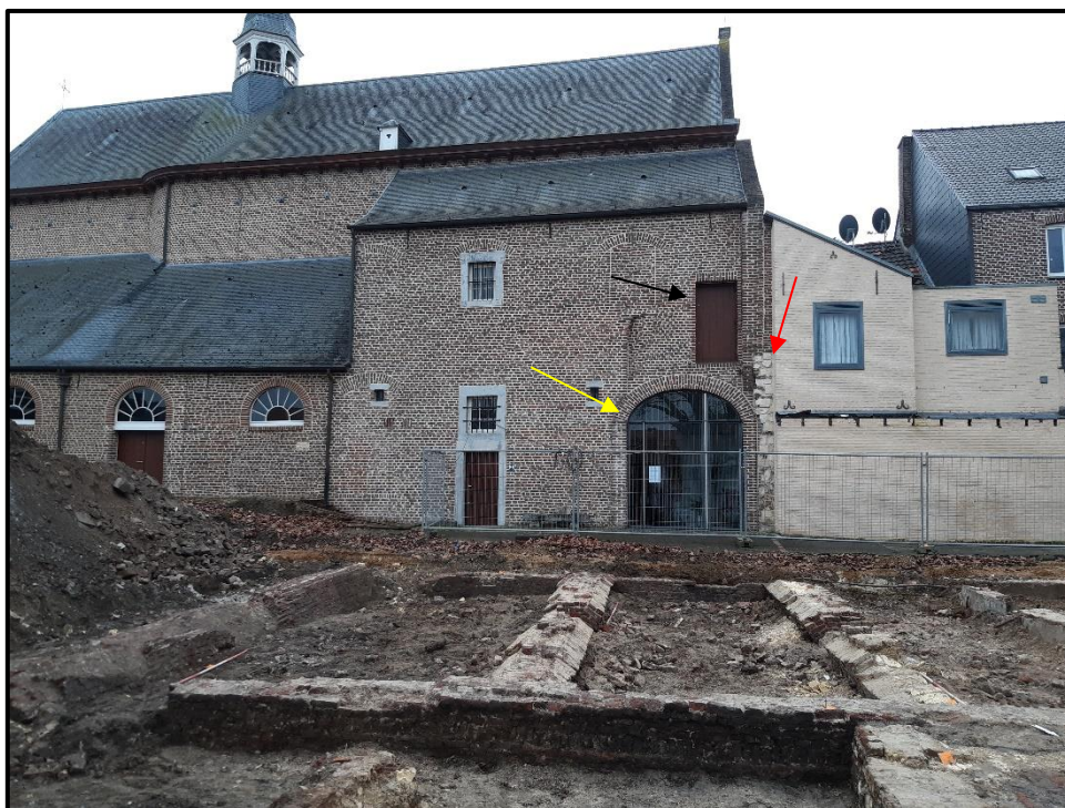
Figuur 10: Zicht op de Kruisherenkerk met aanbouw. Rechts is de boogopening (geel) en de restanten van een mergel-baksteenmuur (rood) te zien. Op de eerste verdieping zit een deur in de gevel (zwart).
