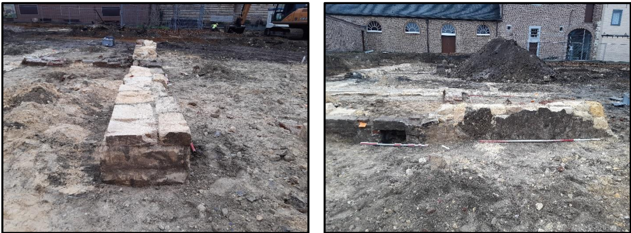
Figuur 16: Zicht op muur S18. Links: afgewerkte oostelijke kopkant. Rechts: noordelijke zijde met opgevulde opening (S46) en afgewerkt met plaaster
