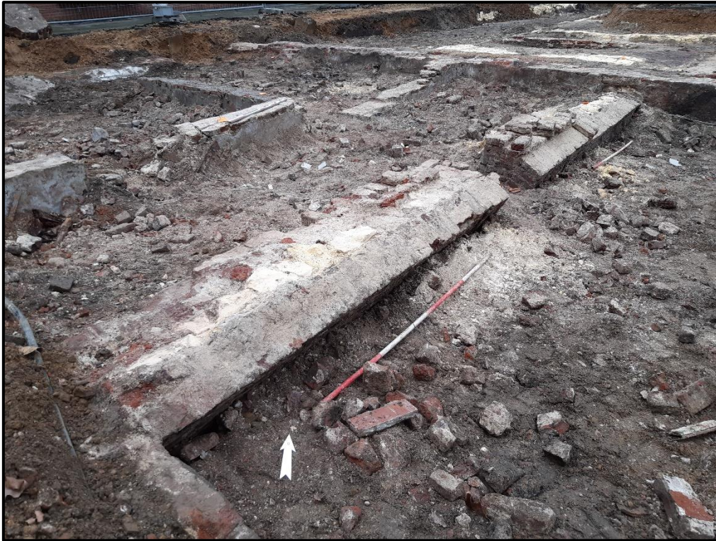
Figuur 26: Zicht op muur S78, met baksteen en mergel
