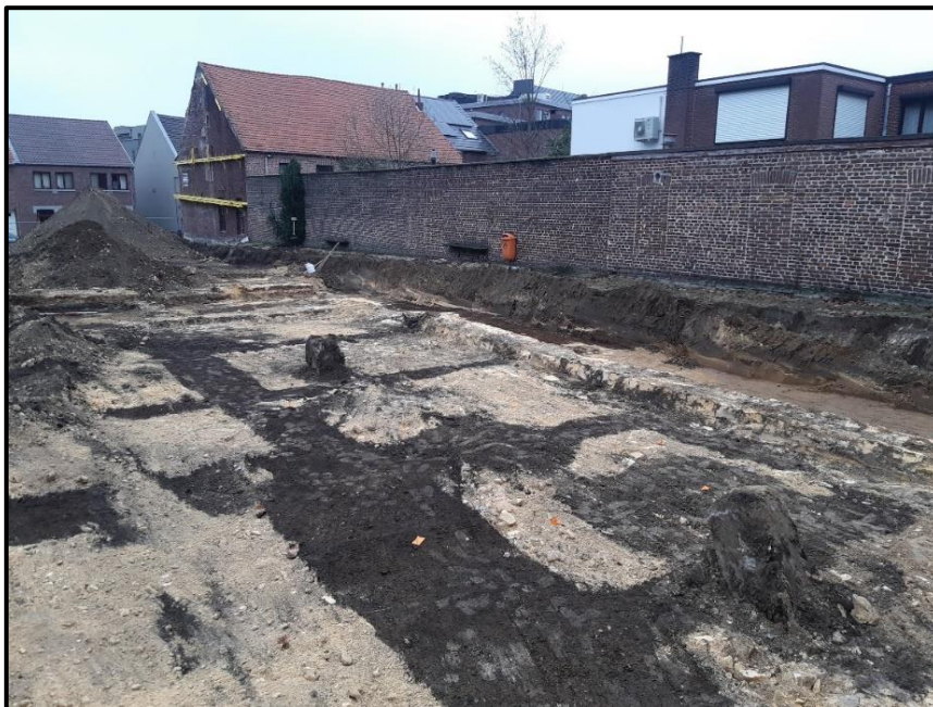
Figuur 24: Overzichtsfoto van de grote puinkuilen die de humeuze laag S10 doorsnijden
