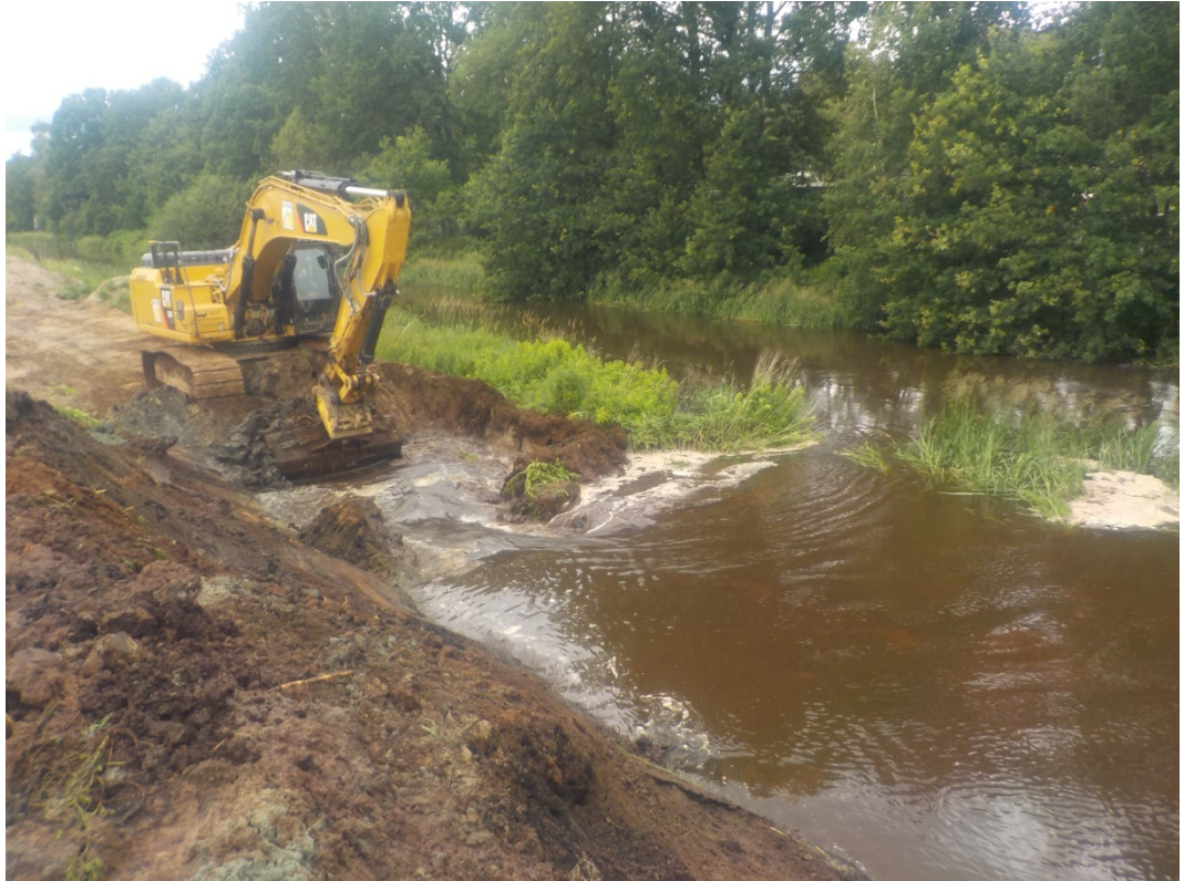
Afb. 1.6. De werken in uitvoering tijdens de hoge waterstand.
