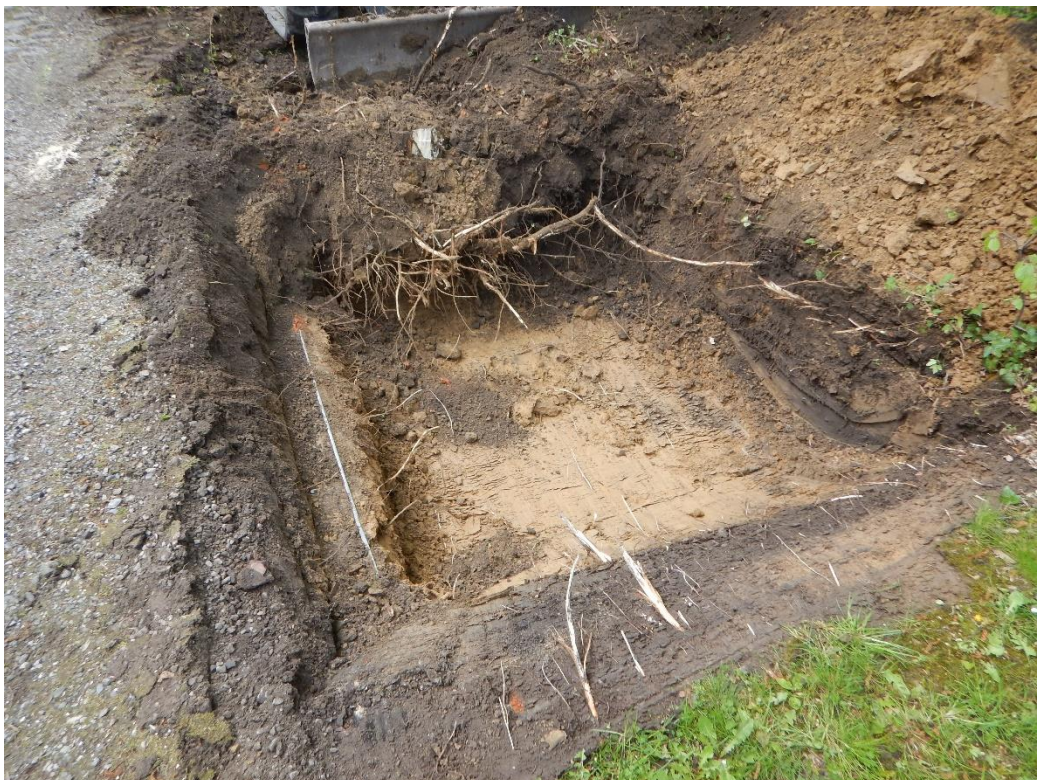
Figuur 15. aanleg werkput 4
