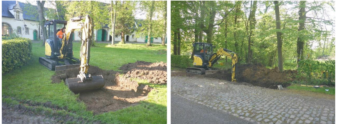
Figuur 4. Aanleg werkputten 1 en 3
