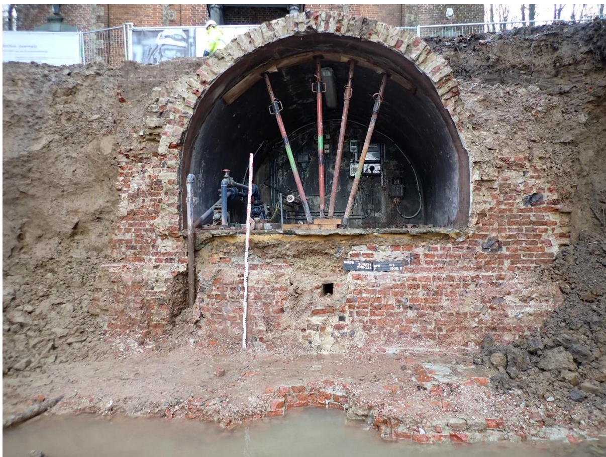
Figuur 24: Het metselwerk na de werken
