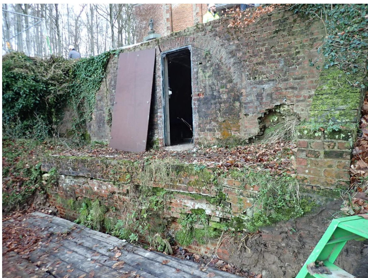
Figuur 23: Staat van het metselwerk voor de werken
