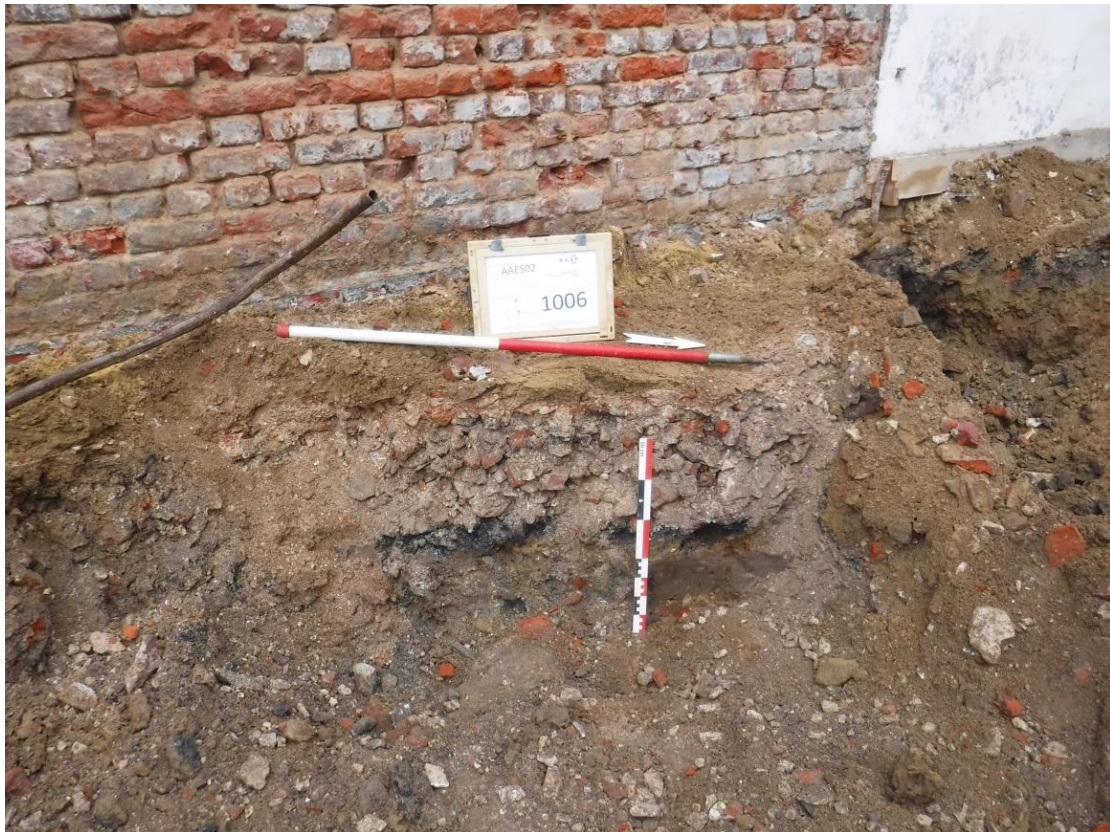
Figuur 15: Westelijk gelegen onderdeel van de recente baksteenfundering die doorheen heel werkput 4 loopt.
