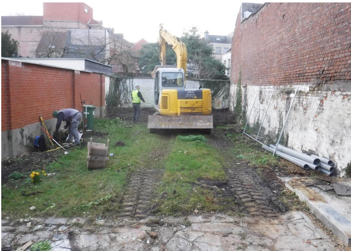
Figuur 7: Overzicht van de zuidkant van het perceel voor de aanvang van de werken.
