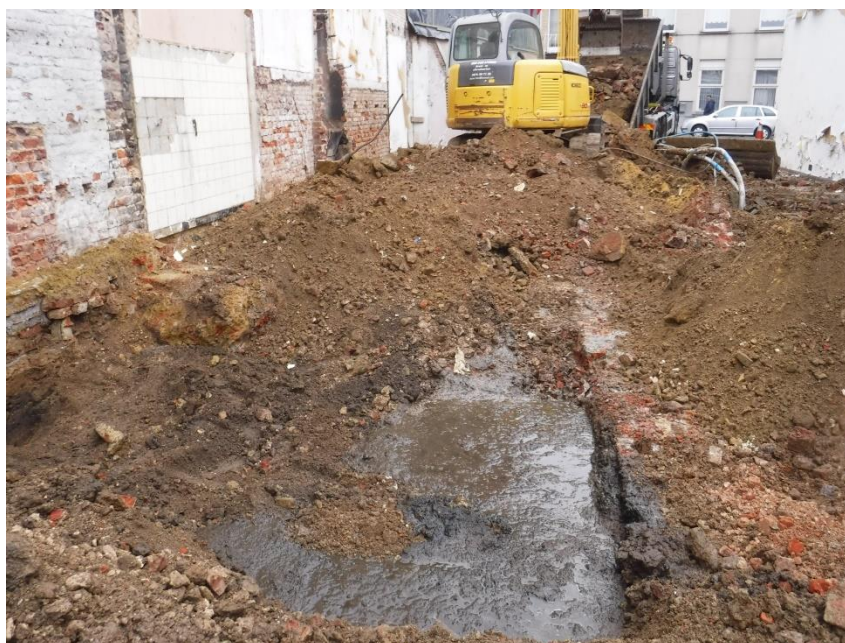
Figuur 18 Overzichtsfoto van de verstoring door de recente bakstenen beerput in het zuiden van werkput 4
