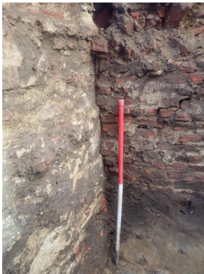
Figuur 30: Foto van de aansluiting van muur S2005 op muur S2008
