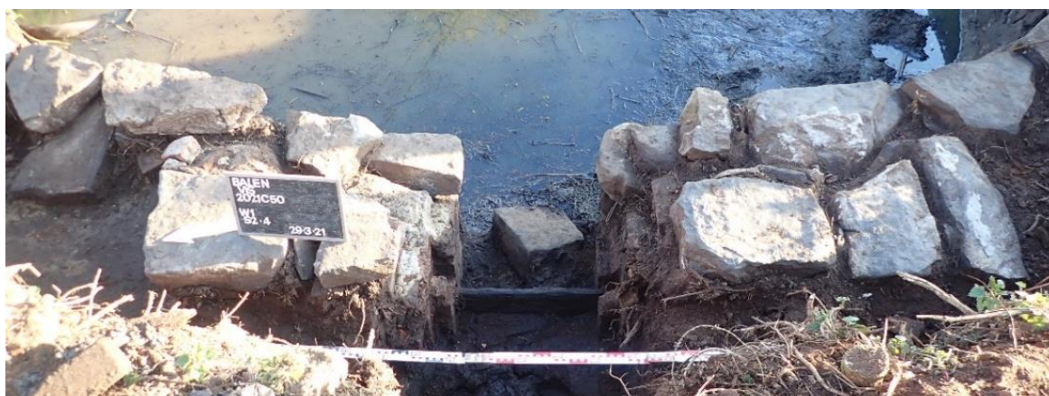
Figuur 12: Bovenaanzicht op S1004, vanuit het zuidwesten (© J. Verrijckt)
