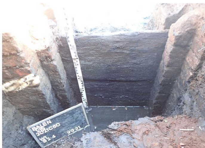
Figuur 15: Foto van houten schot (S1002) tussen bakstenen muur S1003 (© J. Verrijckt)
