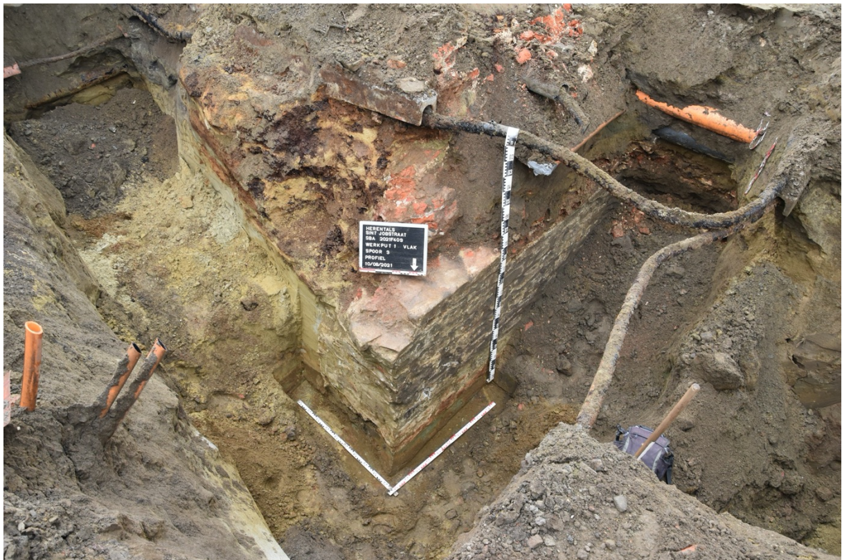
Fig. 2.8: Noordoostelijke hoek van S3 met de kalkstenen “wang” waarboven in baksteen werd verder gewerkt en de achterliggende opvulling in ijzerzandsteen.
