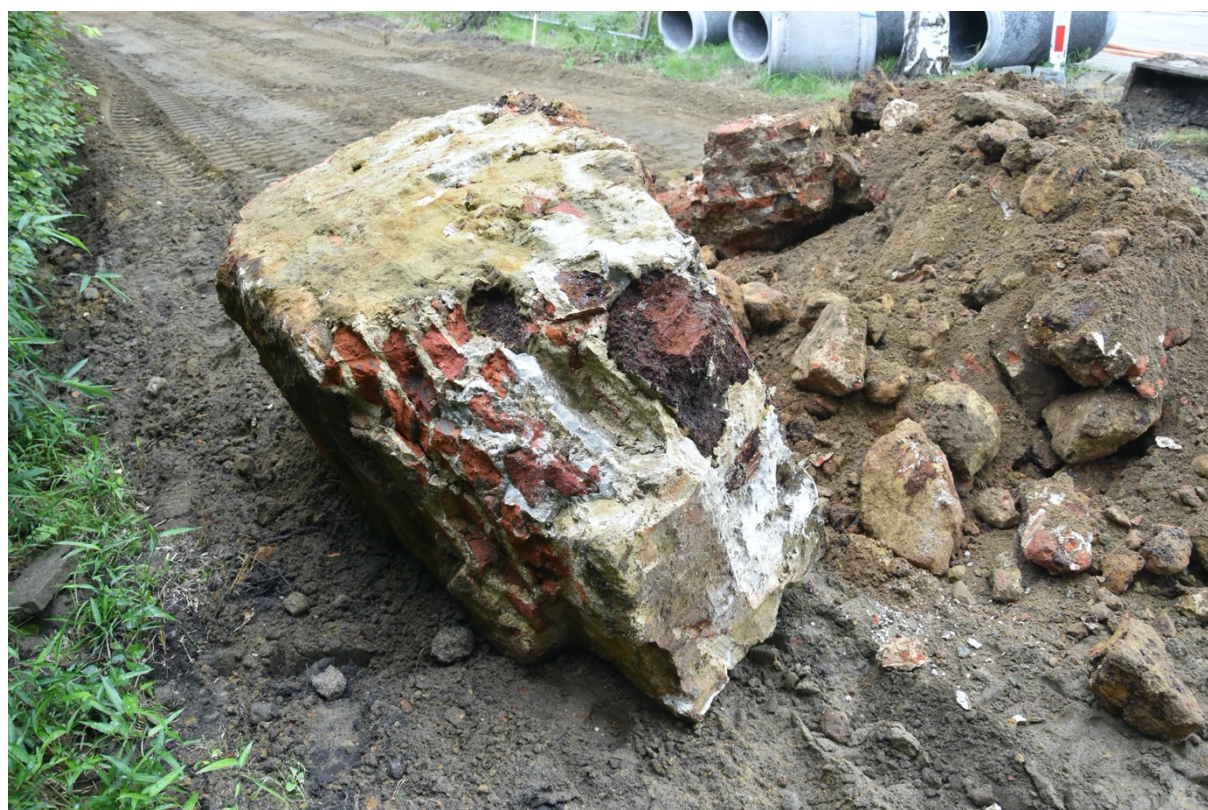
Fig. 2.11: Verzameling uitgebroken fundering.
