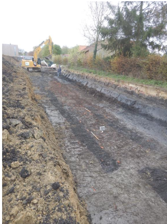
Figuur 40: Overzichtsfoto's vlak 2 in werkput 1. Op deze foto zijn de lineaire sporen of greppels duidelijk zichtbaar (© ARCHEBO bvba, 2019).
