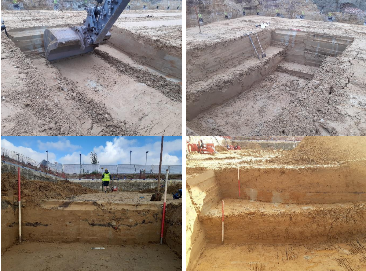
Figuur 6: Foto's genomen tijdens fase 3, het graven van de 10 werkputten. Bovenaan: getrapte uitgraving in werkput 1. Rechtsonder: Uitgraven van WP 6. Linksonder: getrappt profiel in werkput 5.
