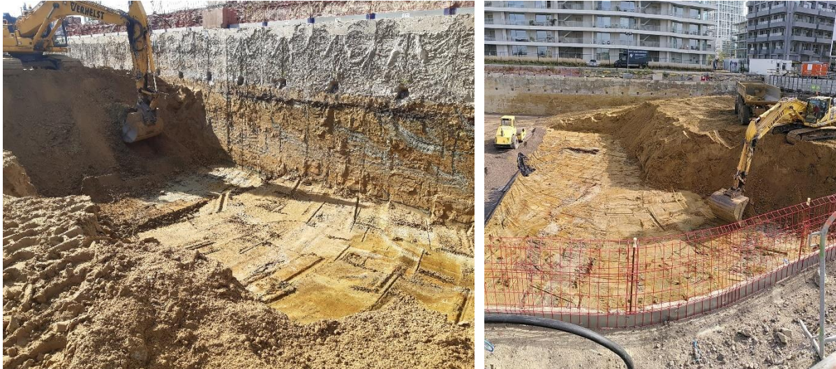
Figuur 7: Foto's genomen tijdens fase 4, het begeleiden van het uitgraven van het diepste niveau van de bouwput.
