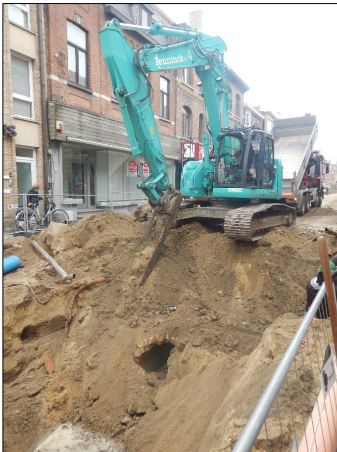
Figuur 5: Zicht op de impact van de recente verstoringen bij de aanleg van het archeologisch vlak ter hoogte van de Marktstraat.
