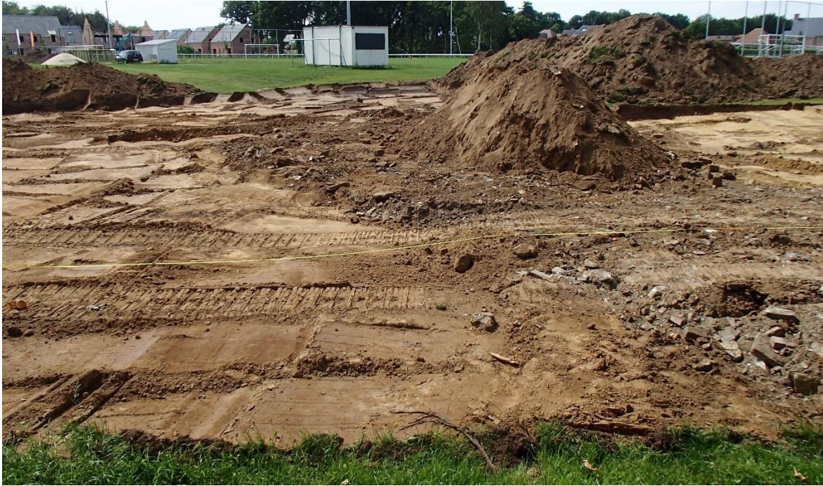
Figuur 27. Puinbaan ter hoogte van boringen B56 en B62.
