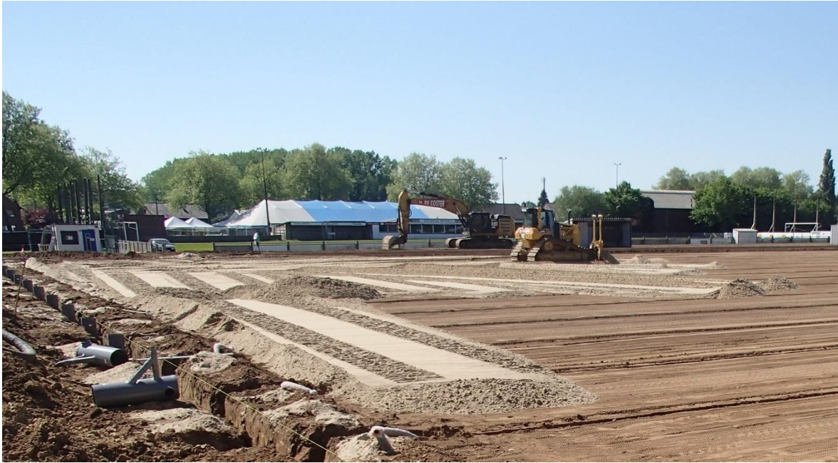
Figuur 10. Ophoging terrein met zand door middel van een bulldozer op rupsbanden.
