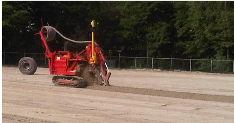
Figuur 8. Voorbeeld van een lichte draineermachine op rupsbanden met laseraansturing (© Boersma Drainage Bedrijf)
