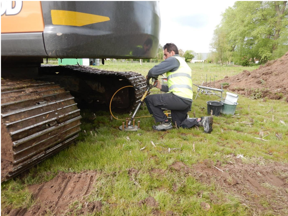
Figuur 12: fotografische opname van de uitvoering van de plaatproef in het noorden van het projectgebied
