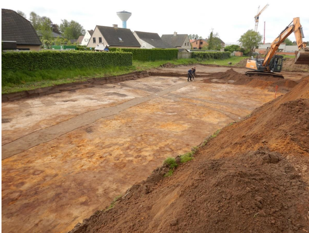
Figuur 23: fotografische opname tijdens de aanleg van werkput 3
