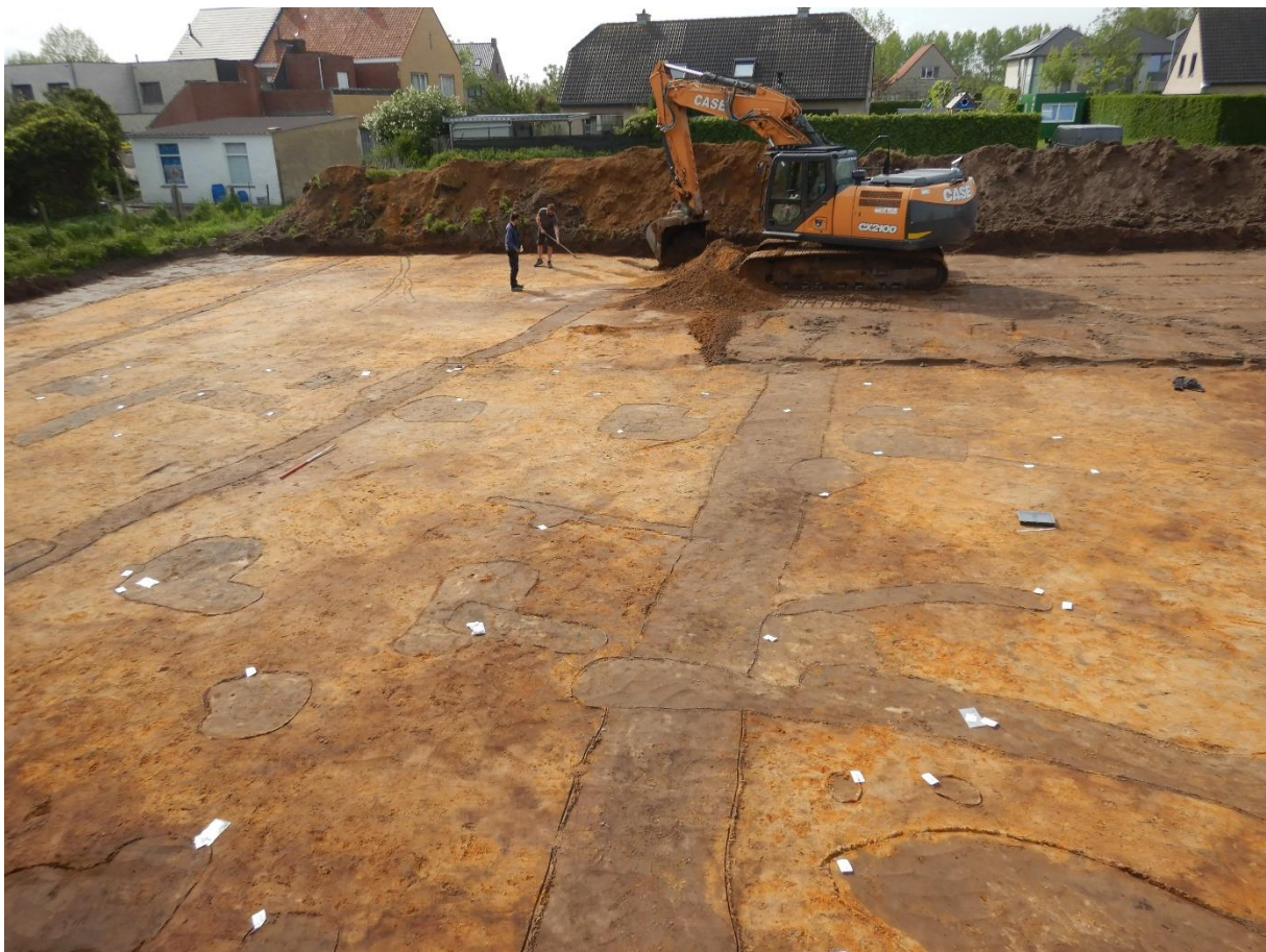
Figuur 73: fotografische opname van de aanleg van werkput 4
