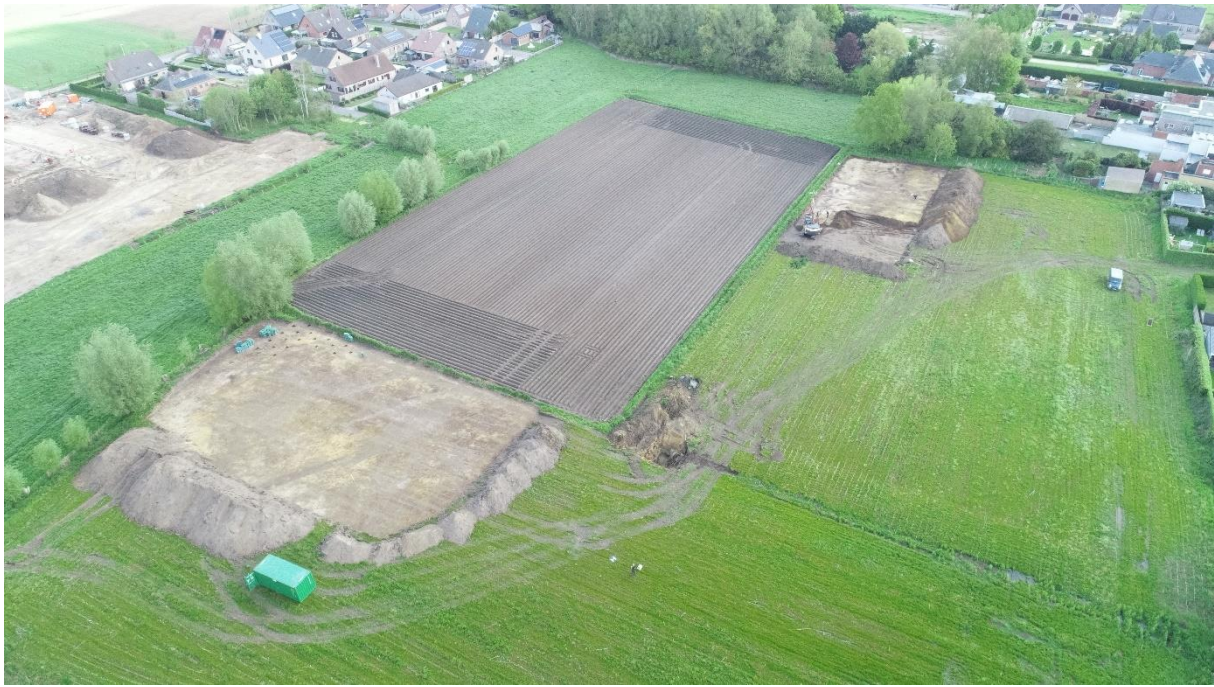
Figuur 68: fotografische opname van de aanleg van werkput 2 en testvakkenfase 1 binnen werkput 1 binnen het projectgebied.
