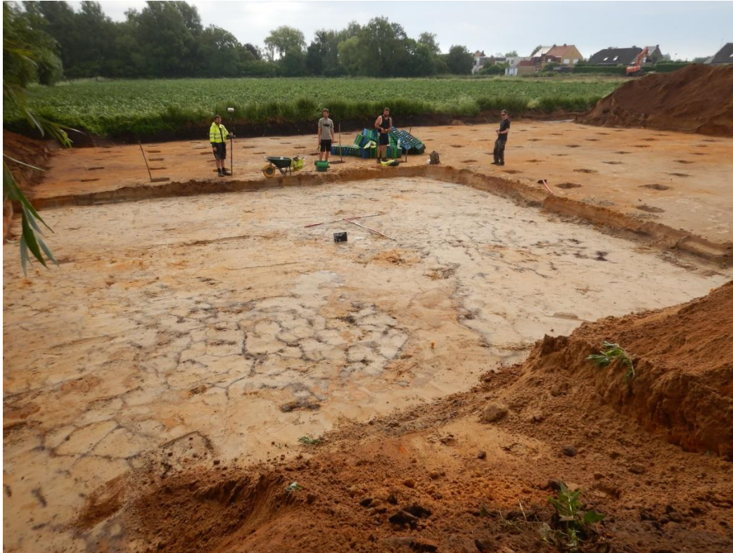
Figuur 18: Zicht op testvakkenfase 3 en het aangelegde vlak voor fase 3
