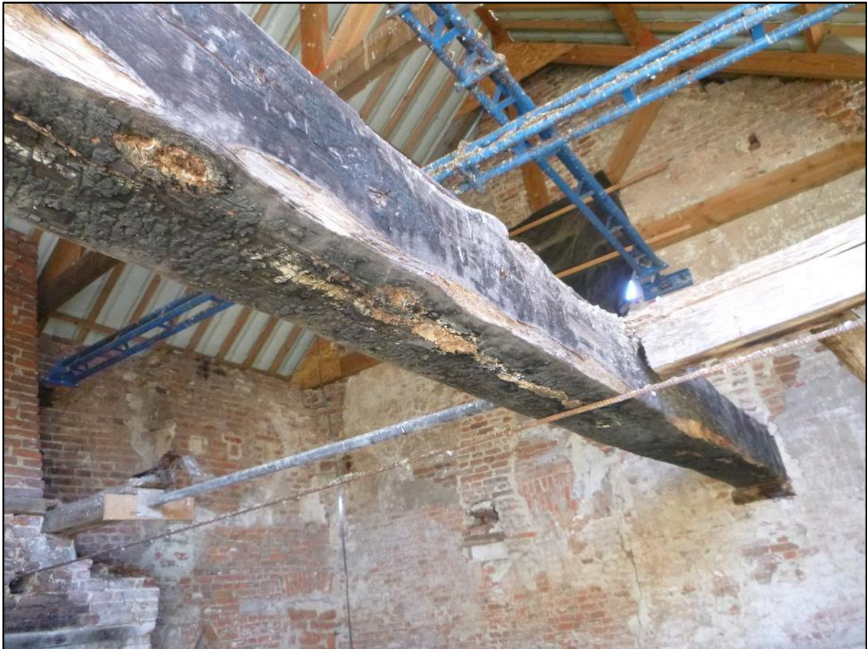
Figuur 81: Bewaarde moerbalk in de ontvangst-/keukenruimte (ABO nv 2020)
