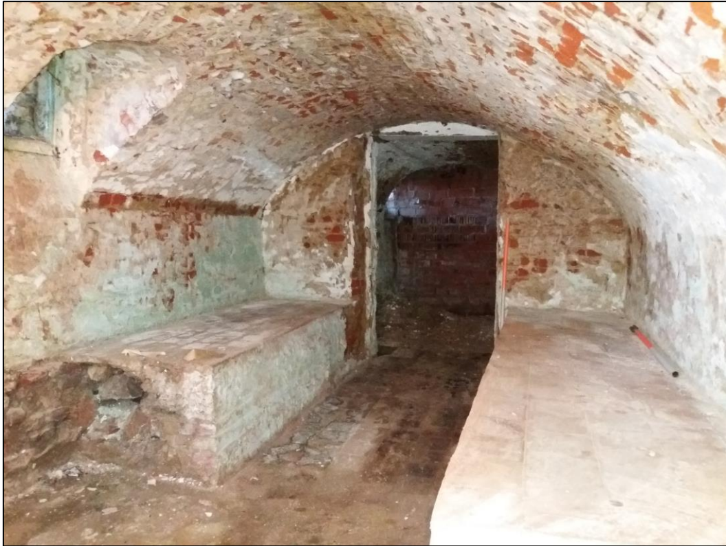
Figuur 44: Overwelfde huiskelder in het noordwestelijke deel van het woonhuis (ABO nv 2020)
