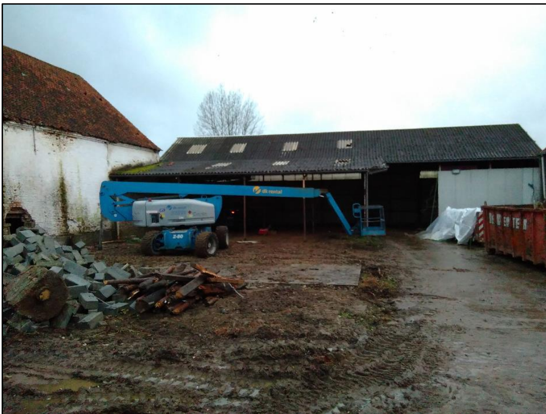
Figuur 19: Recente opname van de nieuwe loods tijdens de sloop in 2019 ter hoogte van de voormalige vleugel vanuit het oosten (ABO nv 2019)
