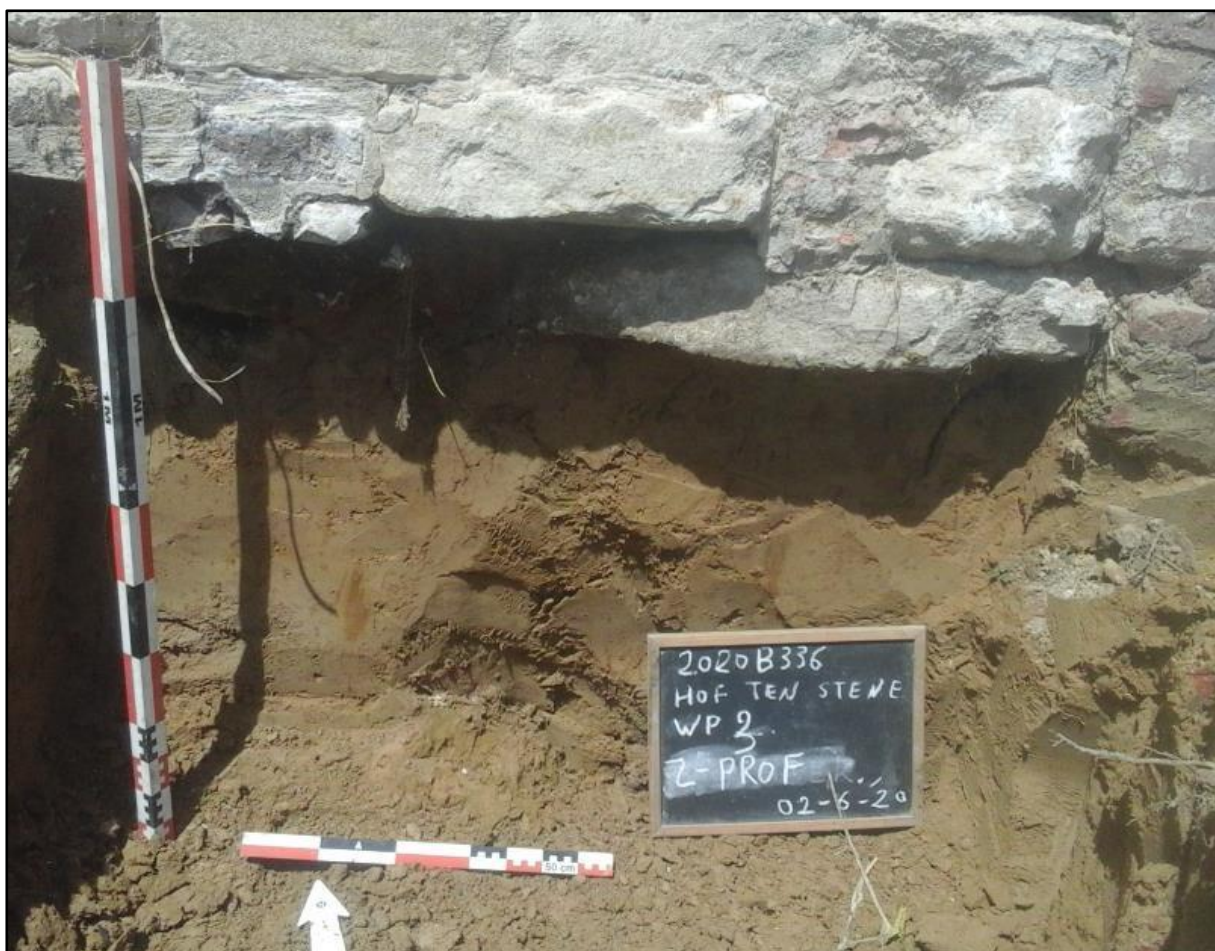
Figuur 66: Fundering ter hoogte van de buitenzijde van de zuidgevel van de woontoren (ABO nv 2020)
