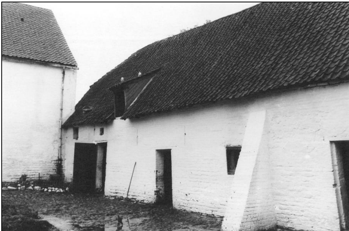
Figuur 18: Historische opname van de voormalige vleugel vanuit het noordoosten met links de schuur (Opdrachtgever)
