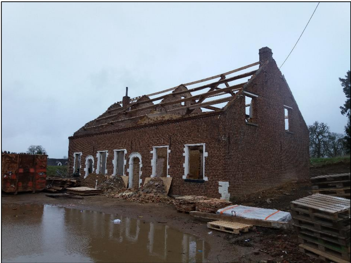
Figuur 40: Actuele toestand van het woonhuis in voorjaar 2020 (ABO nv 2020)
