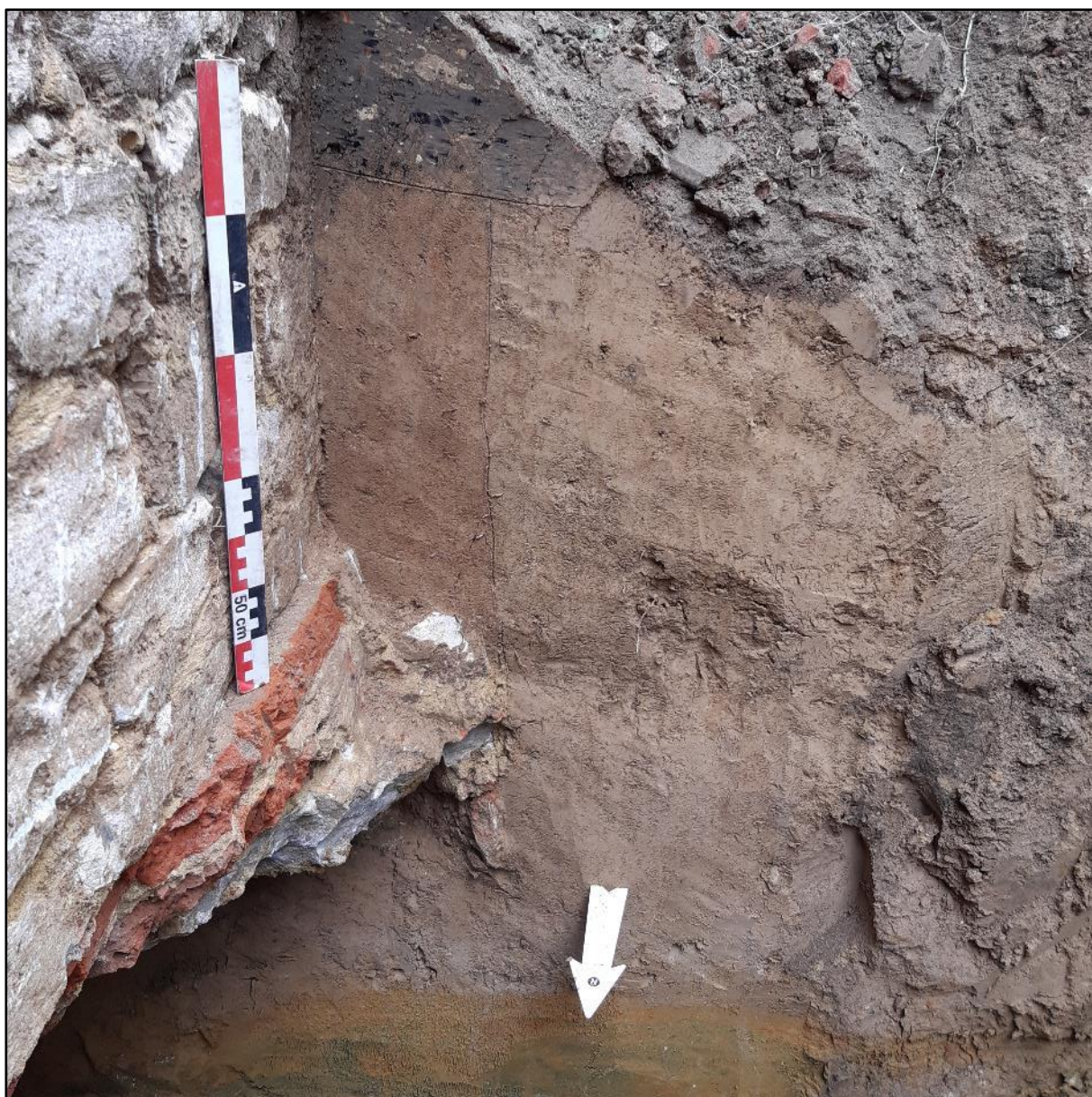
Figuur 71: Aanleg sleuf voor de aanleg van de fundering westgevel (ABO nv 2020)
