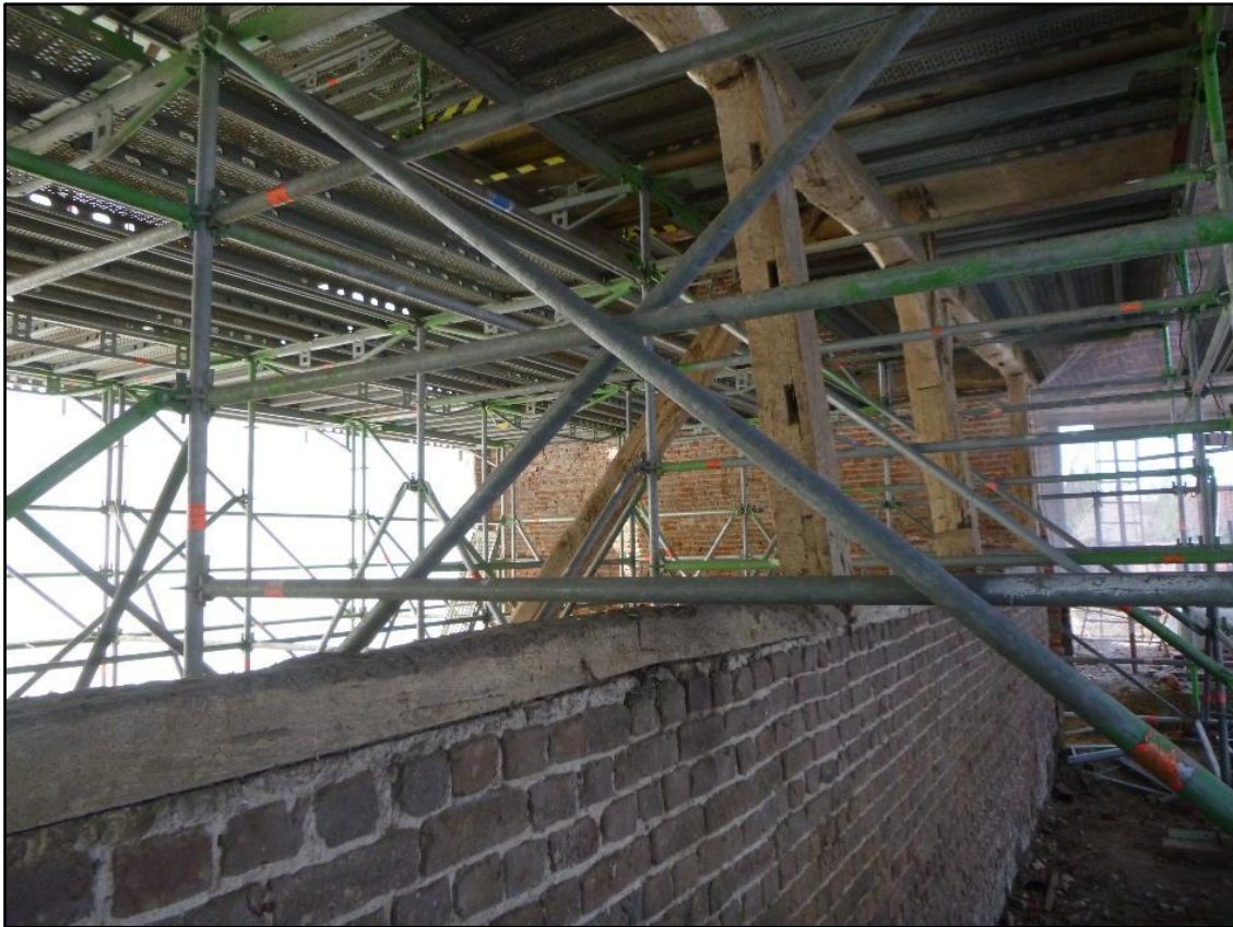
Figuur 32: Scheidingsmuur tussen “deel” en stapelruimte met opstaande gebintstijlen (ABO nv 2020)
