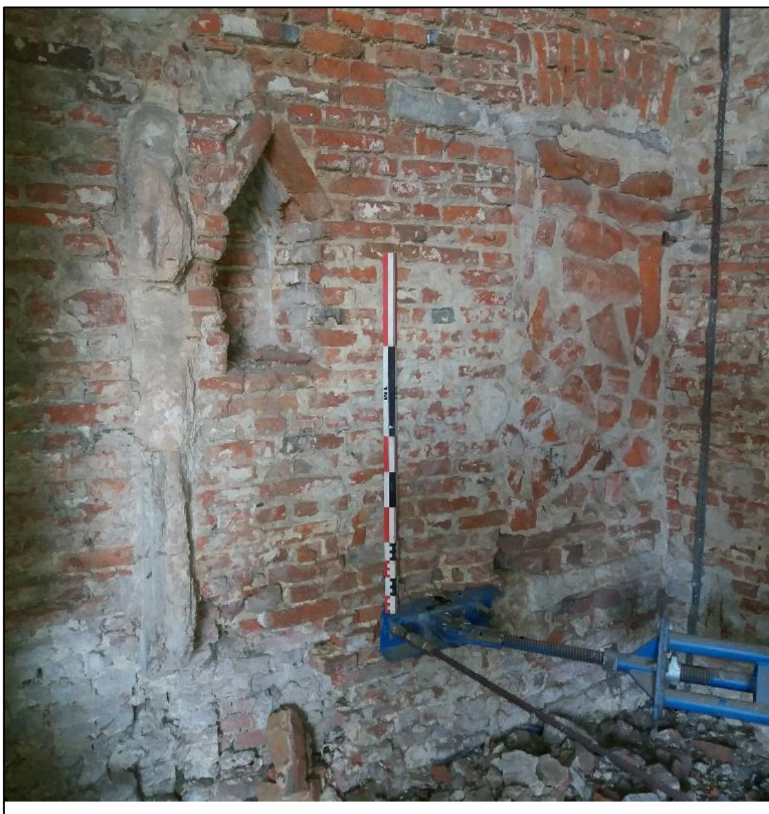
Figuur 76: Restant haardwang, kaarsnis met keperboog en dichtgemetselde raamopening (ABO nv 2020)
