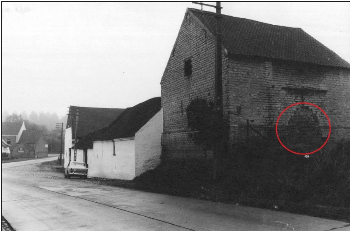
Figuur 84: Het Hof ten Steene in 1971 met de woontoren met aanduiding van de dichtgemetselde opening in de noordgevel in functie van de bouw van een bakoven (Agentschap Onroerend Erfgoed)
