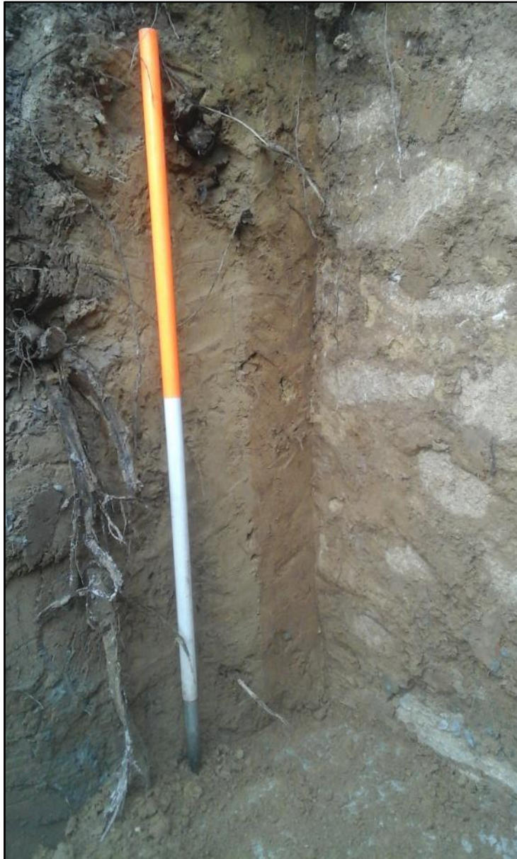
Figuur 72: Aanleg sleuf voor de aanleg van de noordelijke gevel (ABO nv 2020)
