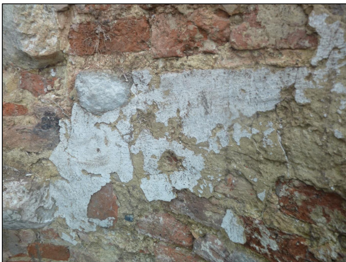
Figuur 95: Detail bewaarde kalkmortelpleister met kalkwitsel-afwerking aan de binnenzijde trapkoker-restant (ABO nv 2020)
