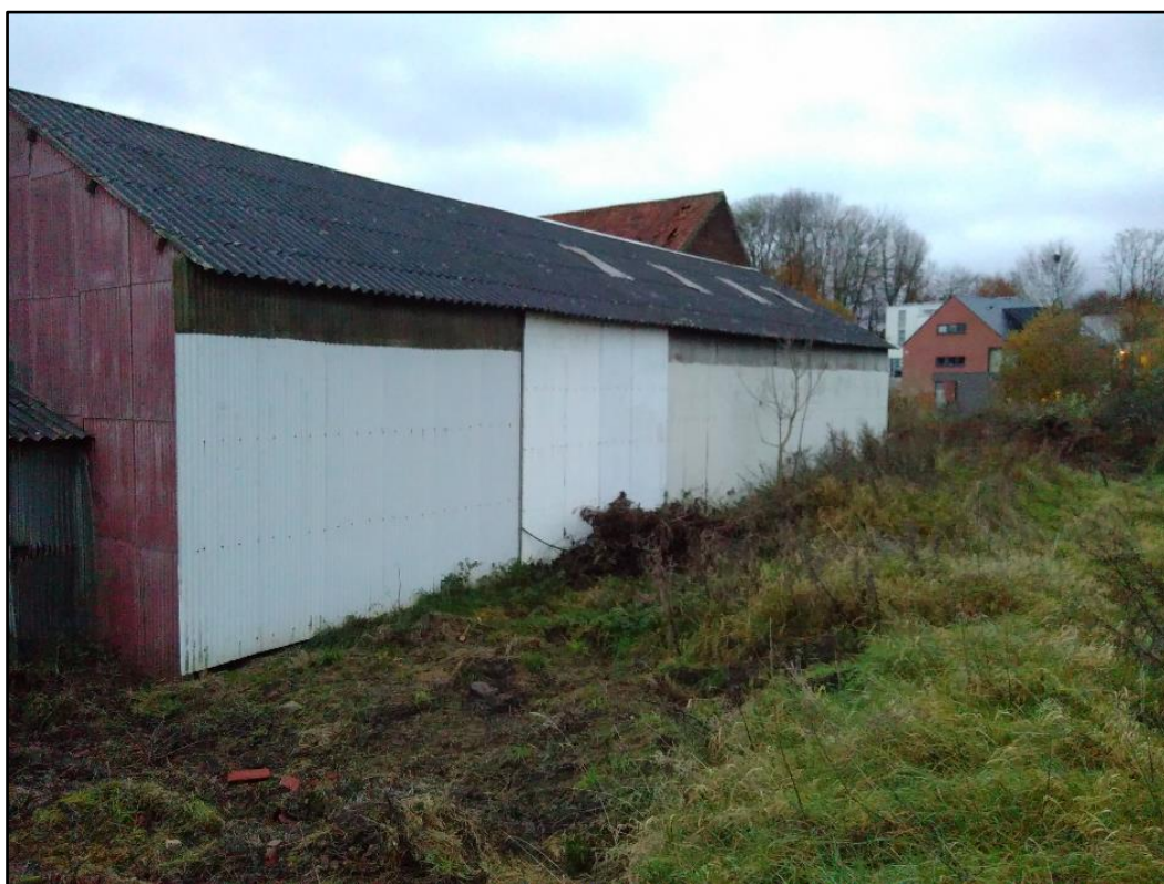
Figuur 20: Recente opname van de loods en kunstmatige berm vanuit het westen (ABO nv 2020)
