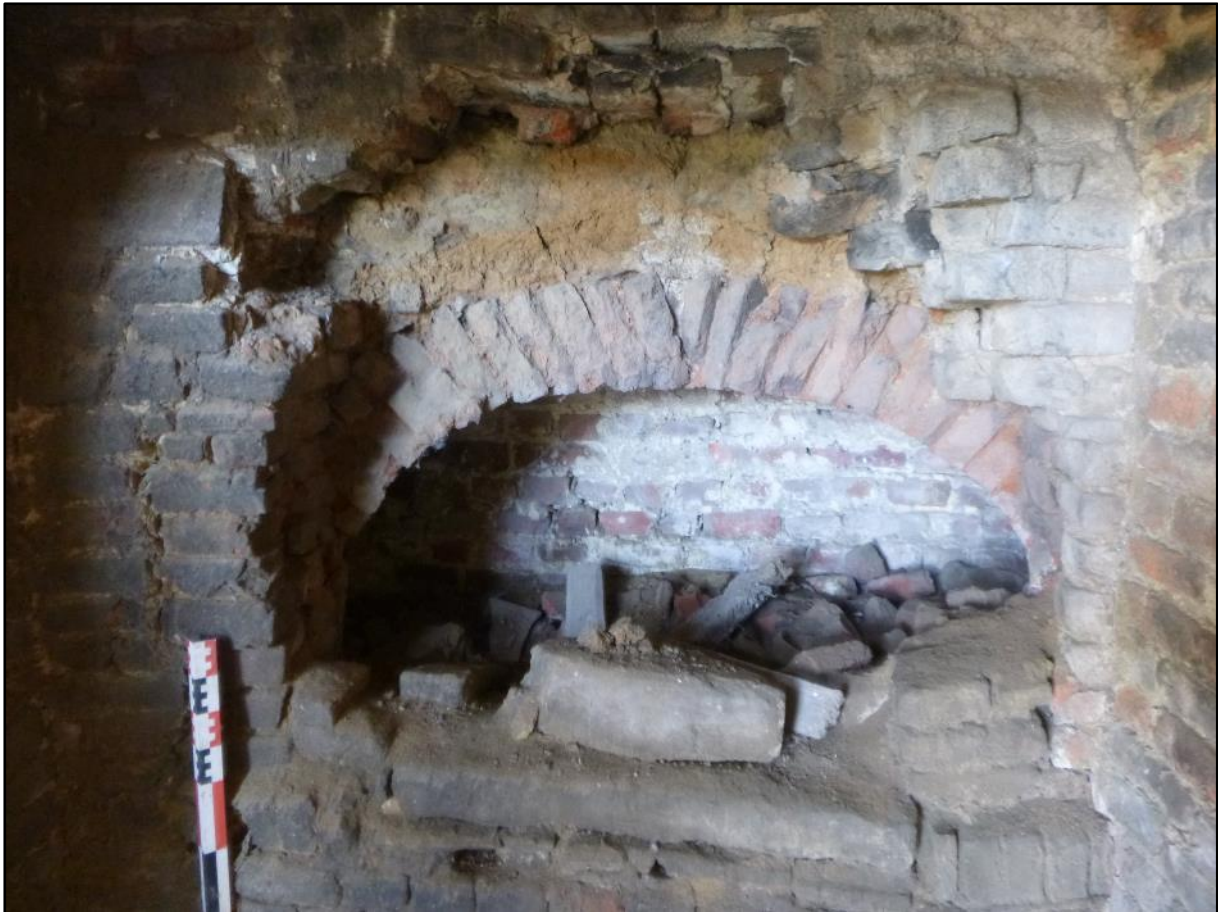
Figuur 83: Detail restant bakoven met gewelf en stro-leem isolatielaag en dichtgemetselde rugwand (ABO nv 2020)
