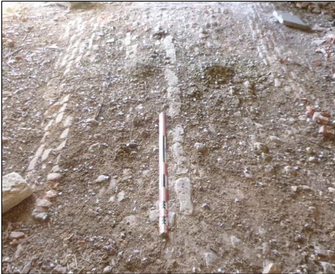
Figuur 80: Bovenaanzicht gewelf met natuurstenen sluitsteenrij (ABO nv 2020)
