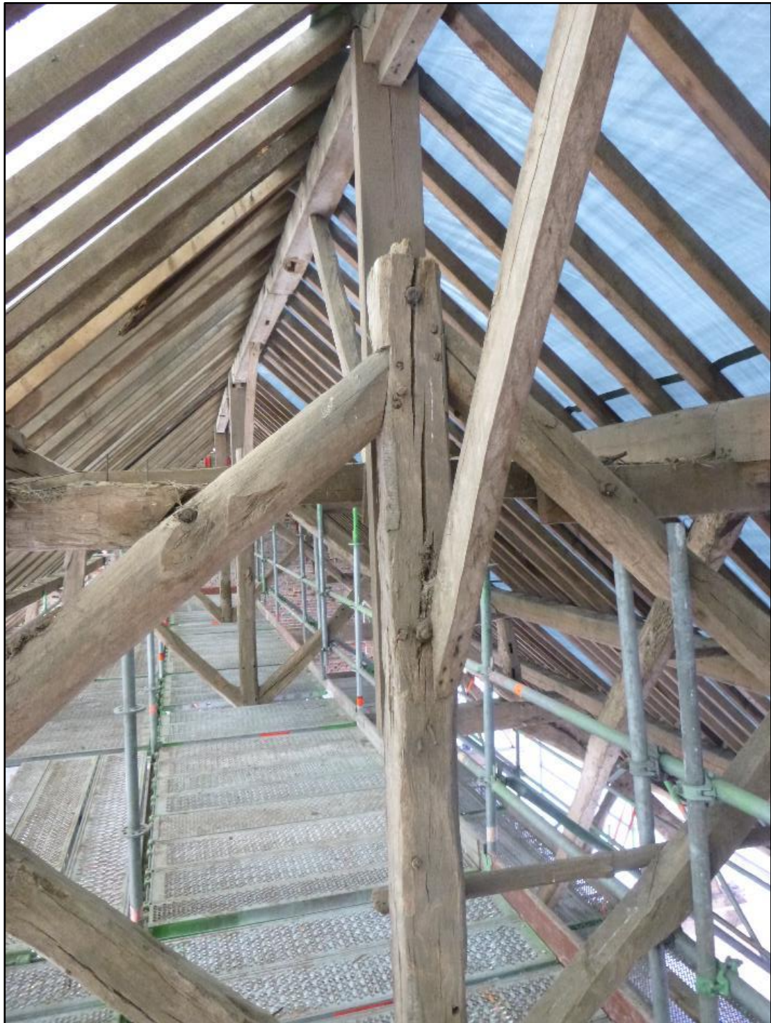
Figuur 31: Bouwsporen ter hoogte van het kagebint in functie van aanpassingen aan de dakhelling: het verlengen van de makelaar in functie van het verhogen van de nok (ABO nv 2020)
