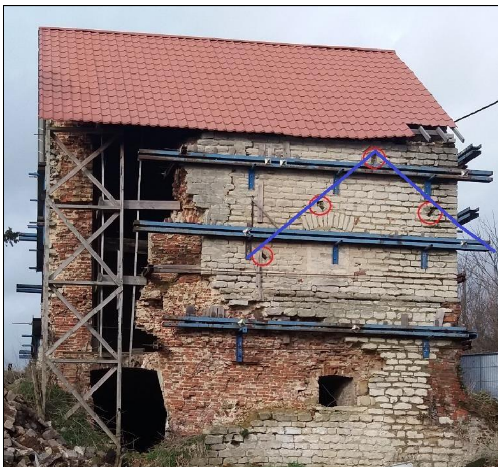
Figuur 79: Dichtgemetselde raamopening aan de buitenzijde van de oostgevel en sporen van het inwerken van de kapgordingen (rood en paars) (ABO nv 2020)
