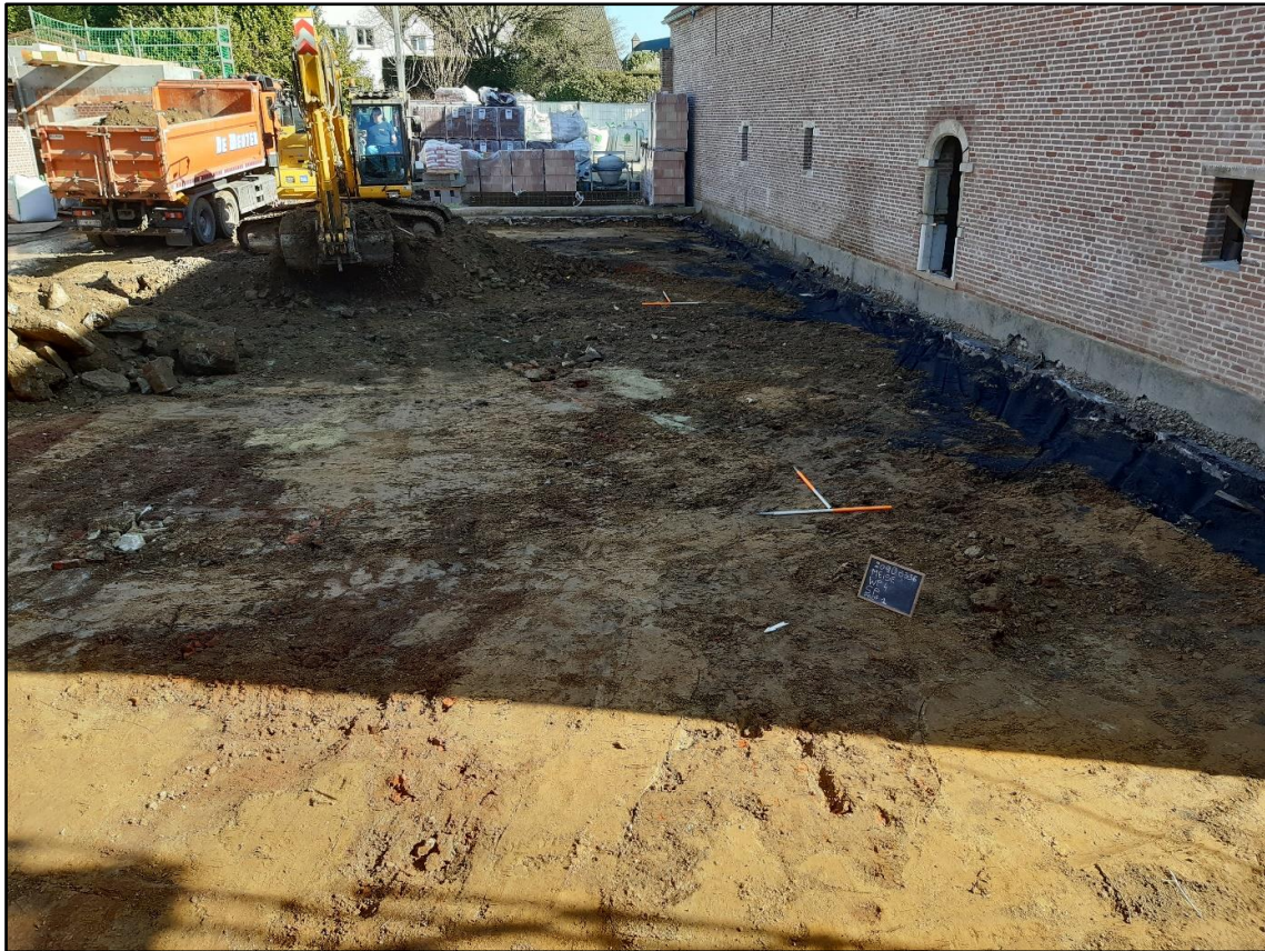
Figuur 22: Algemeen zicht op de aanleg vlak van het binnenplein (ABO nv 2021)
