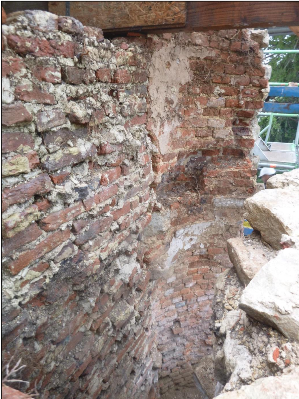
Figuur 92: Algemeen zicht op de binnenzijde van het trapkoker-restant gezien vanuit het oosten (ABO nv 2020)
