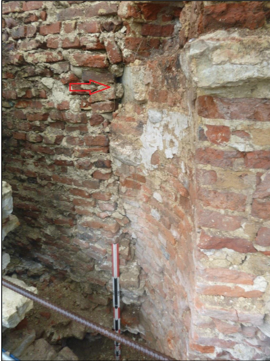
Figuur 91: Algemeen zicht op de binnenzijde trapkoker-restant verborgen achter parement van de noordelijke gevel, later opvulmetselwerk na afbraak van de trapkoker én restant traptrede (rode pijl) (ABO nv 2020)
