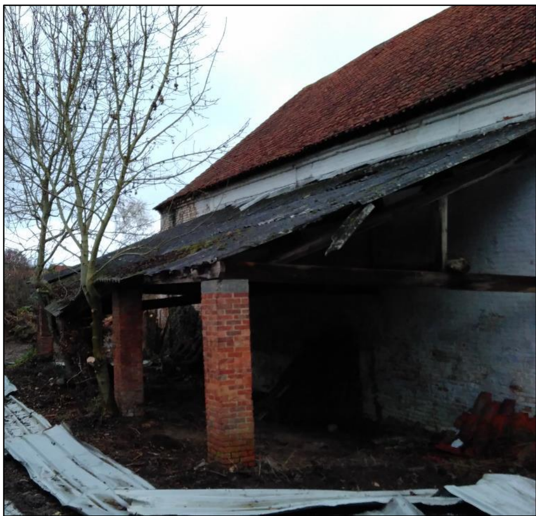
Figuur 37: Fotografische opname van het afdak op bakstenen poeren tijdens de sloop in 2019 (ABO nv 2020)
