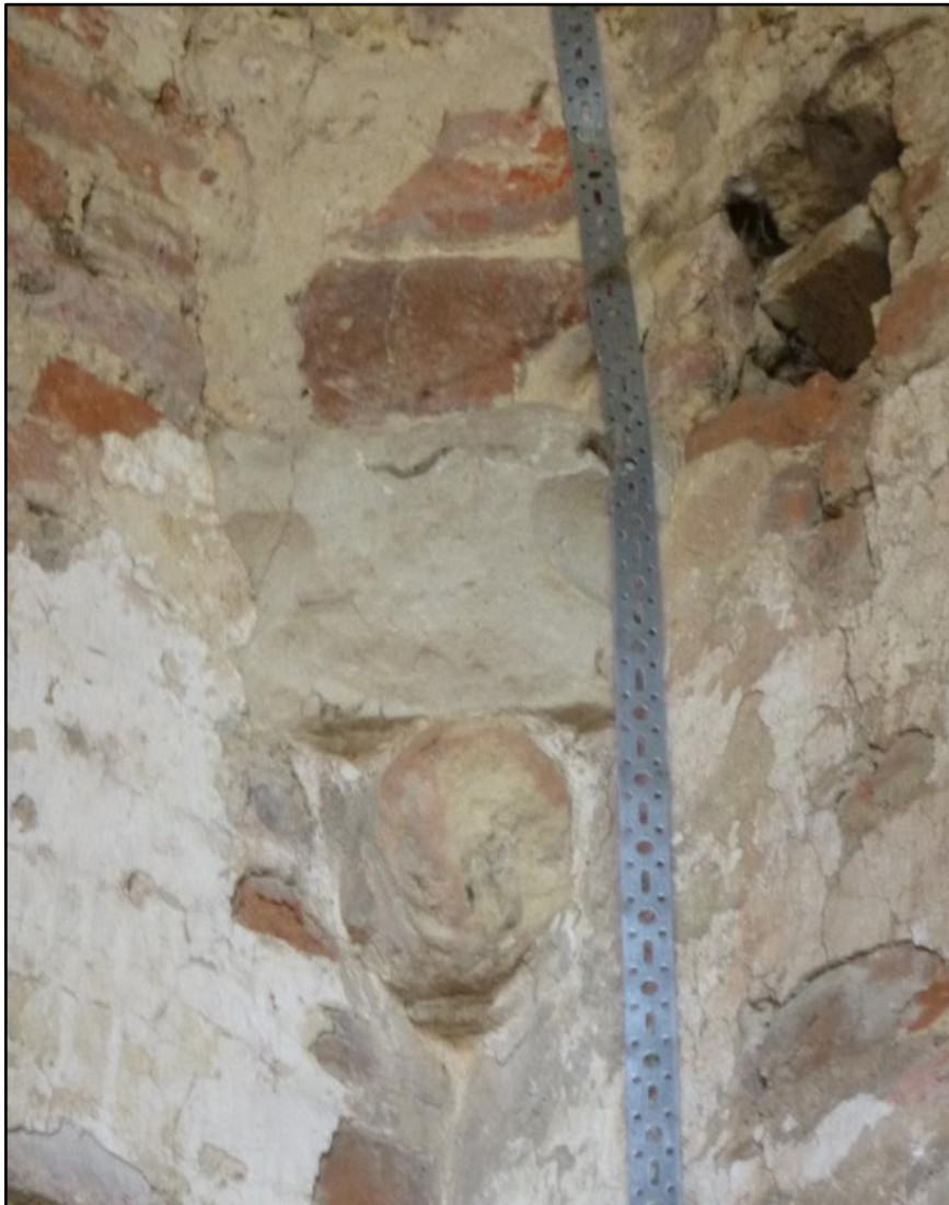
Figuur 75: Restant aanzet kruisribgewelf (ABO nv 2020)
