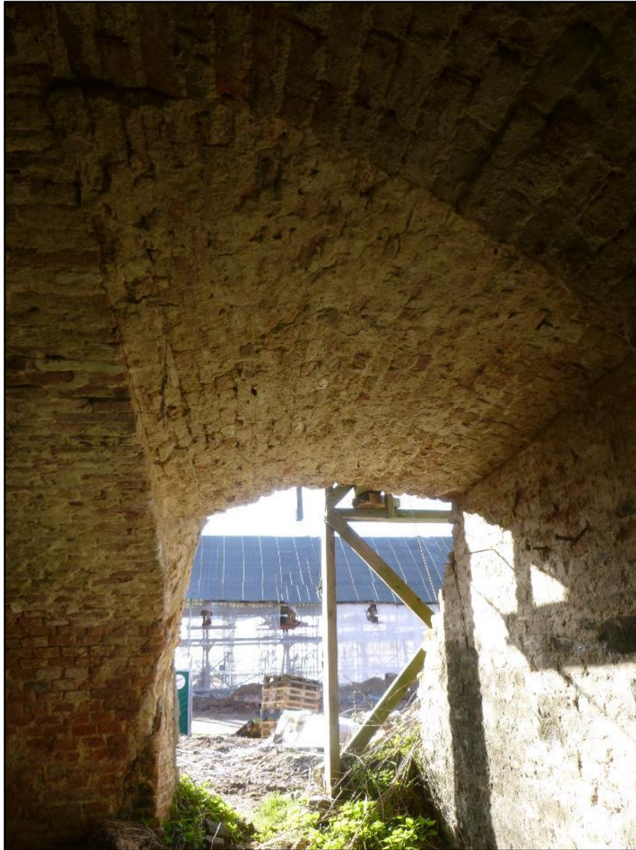
Figuur 73: Dichtgemetselde “val” in de kelder (ABO nv 2020)
