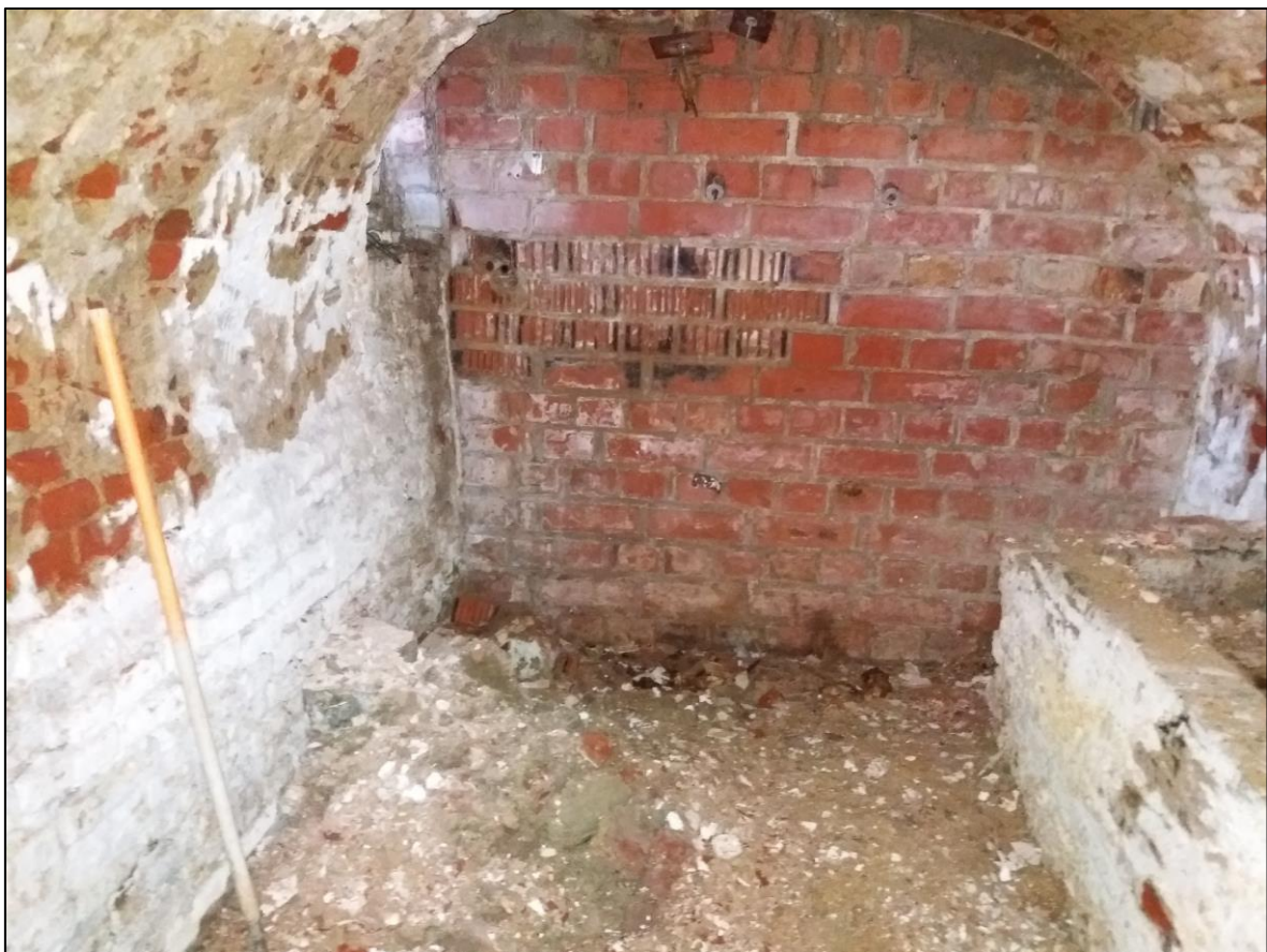
Figuur 45: Dichtgemetselde doorgang in oostelijke richting van de overwelfde huiskelder (ABO nv 2020)
