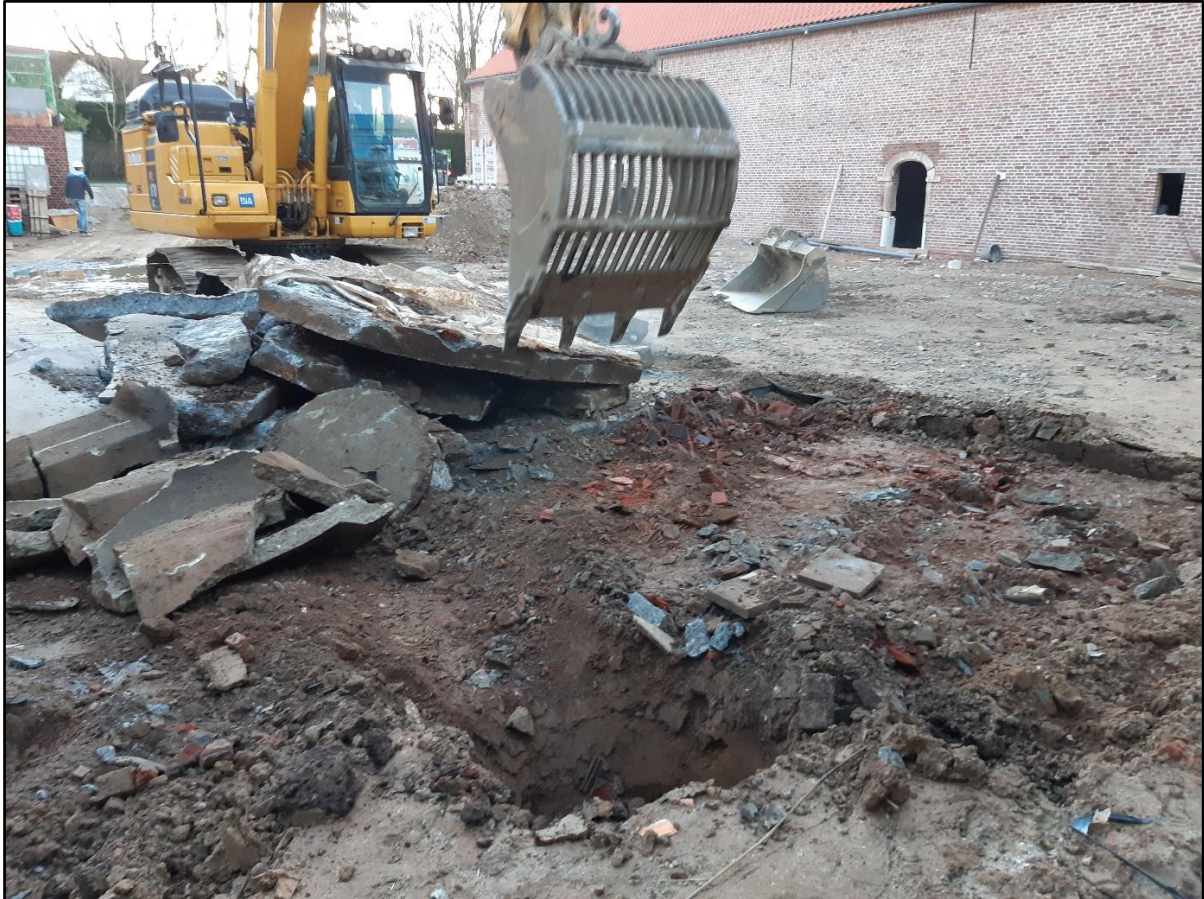
Figuur 21: Aanvang verwijderen betonverharding van de voormalige loods (ABO nv 2021)
