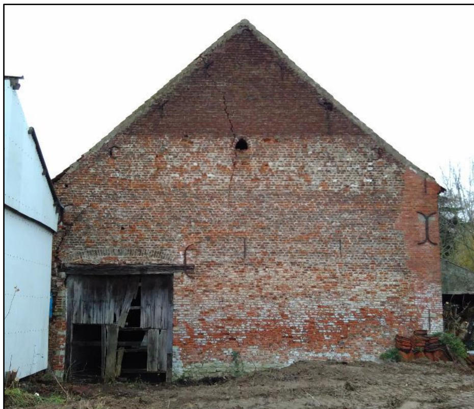
Figuur 33: Bouwsporen ter hoogte van de eindgevel in functie van aanpassingen aan de dakhelling (ABO nv 2020)
