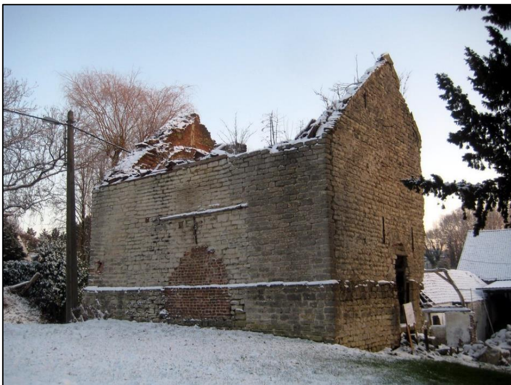
Figuur 85: Recente winteropname van de noordzijde van de donjon met duidelijk zichtbaar de dichtgemetselde opening en de horizontale houten balk (Flickr.com)
