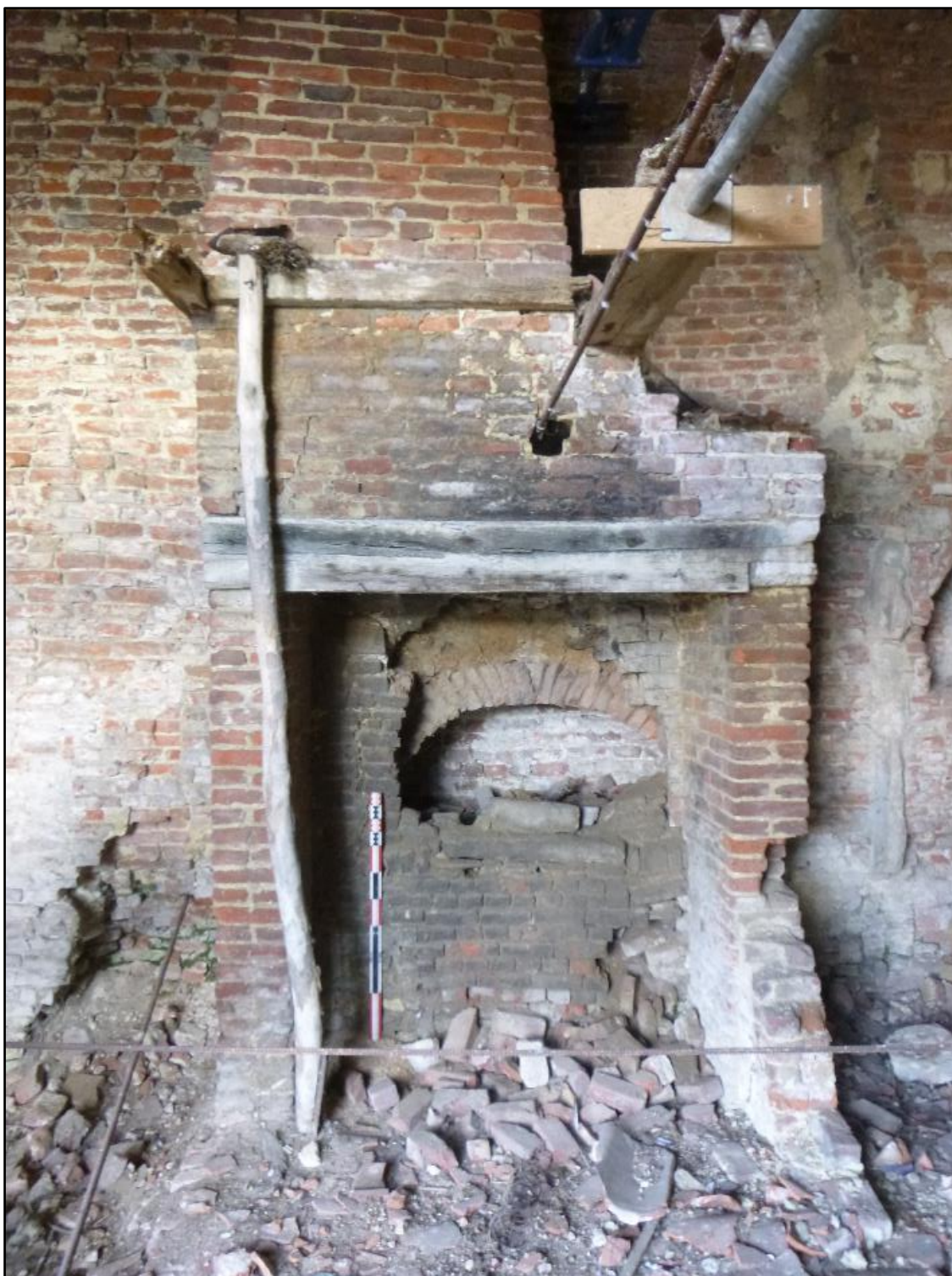
Figuur 82: Algemeen vooraanzicht op de jonger toegevoegde bakoven met rookvang en schouwboezem (ABO nv 2020)
