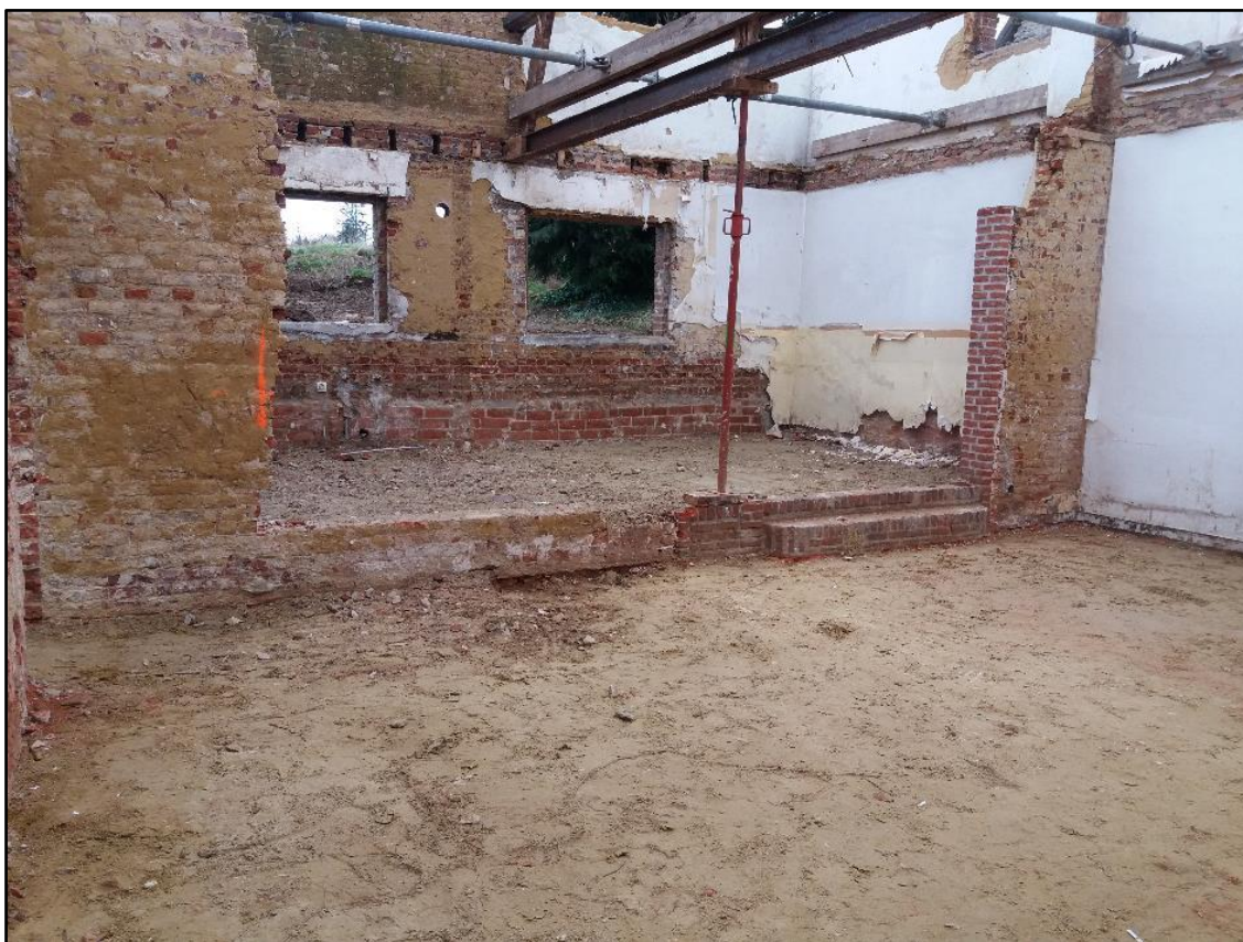
Figuur 46: Het interieur tijdens de werkzaamheden (ABO nv 2020)
