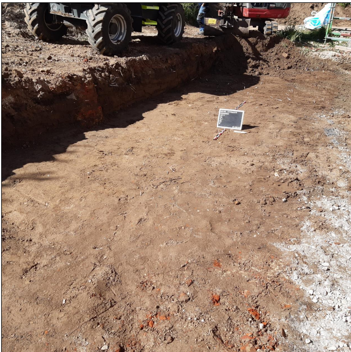
Figuur 35: Algemeen zicht op de bouwput met geheel achteraan rechts de beide bakstenen poeren (ABO nv 2020)
