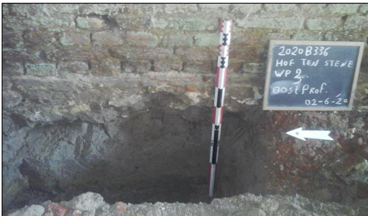
Figuur 67: Fundering ter hoogte van de binnenzijde van de oostgevel van de woontoren (ABO nv 2020)
