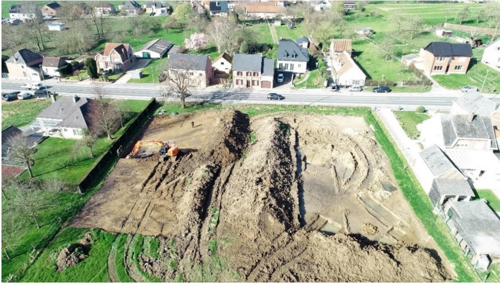
Figuur 8: dronefoto van het systeem van aanleg van werkputten.
