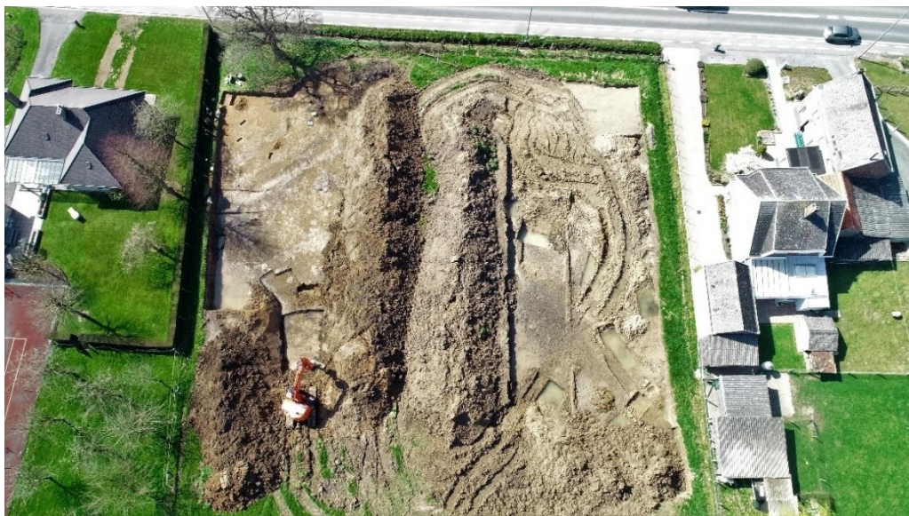
Figuur 82: opname van het projectgebied met kraan bezig met de aanleg van werkput 3.
