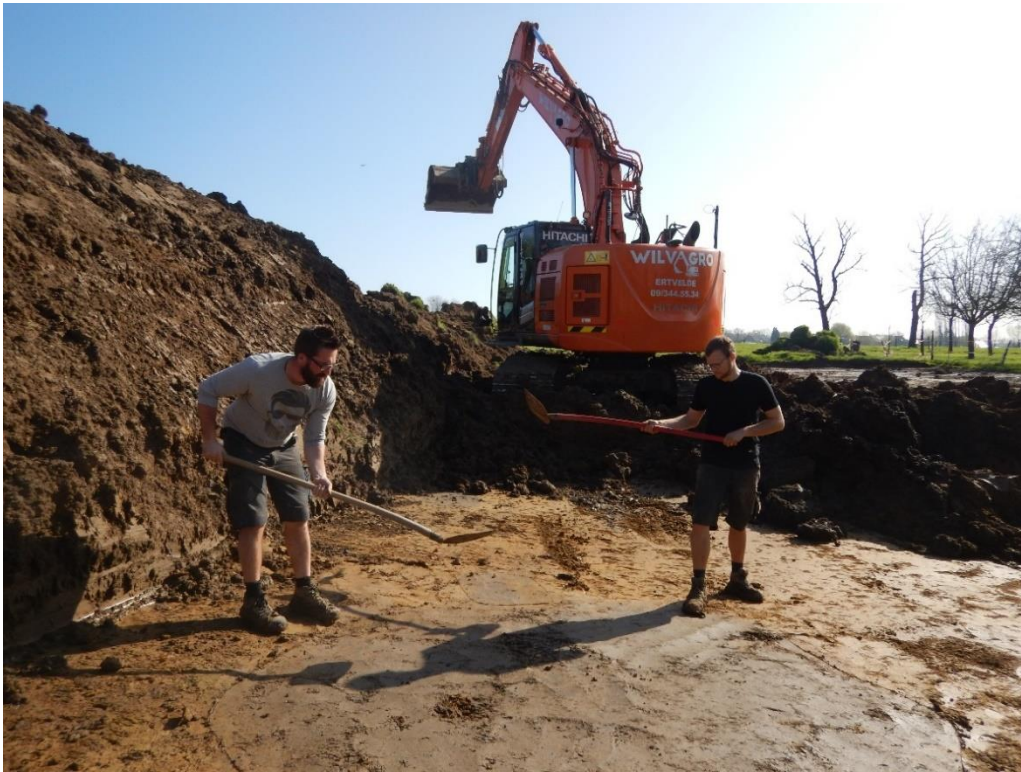
Figuur 9: fotografische opname tijdens de aanleg van werkput 1.
